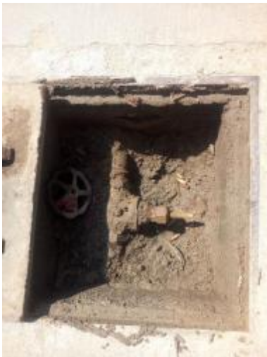
图 5-3-6-4 阀门老坏，封闭性差
