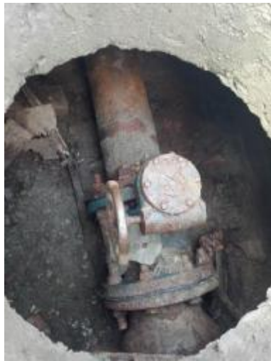
图 5-3-2-4 南方村总供水管 DN250 到 DN200(普通铸铁管)
