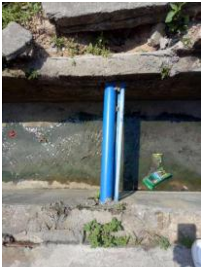
图 5-3-4-9 供水管没有套管
