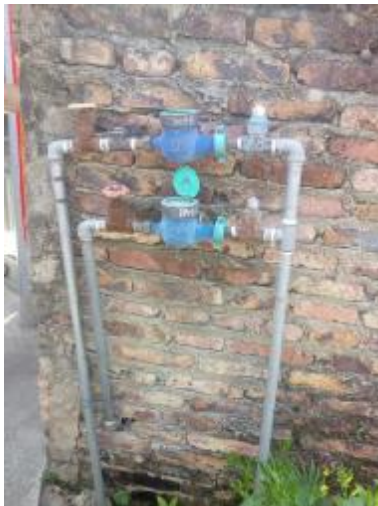
图 5-3-6-5 引入管使用钢管
