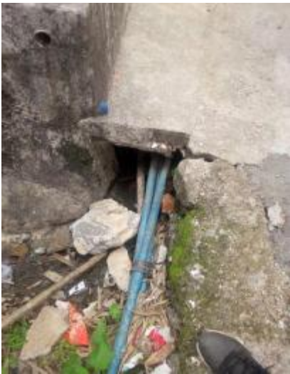
图 5-3-8-9 村内给水管敷设于排水渠内
