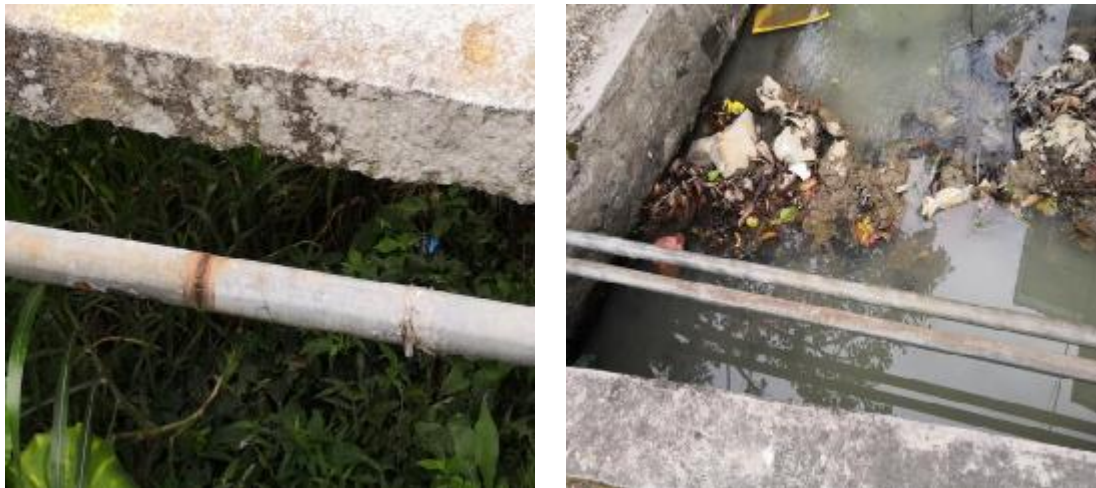
图 3-1-8 管道老坏失修
