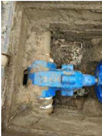
图 5-3-8-6 依锦社进水总管 DN100
