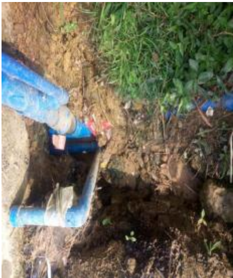
图 5-3-7-6 南𪚘社使用山泉水，DN40 给水管
