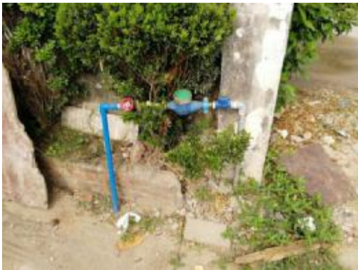
图 5-3-9-5 PVC 管接镀锌钢管
