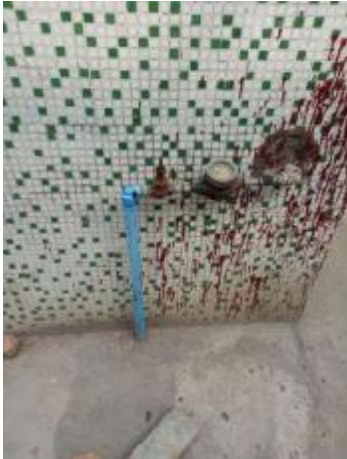
图 5-3-10-5 村民接入给水管有的为 PVC 管
