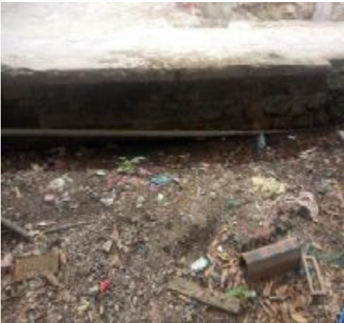
图 5-3-1-7 给水支管敷设于排水渠内
