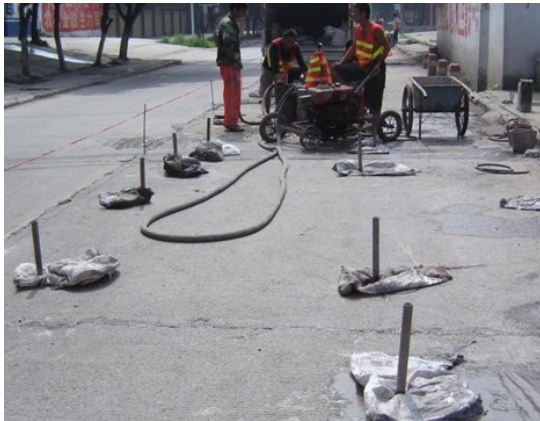
图 4-10 压浆后封孔养生
