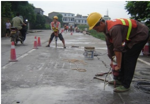
图 4-8 板底压浆人工成孔
