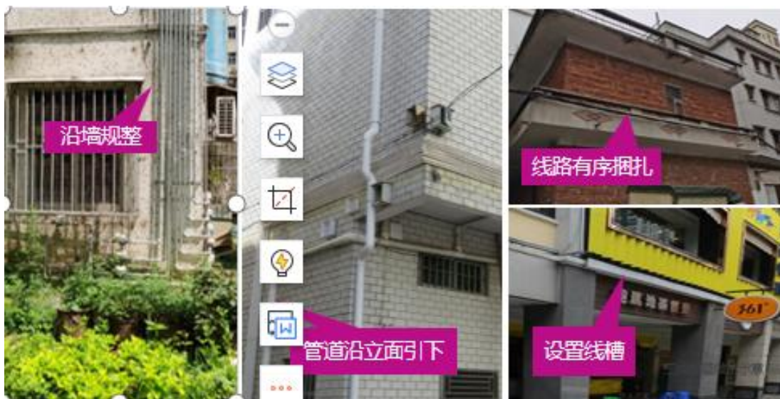
图 5.1-54 三线规整示例图
