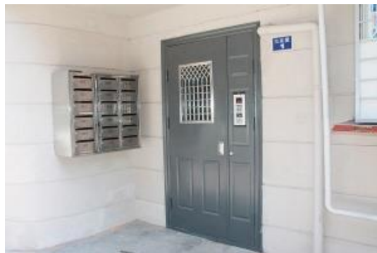
图 5.1-38 楼栋门改造后
