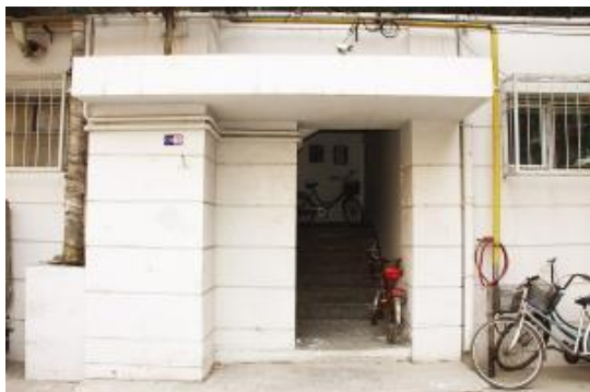
图 5.1-37 楼栋门改造前
