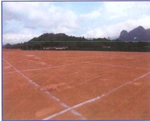
图 2.1-2 画格、分层填筑、压实
