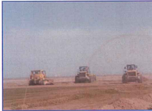
图 2.1-4 推土机粗平
