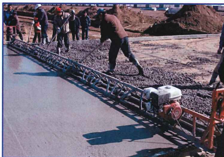
图 2.1-8 水泥混凝土面层施工
