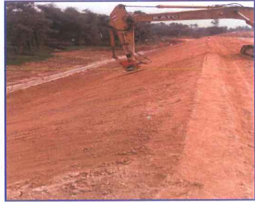
图 2.1-3 边坡拍实机作业
