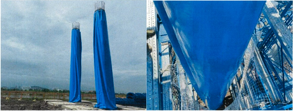
图 2.3.3-13 圆柱墩养生风衣养生
