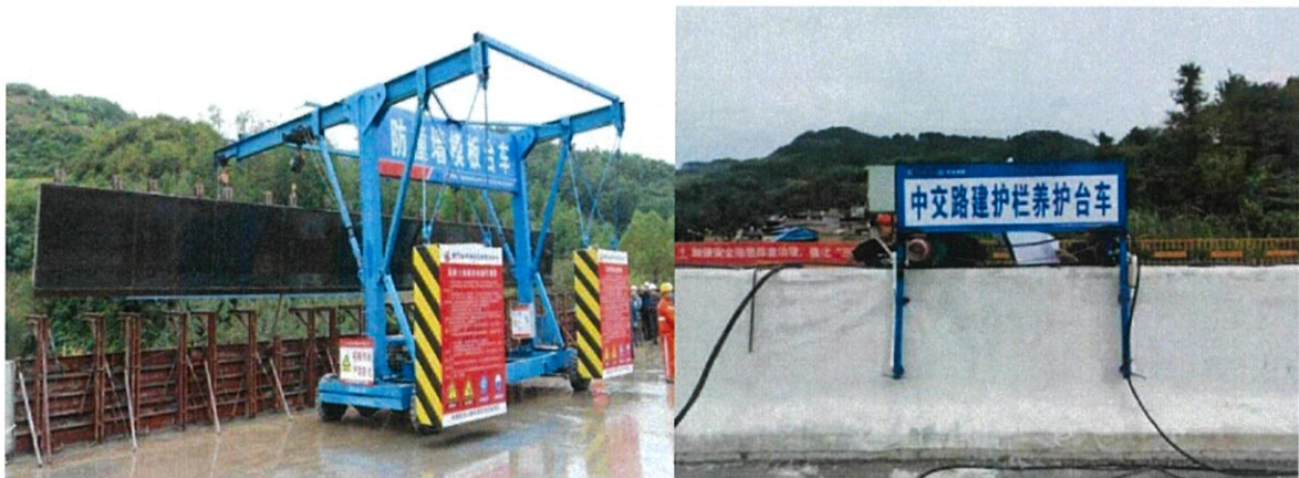
图 2.3.3-22 混凝土护栏施工
