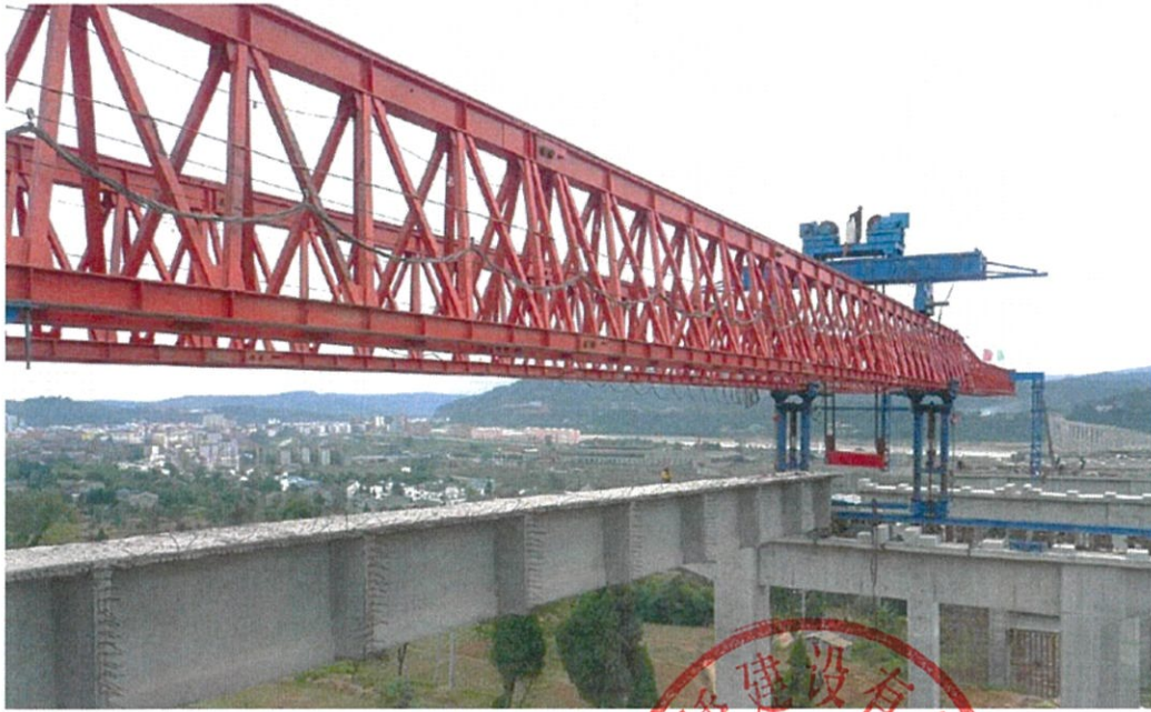
图 2.3.3-18 预制梁架设
