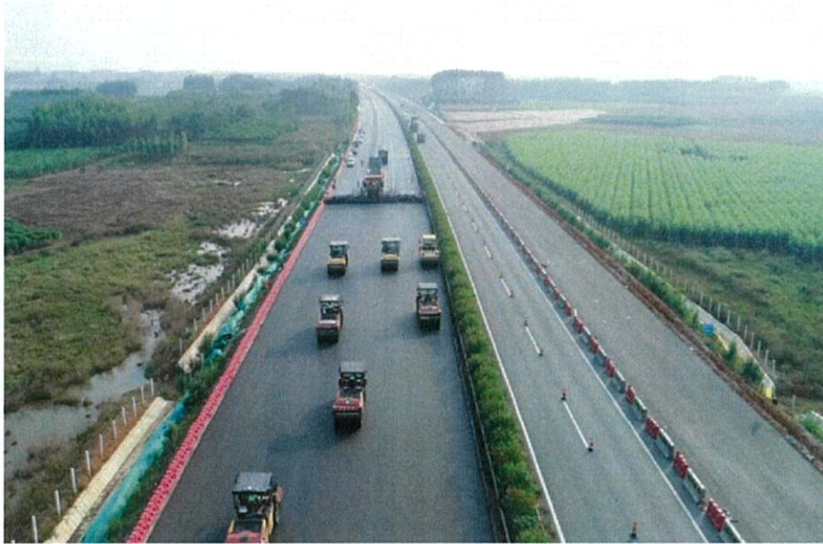
图 2.2.2-14 沥青路面碾压标准化施工
