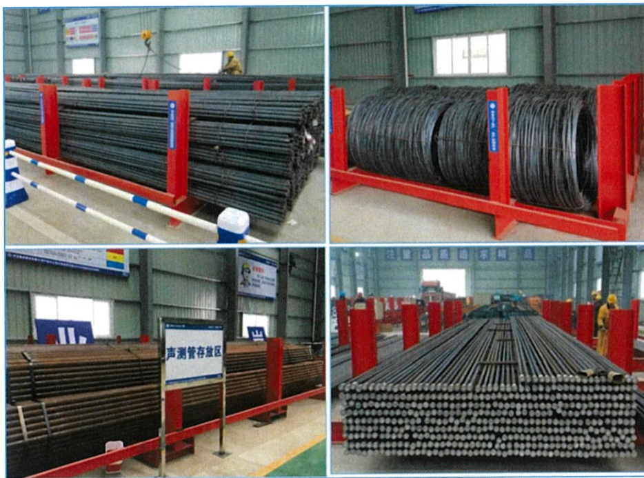
图 7.3.6-1 钢筋材料分区存放整齐
