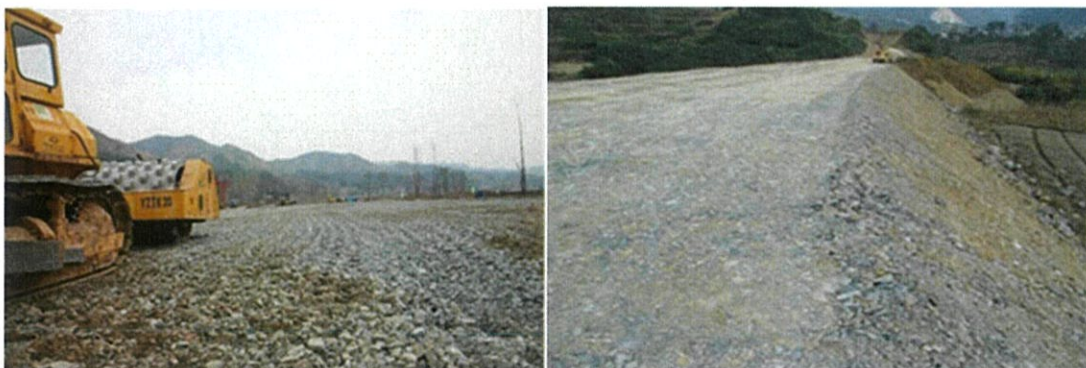
图 2.2.1-7 填石路基施工
