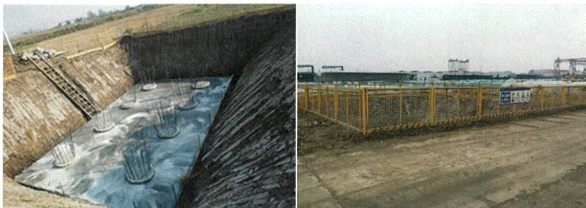
图 2.3.3-8 基坑开挖及防护
