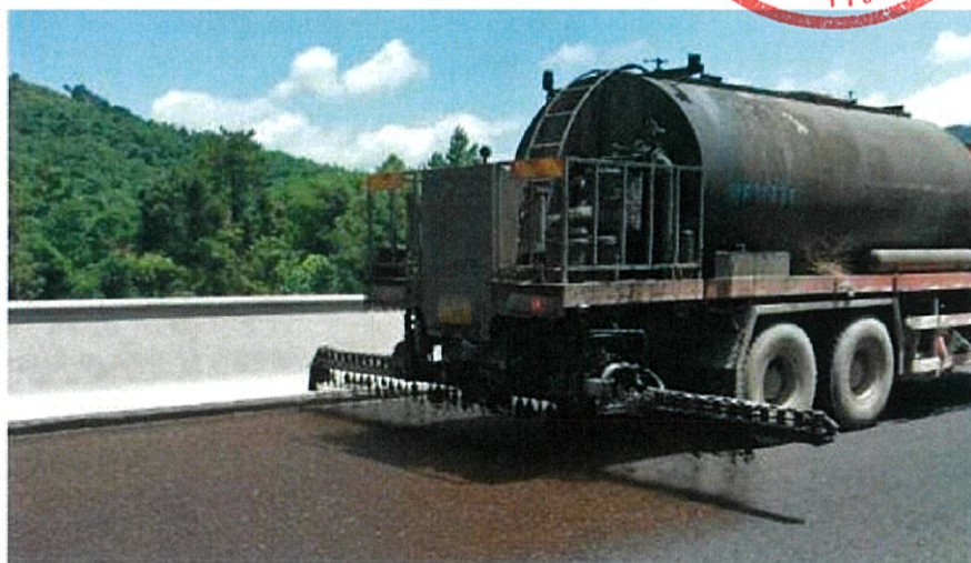
图 2.2.2-9 粘层施工
