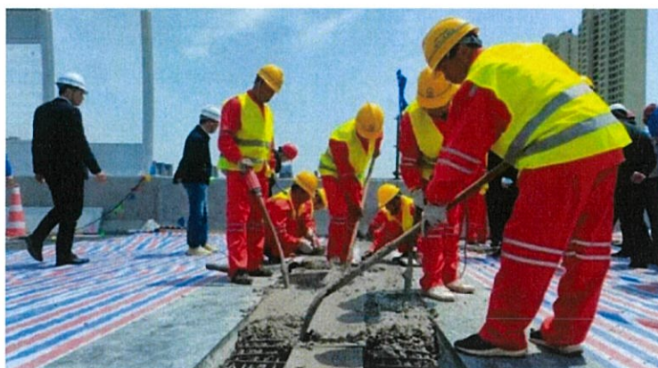
图 2.3.3-24 伸缩缝施工
