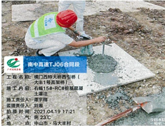
图 2.3.3-5 混凝土坍落度检测
