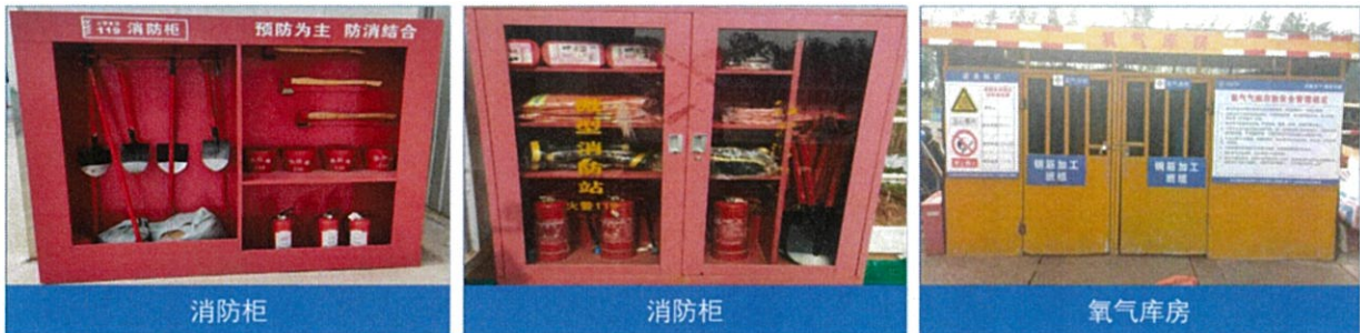
图 7.3.4-2 消防设施规范化示意图（二）
