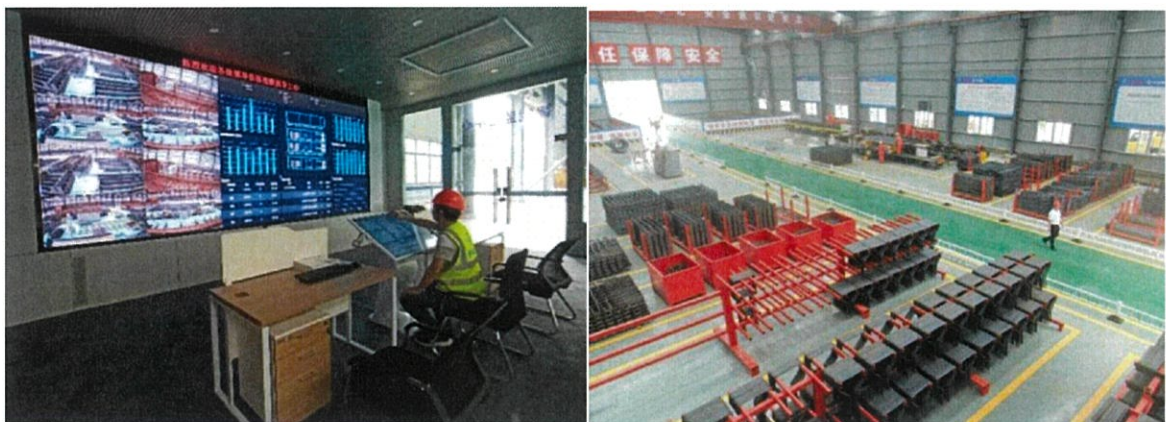
图 7.3.2-6 我公司项目钢筋智能化监测
