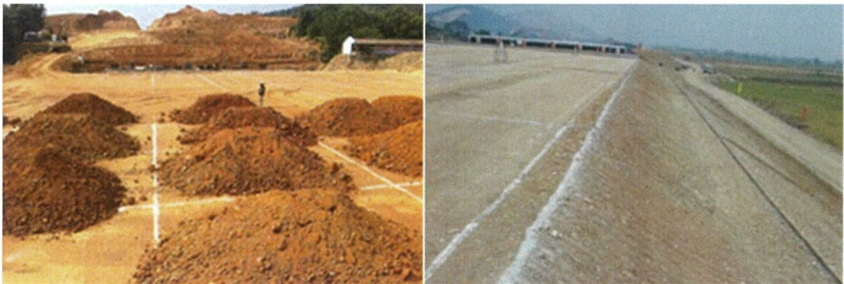
图 2.2.1-5 填土路基施工
