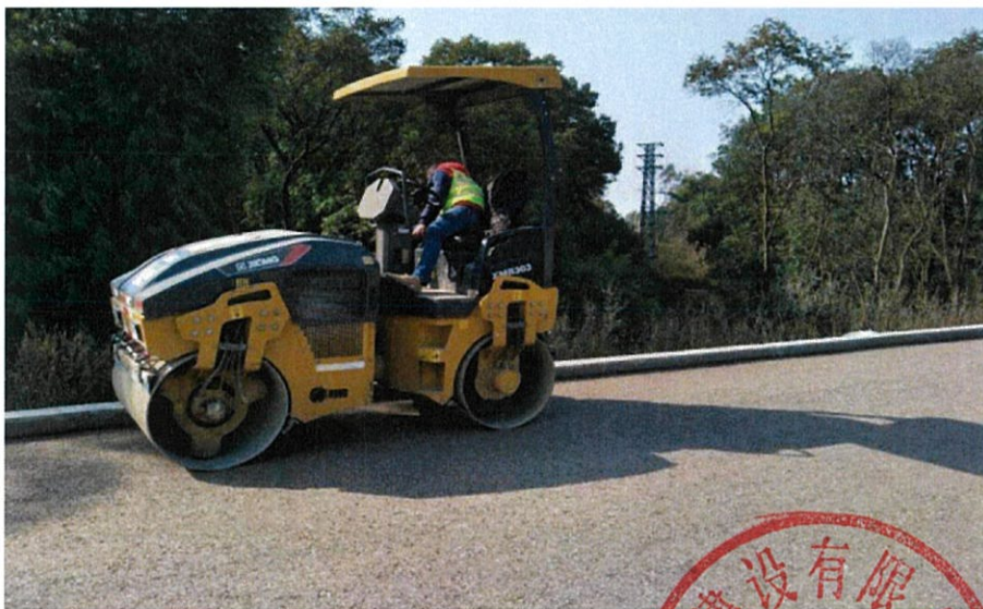
图 2.2.2-5 底基层、基层边部小型压路机碾压到位
