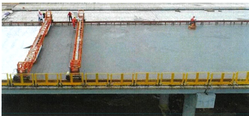
图 2.3.3-20 桥面铺装激光桁架摊铺机施工
