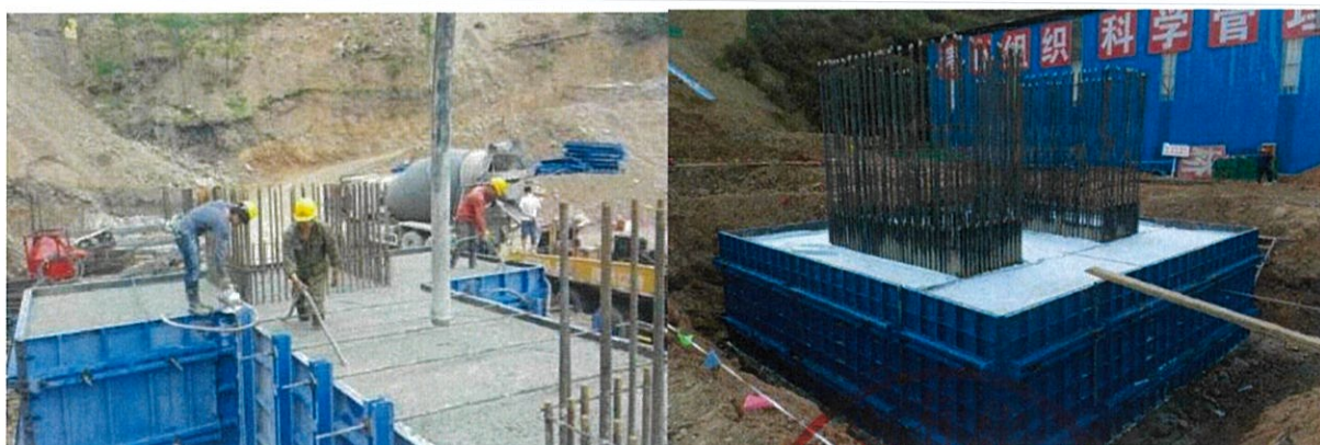
图 2.3.3-10 承台混凝土浇筑、养护
