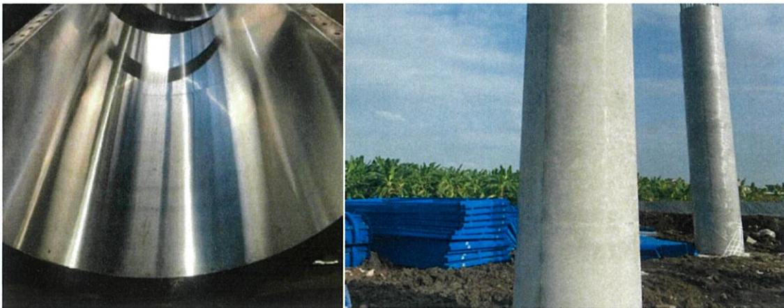
图 2.3.3-12 圆柱墩不锈钢模板及成品
