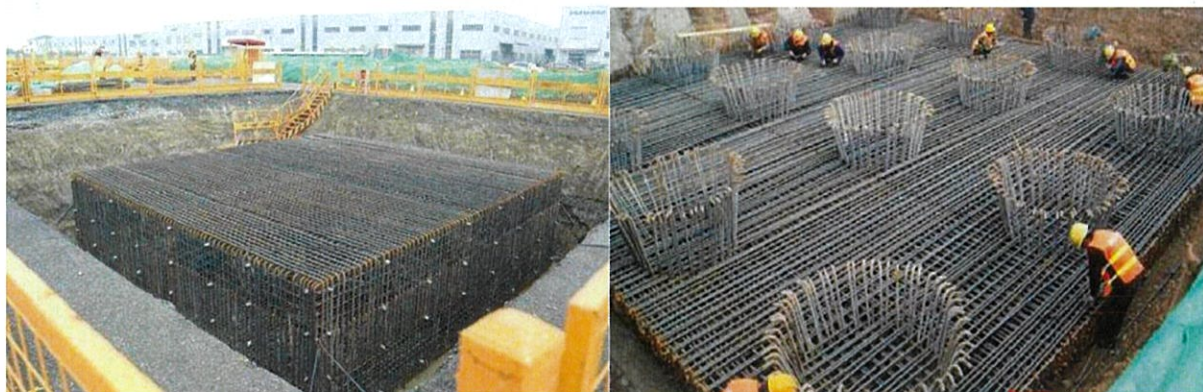
图 2.3.3-9 承台钢筋绑扎
