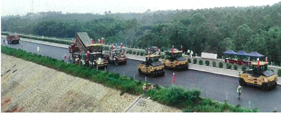
图 2.2.2-12 沥青路面摊铺标准化作业
