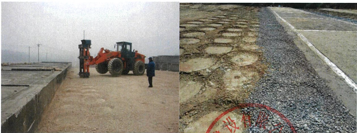
图 2.2.1-9 构造物台背回填施工
