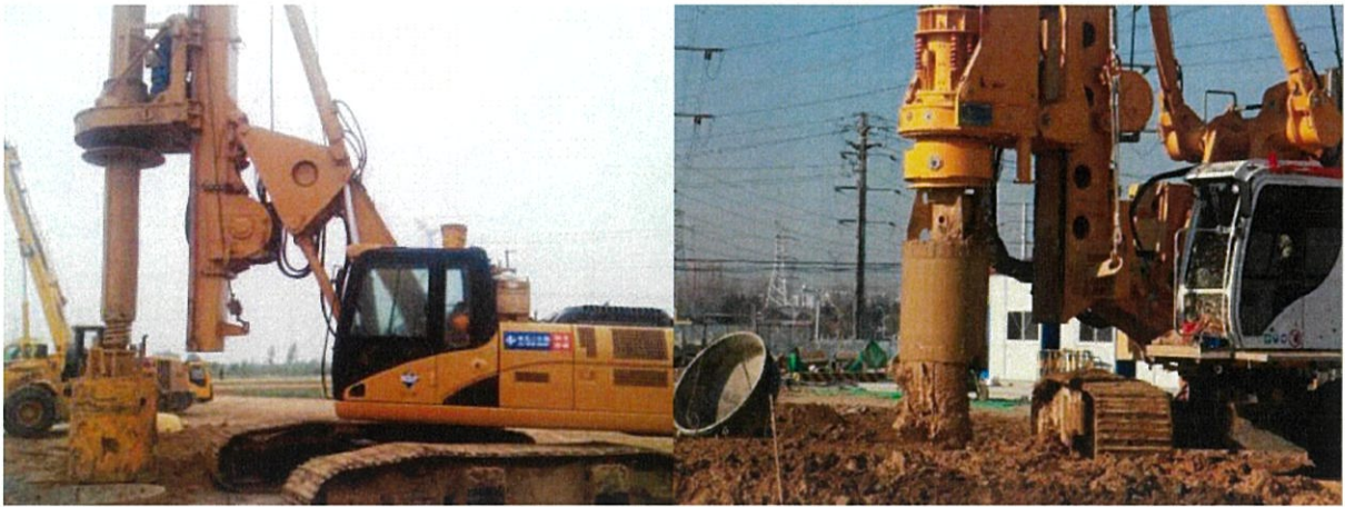
图 2.3.3-2 旋挖钻成孔施工
