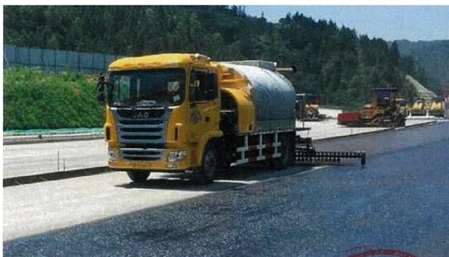
图 2.2.2-7 透层施工
