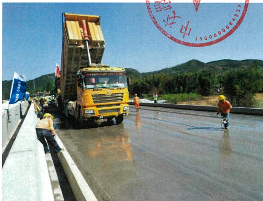
图 2.2.2-3 底基层、基层标高控制及复核
