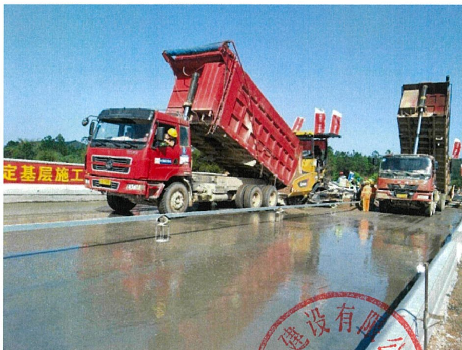
图 2.2.2-2 底基层、基层摊铺施工
