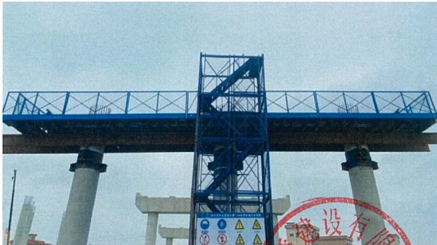
图 2.3.3-15 抱箍法施工盖梁
