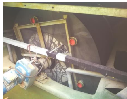
图 5-16 生物转盘示意图（左）及实物图（右）
