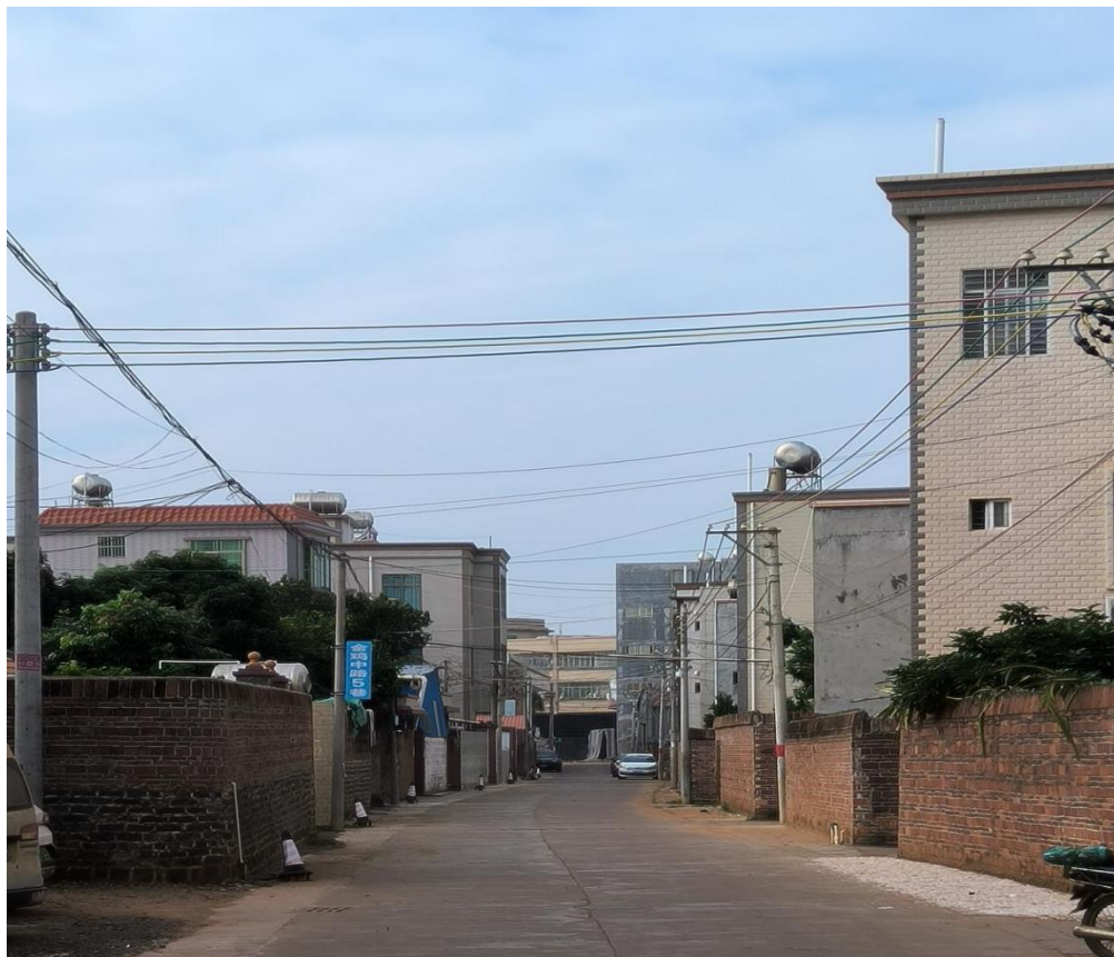
图3-4 道路未安装路灯现状图
