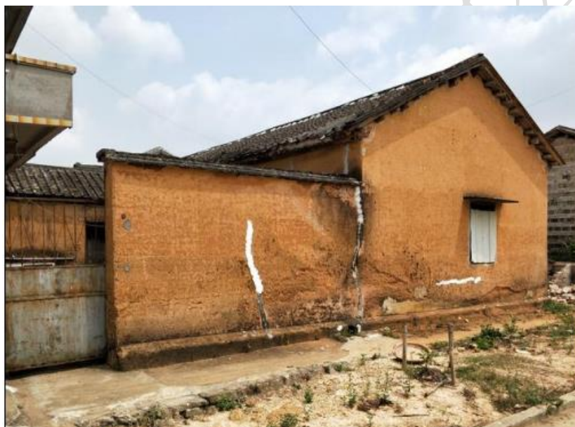
图 4-14 下洋东征文化村房屋黄泥破损墙体
