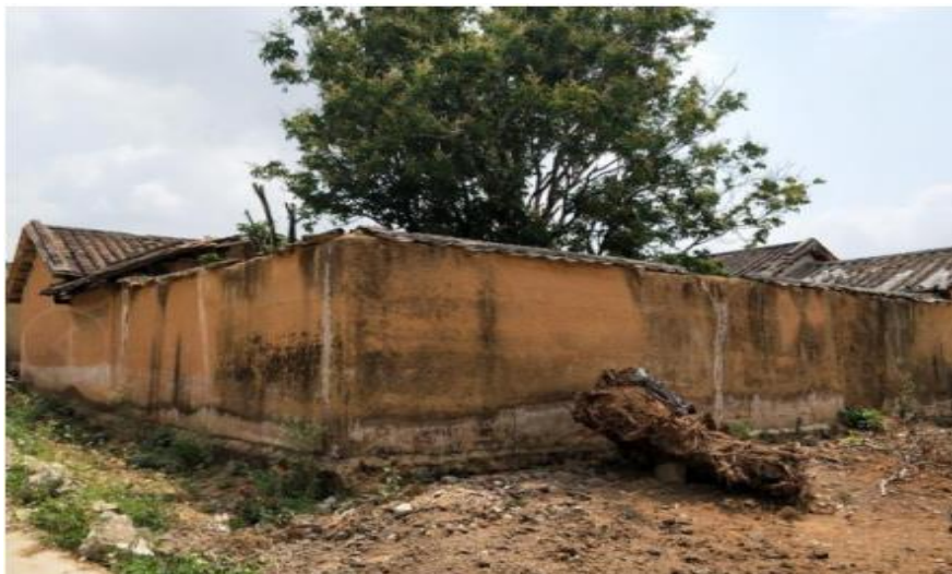
图 4-13 下洋东征文化村房屋黄泥土围合式墙体
