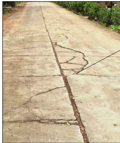
道路现状图片
