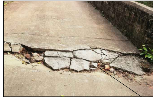
道路现状图片
