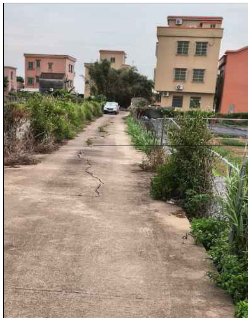
道路现状图片
