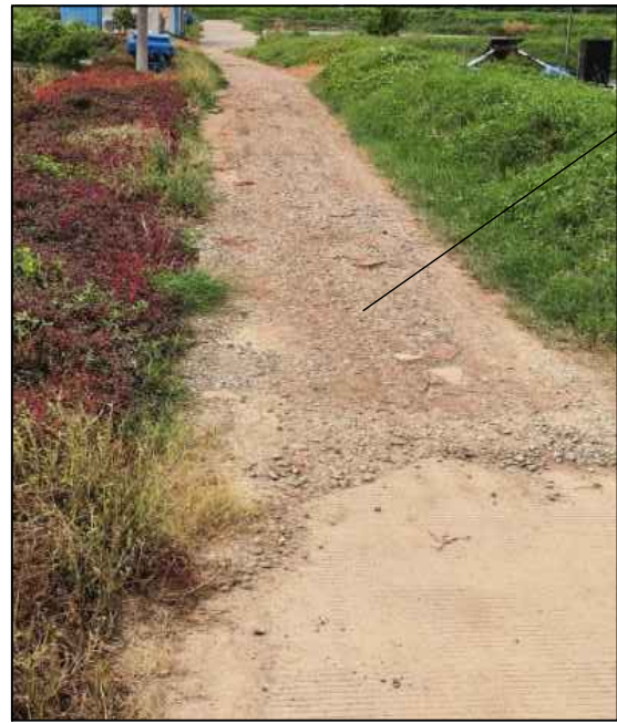
道路现状图片
