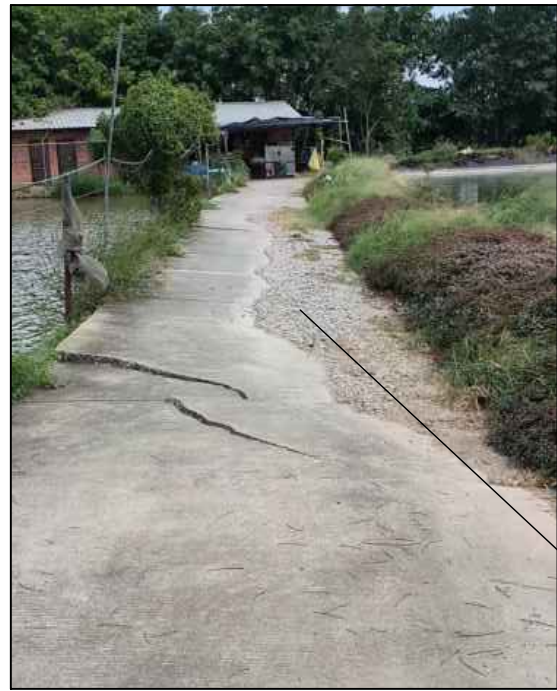
道路现状图片
