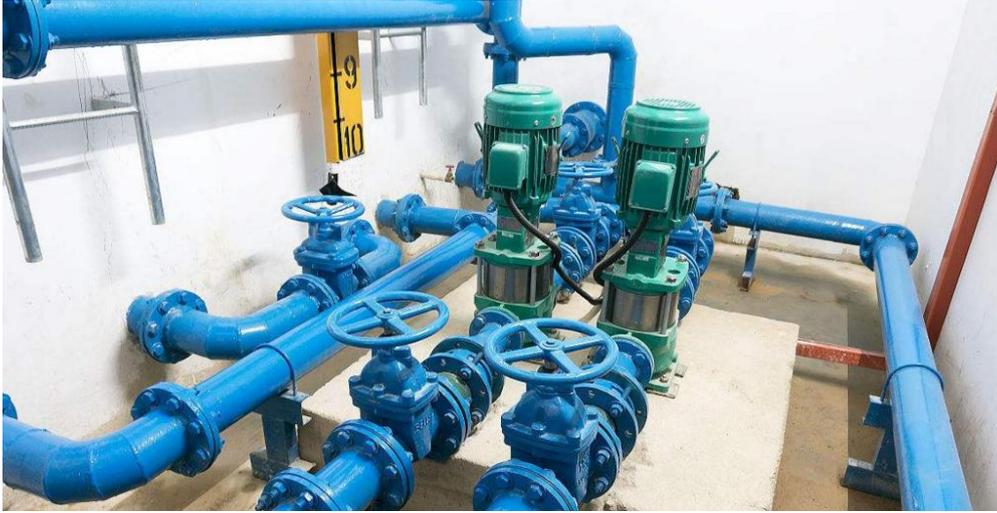
图 6.6-5 给水加压泵改造示意图
