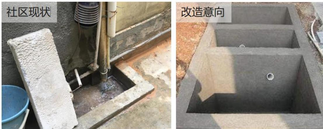
图 6.6-7 清疏、修复化粪池及排污卧管改造示意图
