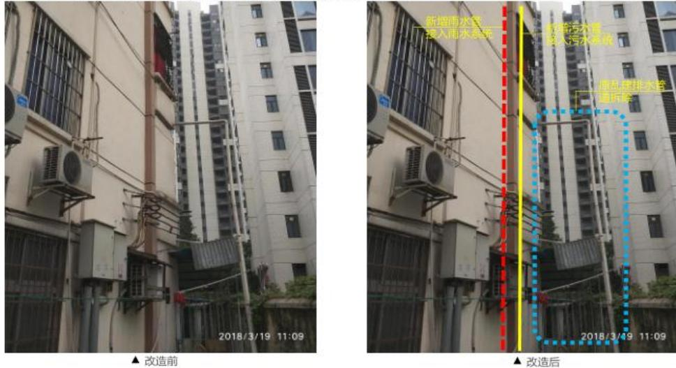
图 6.6-14 雨污分流改造示意图
