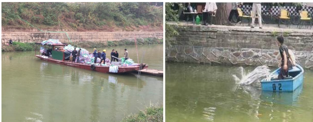
仿生水草的投放（带水施工，在船上直接投放）
