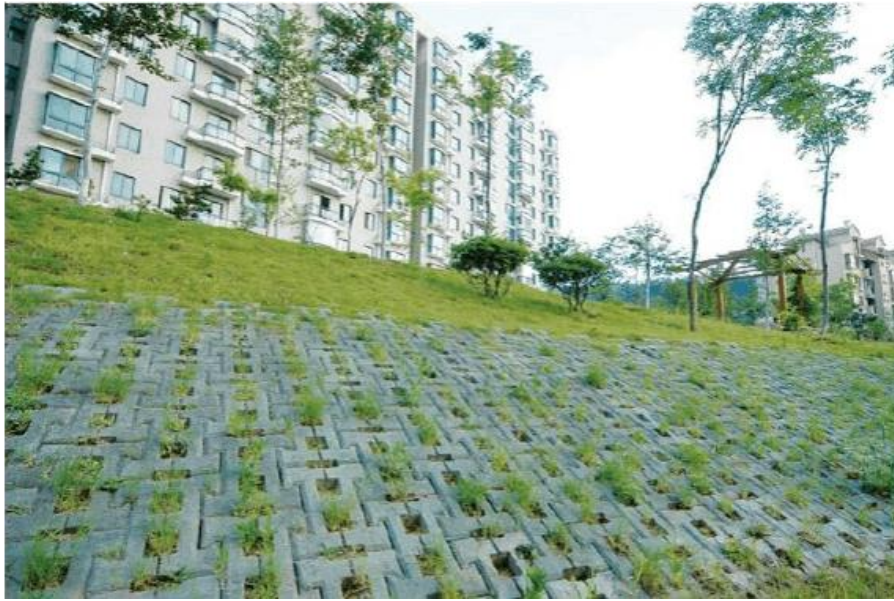
联锁式混凝土块生态护岸效果图
