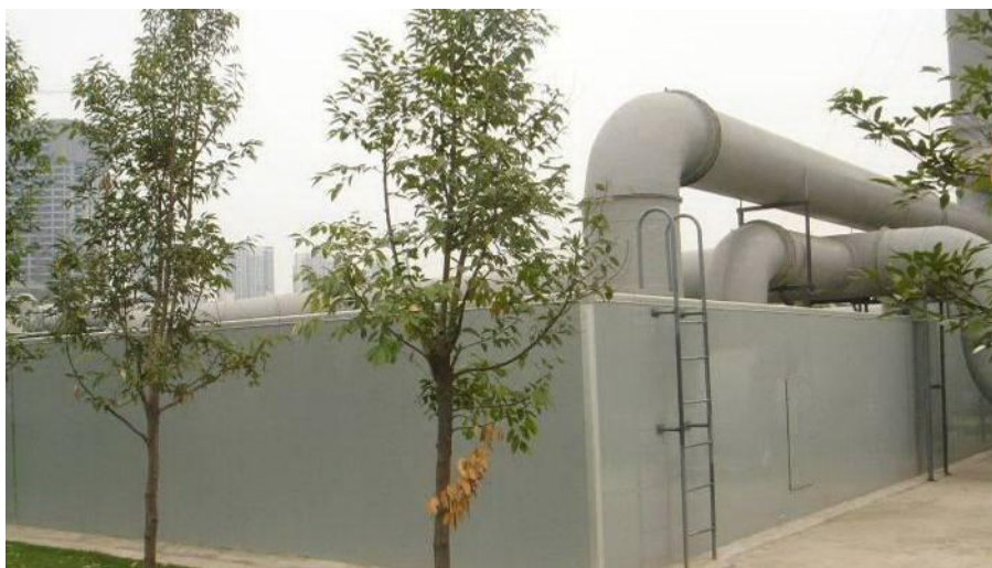
图 5-9 生物滤池除臭装置
