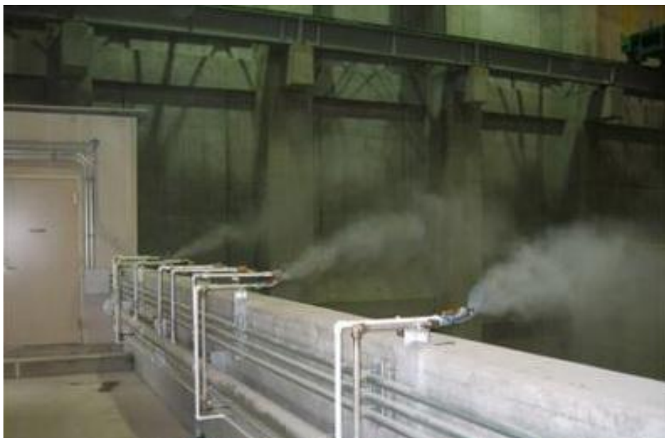
图 5-8 植物提取液喷淋装置
