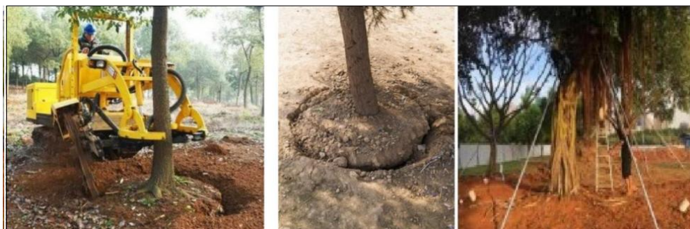
图 5-74 树体挖掘示意图
