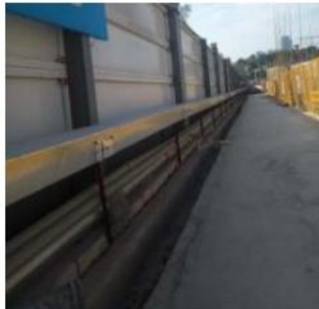
电缆线沿墙壁敷设示意图
