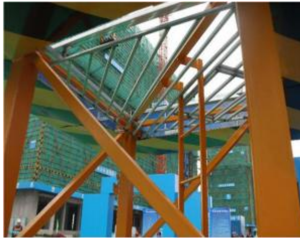
定型化塔吊防攀爬装置1
