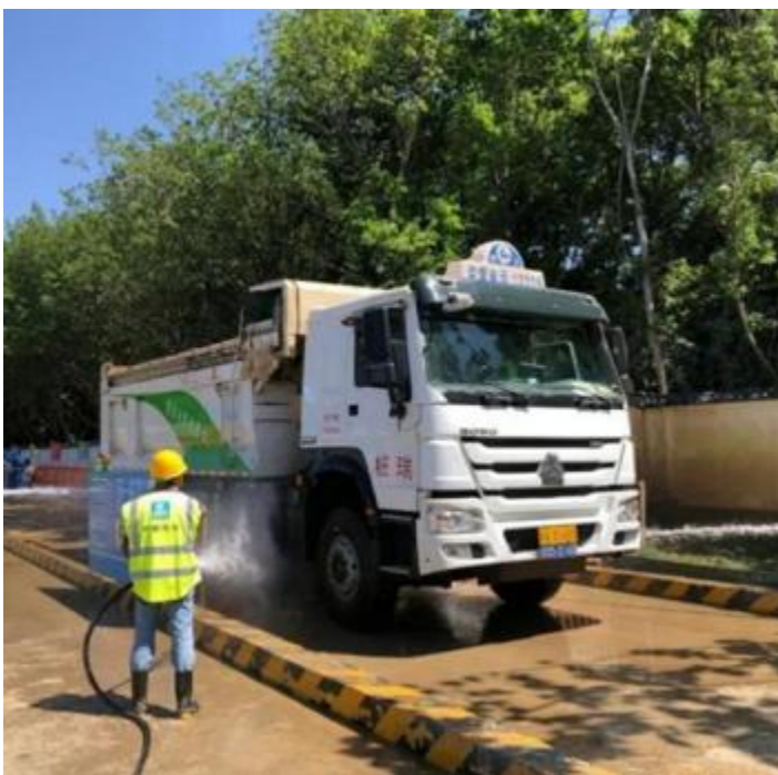
高压水枪人工冲洗车辆
