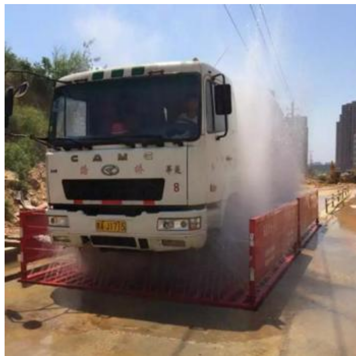
全自动洗轮机清洗车辆
