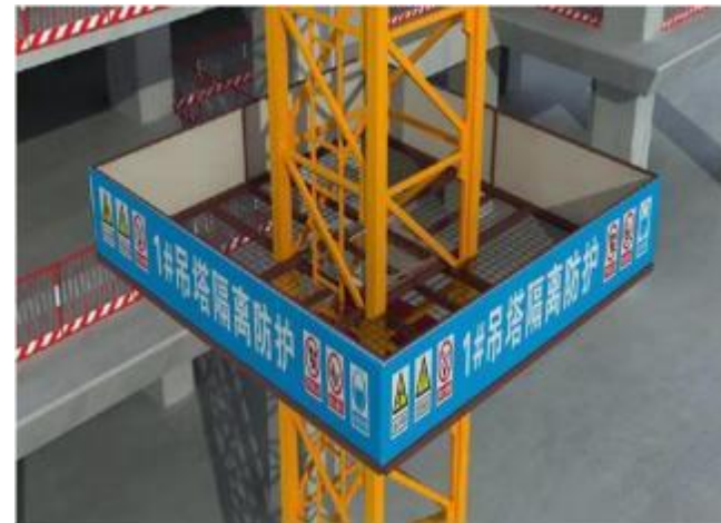
定型化塔吊防攀爬装置2
