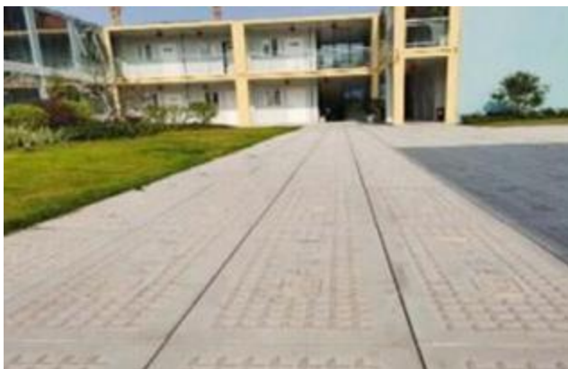
预制混凝土路面
