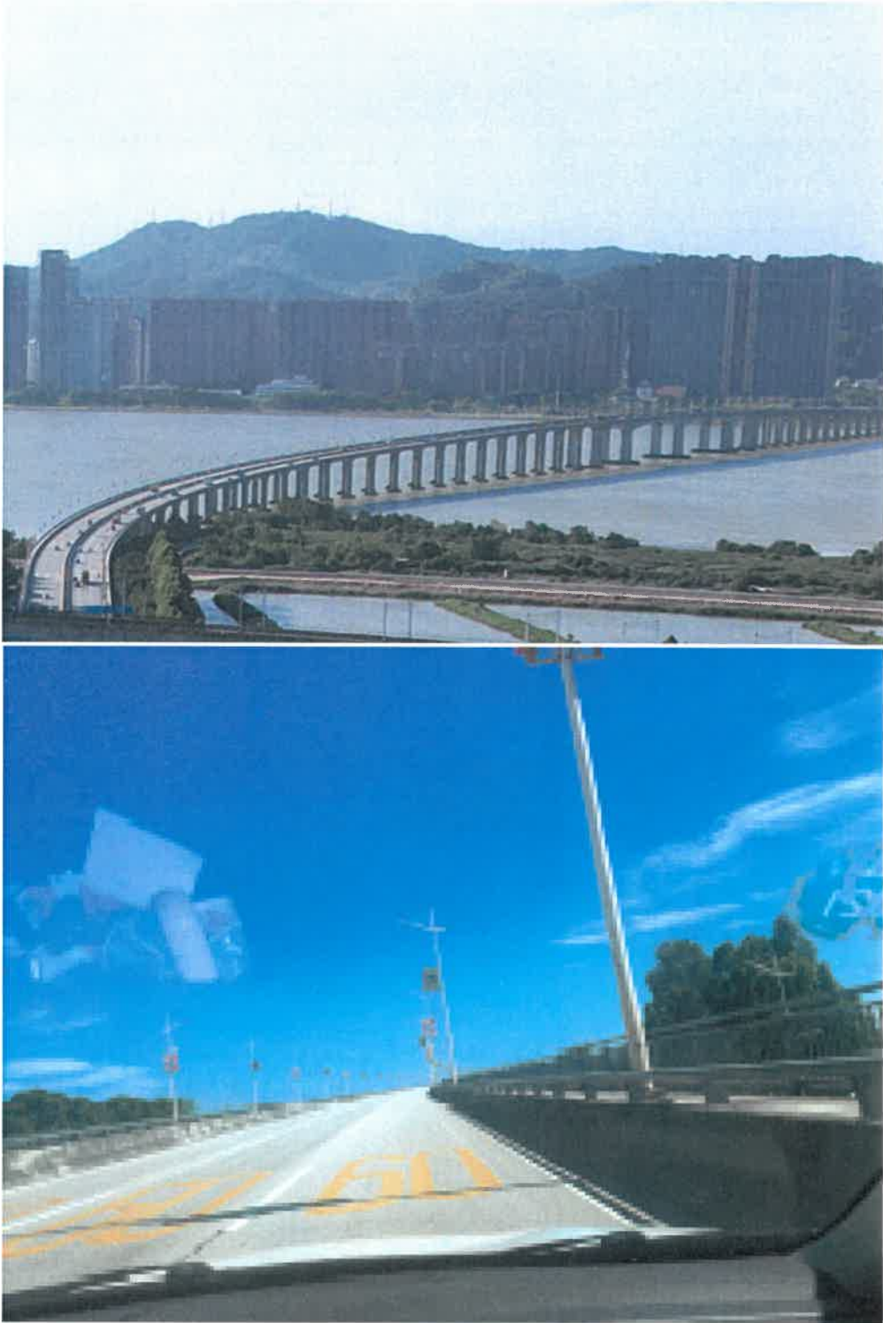
鬼洲大桥现状
