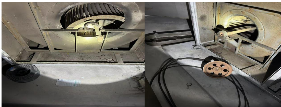
图 5 风机断杆轴故障图
