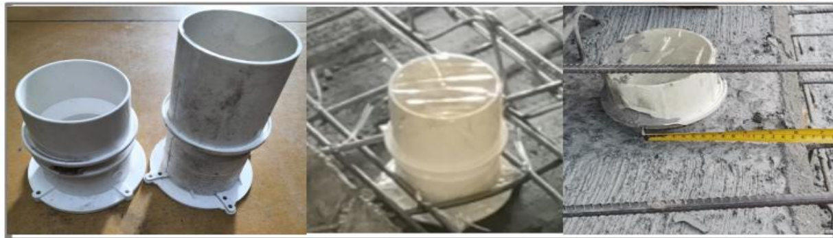
1. 普通止水节、加高止水节。
