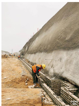
6. 坡底排水沟、集水坑，坡面泄水孔
