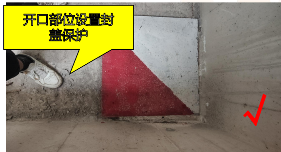
2. 排气道从下向上逐层安装,开口部位设置封盖保护措施。
