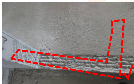
2. 反坎部位底部及侧面基层凿毛清理干净, 凿毛率 \geq 50\% , 结合部位润湿。
