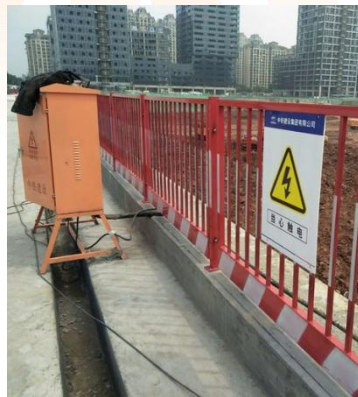
2. 基坑边设不小于1.2米高的防护
