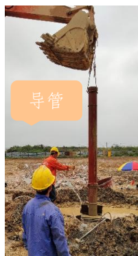
1. 沉导管（泥浆护壁成孔桩）
