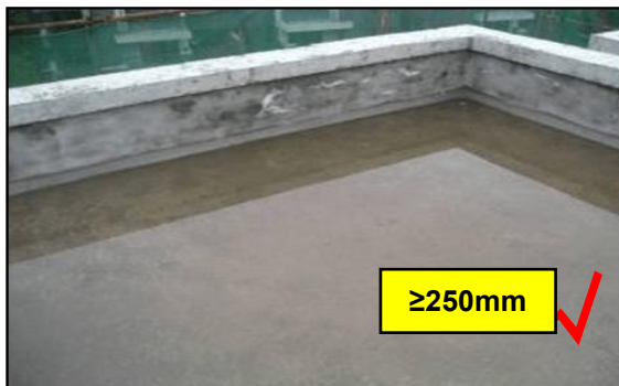
1. 屋面板浮浆清理后, 闭水24h, 闭水高度为最低处水面高度3cm。
