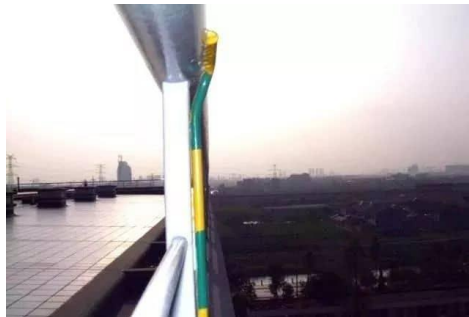
4.屋面凸起金属构筑物防雷接地。
