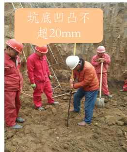
4. 坑底土样、标高复核，预留人工清土层
