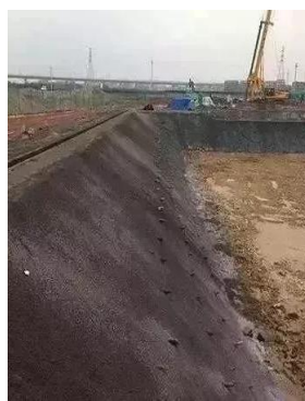
6. 坡底排水沟、集水坑，坡面泄水孔
