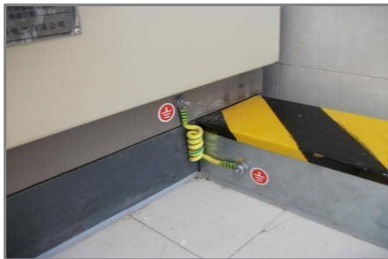
5. 箱体与桥架连接设跨接导线
