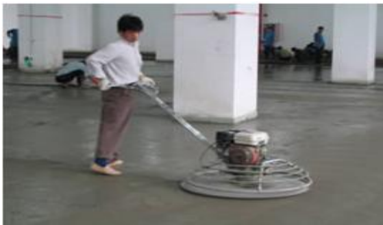
1、混凝土初凝6-8小时左右, 使用磨面机(带底板)进行第一次打磨
