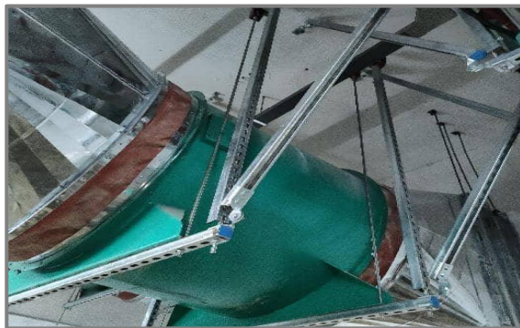
1.吊装风机安装抗震支架。
