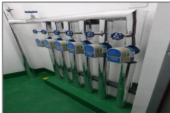
5.水表、阀门安装高度一致、美观大方。
