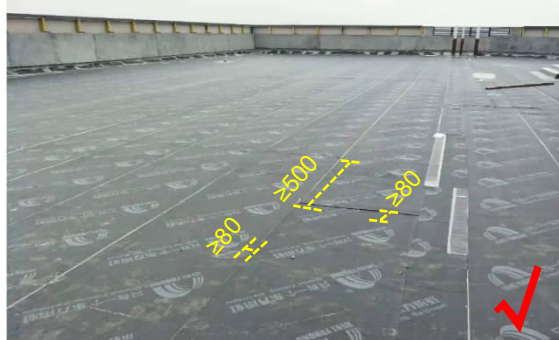
3. 卷材相邻短边搭接缝错开宽度 \geq 500\text{cm} ，卷材搭接宽度 \geq 80\text{cm}
