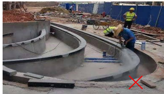
2.水景石材规格与结构不吻合，现场打磨。
