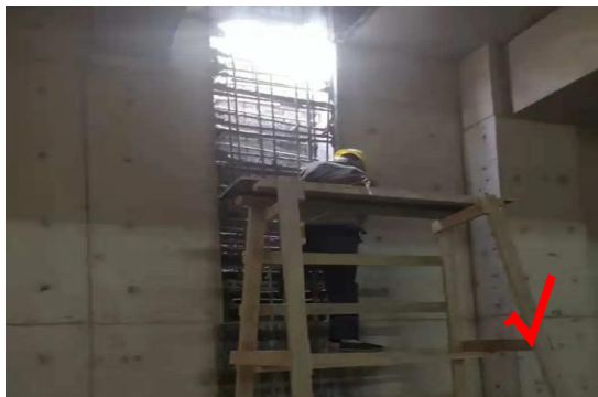
1.界面凿毛, 钢筋除锈并清洗干净
