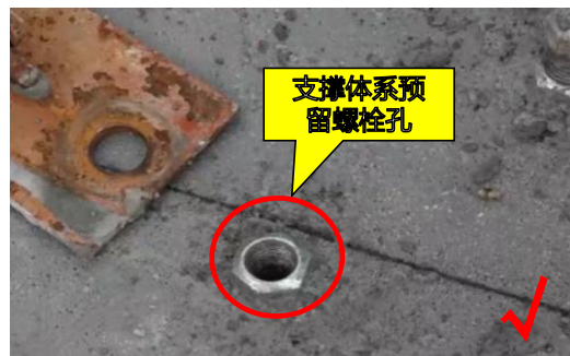
3. 预制凸窗支撑体系需在楼层板现浇面层上根据螺栓定位图进行定位并弹线标出
