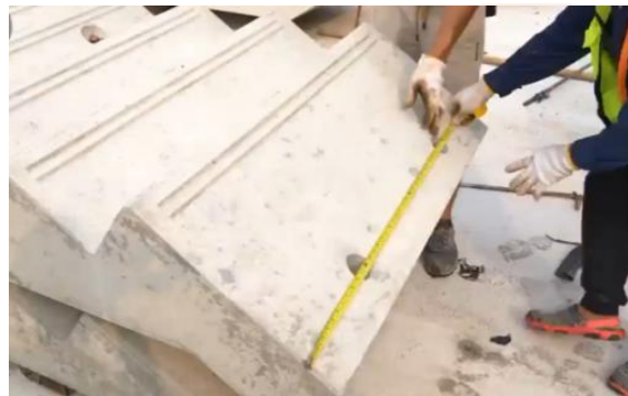
2. 吊装前复测截面尺寸、预留孔直径及孔距; 构件强度达100%方可起吊
