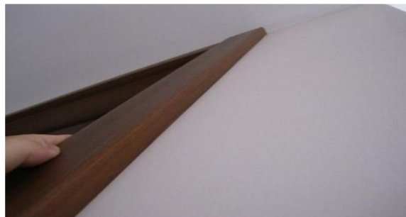
4. 门套边自然收口（开关插座边、踢脚线边、柜体边等收口标准与此一致）
