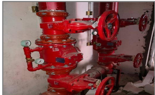
4.报警阀上下两侧采用信号闸阀。
