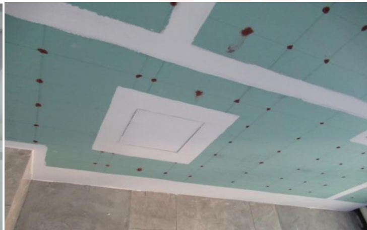
2. 石膏板拼缝部位构造使用防开裂纸带+玻纤网双重处理。
