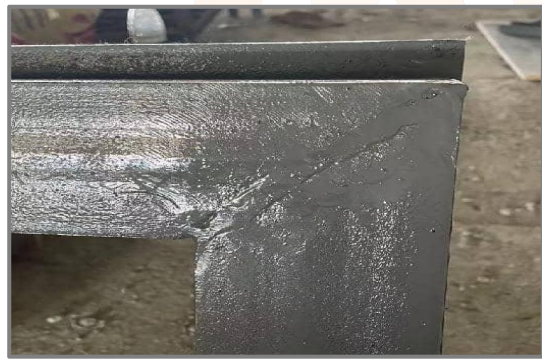
2. 支、吊架焊接打磨平整后再刷漆。
