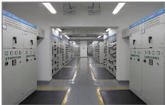
1. 配电柜前后均铺设绝缘垫。
