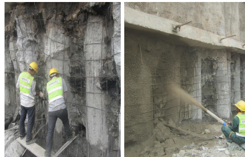
2. 桩间钢筋网绑扎、喷射桩间混凝土
