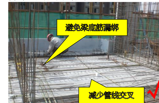
6. 梁底筋绑扎后沉梁, 再穿面筋绑扎, 同一根电气管线不宜交叉重叠两次以上
