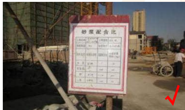
2. 楼层砂浆应垫板, 水泥砂浆须在拌成后3小时(高温天气2小时)内使用完毕。
