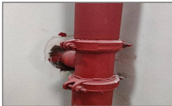
3.立管与水平管采用沟槽式管件连接。
