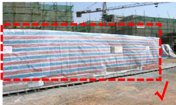
1. 加气块进场做好防潮、防雨措施, 砌块的静置时间 \geq 28 天。
