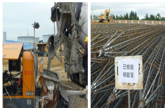
2. 压送素混凝土、验收钢筋笼。
