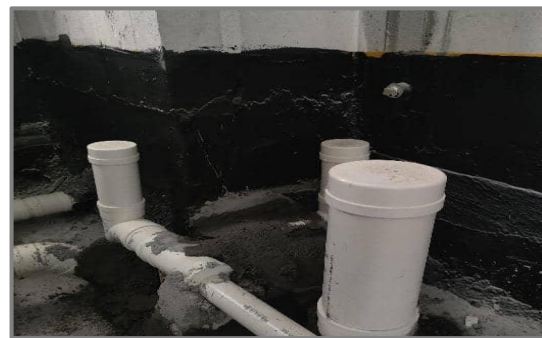
4.管道预留口采取临时封闭措施。
