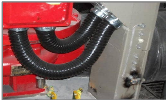
3.水泵控制线缆设滴水弯。
