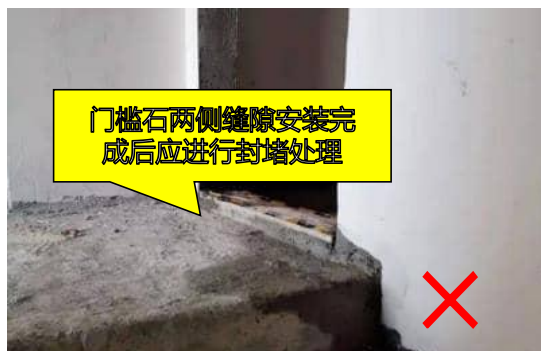
5.门槛石两侧缝隙安装完成后防水材料的封堵施工不密实,导致渗水。
