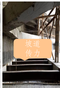
1. 基坑换撑、主体结构传力
