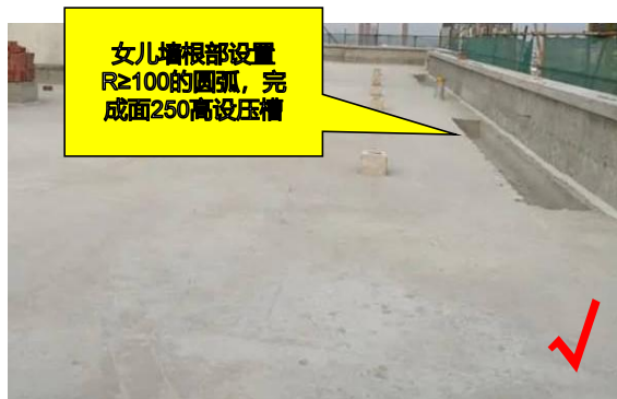
1. 基层清理干净、无起砂、无浮浆并进行24h闭水移交防水施工
