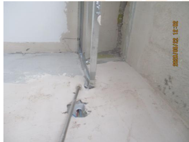
2. 边龙骨变形，胀栓打爆基层
