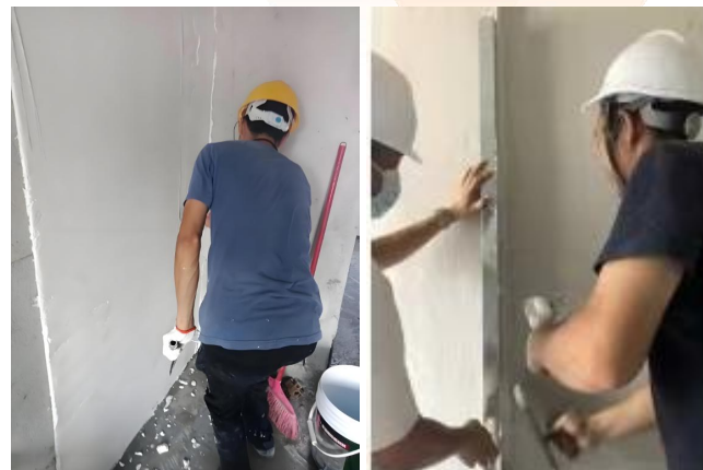
1、气凝胶保温施工
