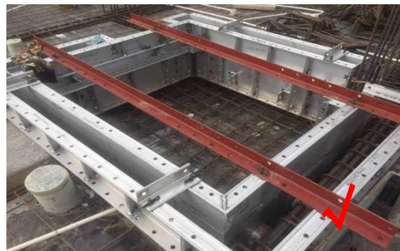
5. 有条件的铝模楼栋, 反坎宜随主体结构一次性浇筑成型。
