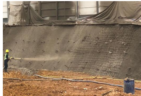
4. 喷射混凝土
