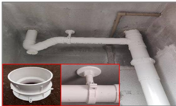
3.立管每层设置伸缩节,穿楼层预埋止水节,采用专用管卡安装。
