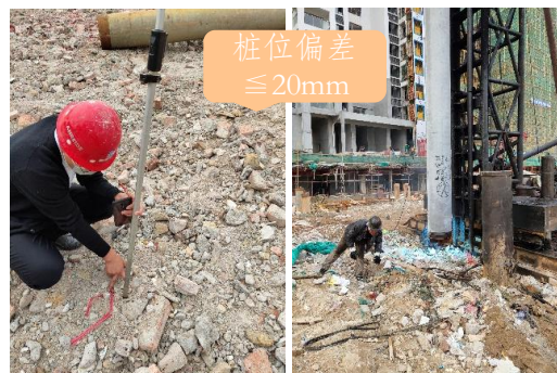
1. 桩位定位测量放线、移机就位、焊桩尖
