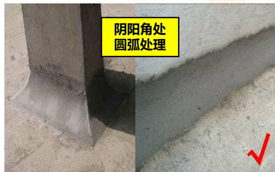
2. 防水施工前, 基层处理到位, 拼缝打磨、阴阳角R角, 浮灰清扫干净。
