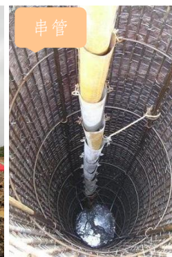
1. 沉导管（泥浆护壁成孔桩）
