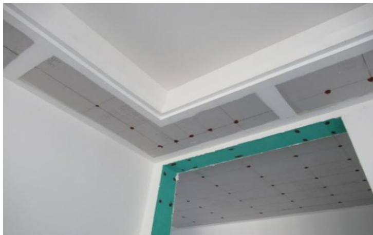
3. 吊顶与墙面接触部位构造使用防开裂纸带（不小于50mm宽）+阴角条+腻子施工。
