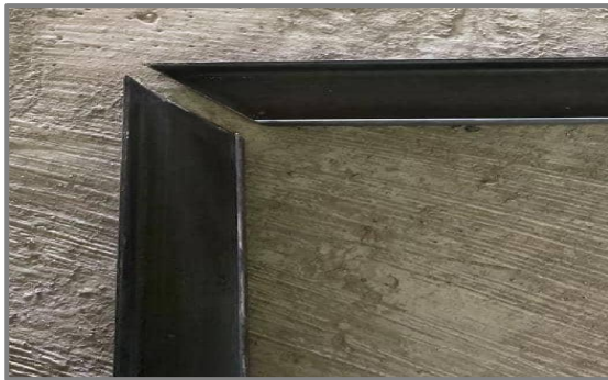
1. 支、吊架切割平整。
