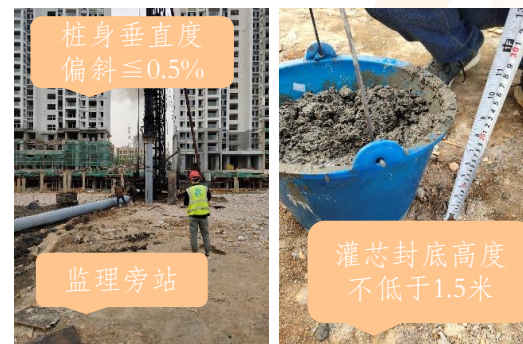
2. 第一节桩施打、灌桩底混凝土。
