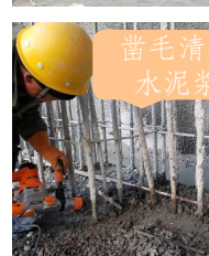
6. 绳锯水泥浆处理、支撑拆除后效果
