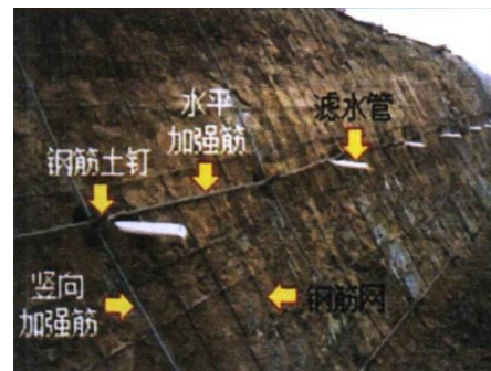
3. 铺设、绑扎钢筋网，预埋泄水孔
