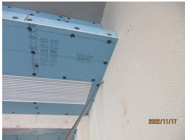
1. 未切割的板边以10~15mm为宜，切割的板边以15~20mm为宜，板边钉距不得大于150mm，板中钉距不得大于200mm。
