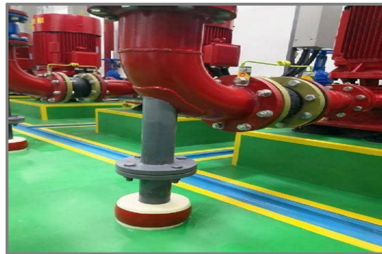
6.采用可拆卸、调节的支撑方式。
