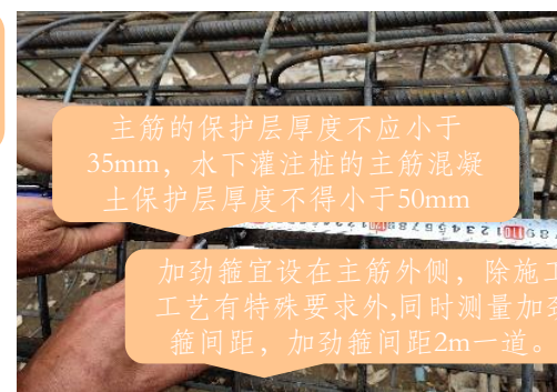
4.钢筋笼加劲筋、保护层耳筋检查。
