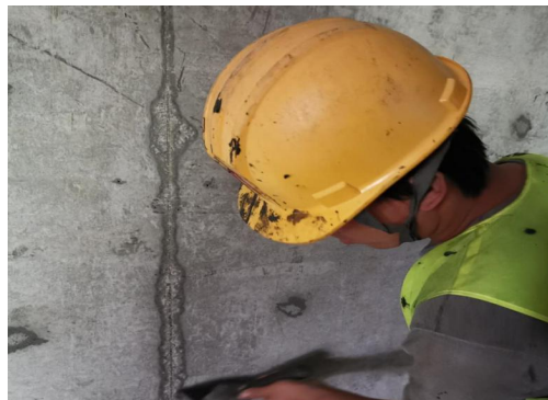
2. 基层处理清理模板拼缝处残留砼硬块, 并清理模板残留。
