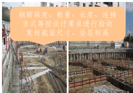
1. 第一道支撑垫层浇筑、钢筋模板施工
