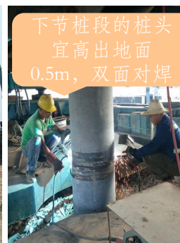
3. 第二节桩吊运、焊接、压入。
