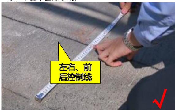
3. 吊装前画出安装位置及标高控制线, 铺设水泥砂浆找平层
