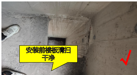
1. 安装前核查建筑层高、楼板预留洞或墙体预留孔的尺寸和位置是否正确
