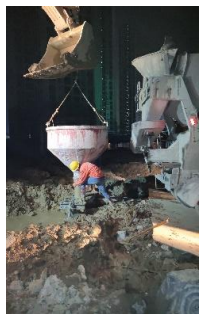
5. 浇筑中逐步提升、分节拆除导管（串管）
