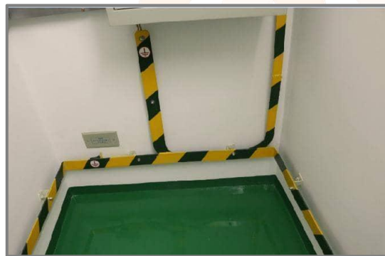
2.接地扁钢涂刷黄绿相间颜色。
