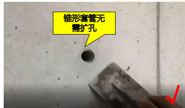
2. 采用铝模锥形套管的, 封堵前将套管取出, 无需扩孔。
