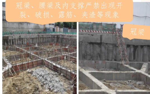
2. 第一道支撑浇筑、成型养护
