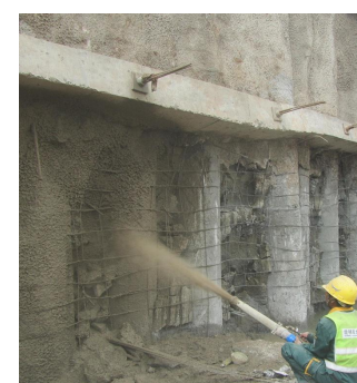
4. 灌注桩桩间挂网喷锚成墙
