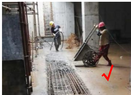
4. 后浇带混凝土施工
