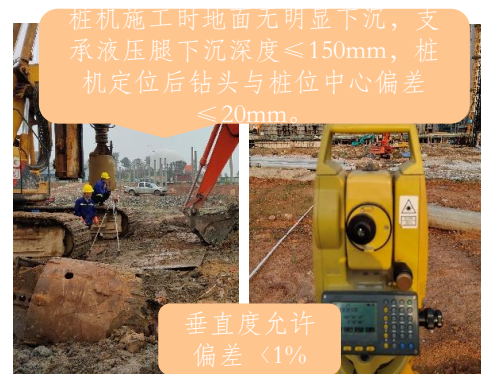
1. 旋挖机就位，桩位及垂直度校核
