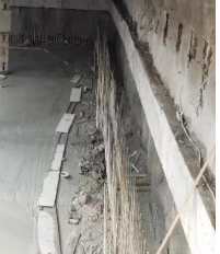
6. 绳锯水泥浆处理、支撑拆除后效果
