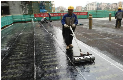
5. 卷材施工, 卷材搭接需将搭接边隔离膜完全撕除, 搭接后用压辊碾压密实。
