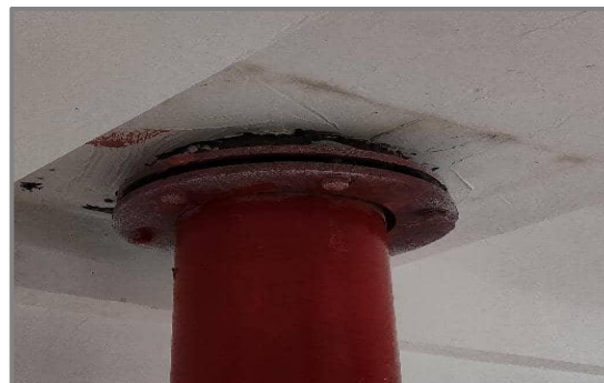
5. 管道穿水池使用柔性防水套管。
