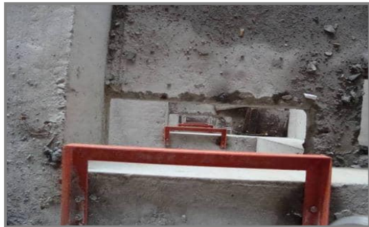
4.预留孔采用垂直吊线方式安装支架。
