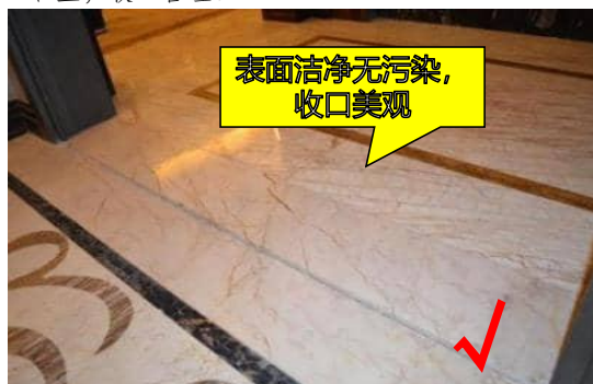
3.表面洁净无污染,交接处缝隙均匀,嵌填密实,收口美观,无大小头或未打磨抛光现象。
