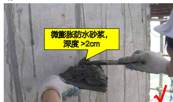
4. 外侧采用微膨胀防水砂浆封堵, 深度 >2\text{cm} 。
