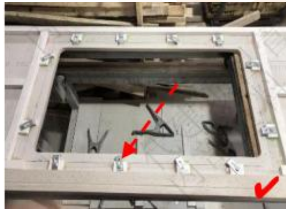
2. 洗菜盆、洗手盆均采用专用不锈钢挂件安装
