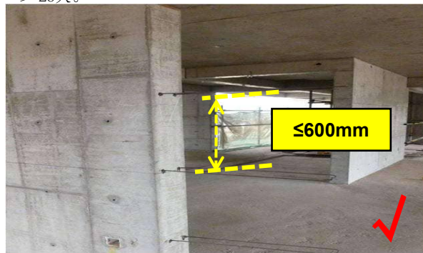
3. 砌筑与砼交界面设置拉结筋, 间距按 \leq 600 mm均匀布置。
