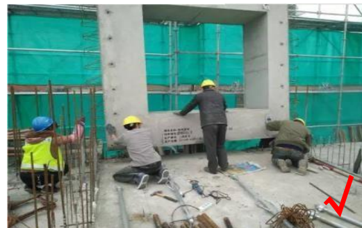
5. 在距离楼面约1m高时停止, 操作人员手扶引导降落, 根据控制线用撬棍调整就位
