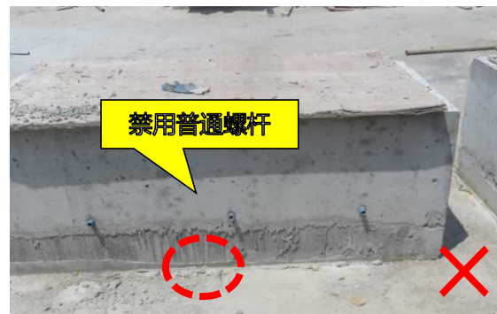
3. 出屋面反坎支模严禁使用普通螺栓。
