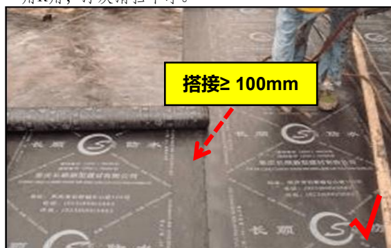
4. 防水应直接施工在结构层上, 涂料三遍成活, 顺水流方向搭接、搭接宽度大于100mm
