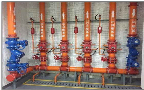
1.报警阀安装位置便于检修及维护。
