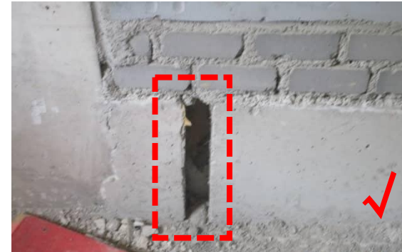
6. 反坎部位有管道经过的, 支模时宜留置凹槽, 严禁管道下穿反坎或门槛。
