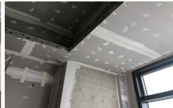
4. 转角7字石膏板，斜角加强一道单层防开裂纸带（或单层玻纤网）。
