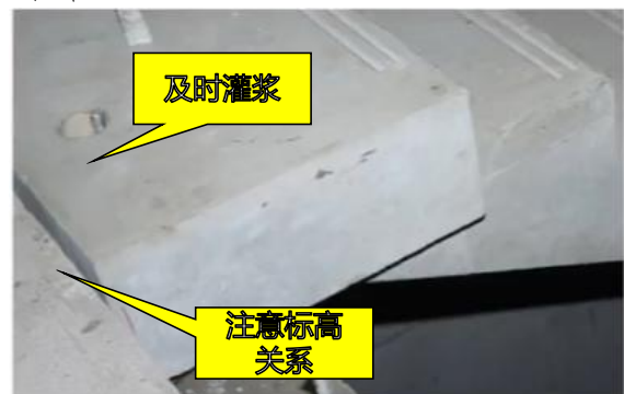
6. 安装时须考虑与楼面、休息平台结构面的相互关系, 就位后连接孔灌浆
