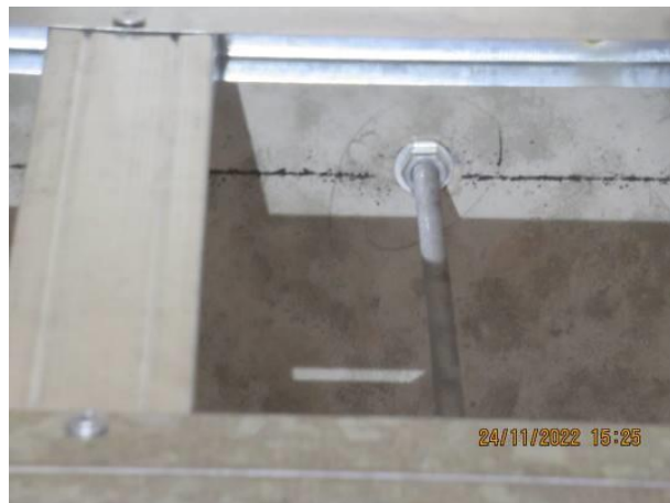
1. 弹线定位, 吊杆垂直, 膨胀螺栓完全嵌入顶棚板面。
