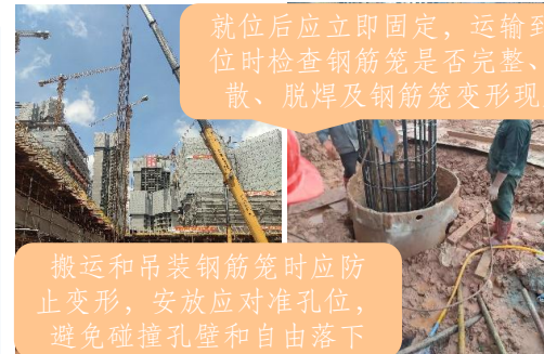
6.钢筋笼吊运、沉孔。
