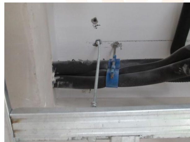
2. 吊杆过长, 调整水平时, 从而导致歪斜
