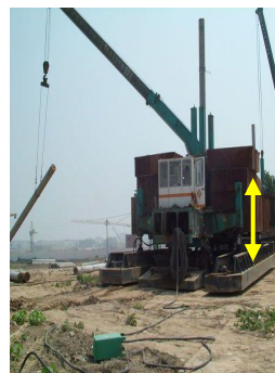
3. 第二节桩吊运、焊接、压入。
