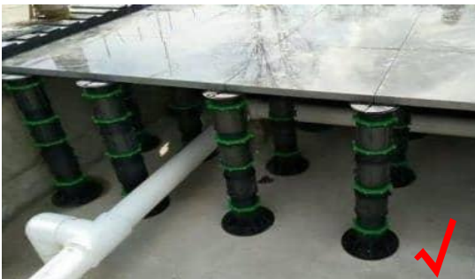
5.选用万能支撑器避免石材与水泥接触。
