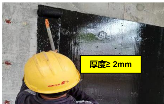
4. 三遍聚氨酯施工, 每道涂刷方向与上一道涂刷相互垂直, 直至保证涂刷厚度2.0。
