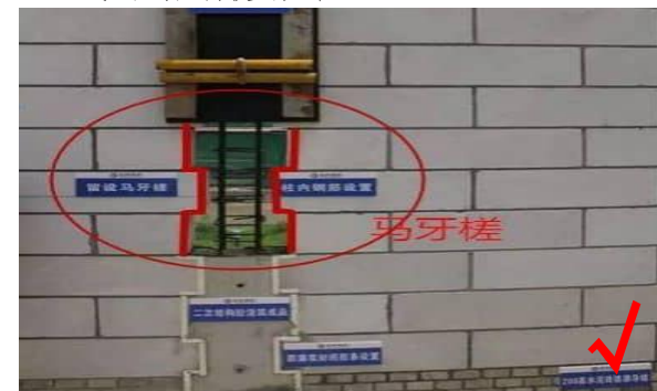
4. 构造柱留设马牙槎, 先退后进, 拉结筋间距应 \leq 600 mm。
