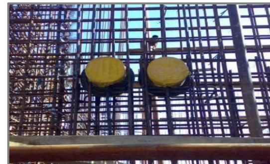
4. 配合土建预留刚性防水套管。
