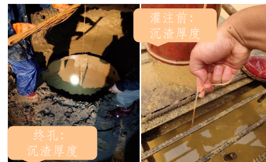
6. 沉渣厚度检测。用测绳末端重物触探：端承桩≤50mm，摩擦桩≤100mm
