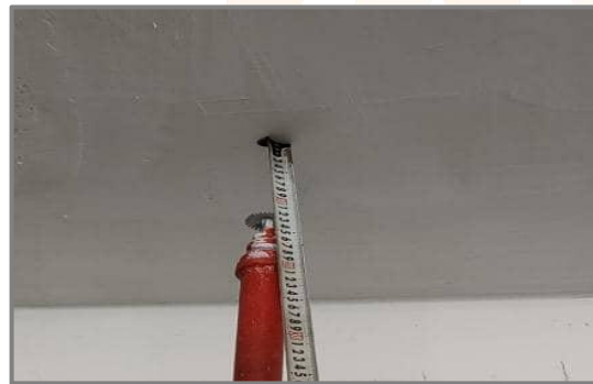
2. 溅水盘与顶板间距在75mm-50mm。
