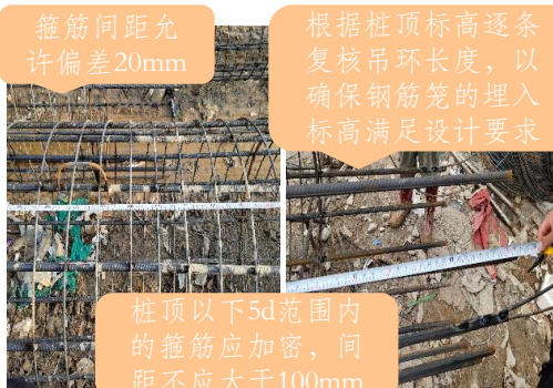
3.钢筋笼箍筋、吊筋检查。
