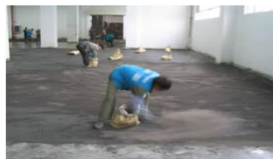
4、人工铺洒第二次金刚砂
