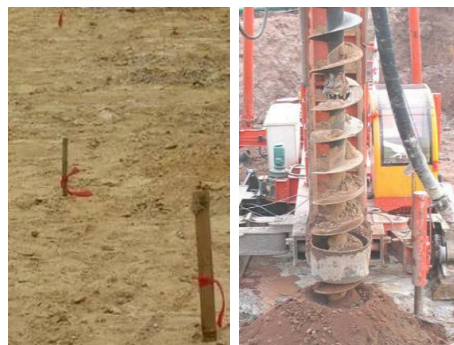
1. 测量定位、对位钻进。
