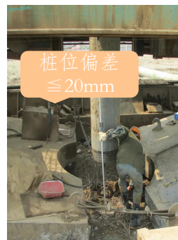
1. 桩位定位测量放线、移机就位、焊桩尖
