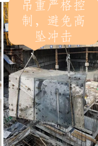
4. 切割、块体拆卸、叉车运输、吊车运输
