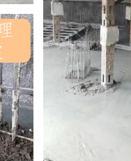
6. 绳锯水泥浆处理、支撑拆除后效果
