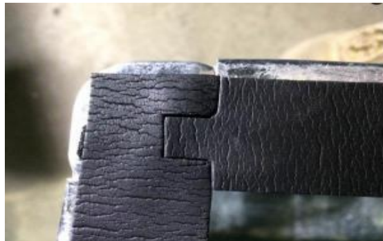
1.风管法兰垫料使用对接接口。
