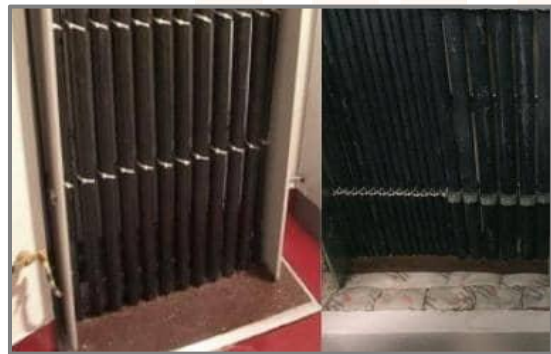
2.电缆绑扎牢固,穿楼板封堵严密。
