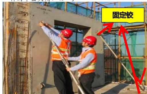
6. 斜撑两端与楼面及构件连接处应形成固定铰, 现浇砼强度达70%后方可拆撑
