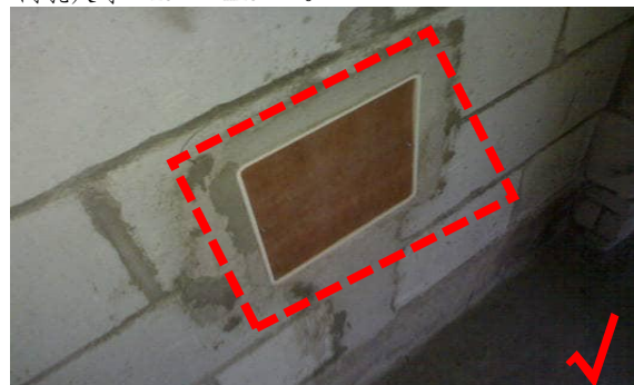
4. 抹灰前,电箱、电盒须做保护盖或塞泡沫块进行保护,防止砂浆污染。
