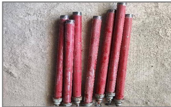
1. 短立管上提前安装好喷头。
