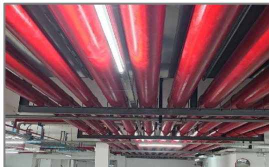
4. 多条管道采用槽钢共用吊架安装。
