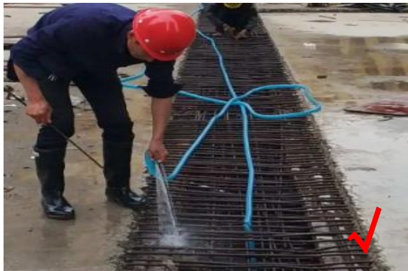
1. 界面凿毛，钢筋除锈并清洗干净
