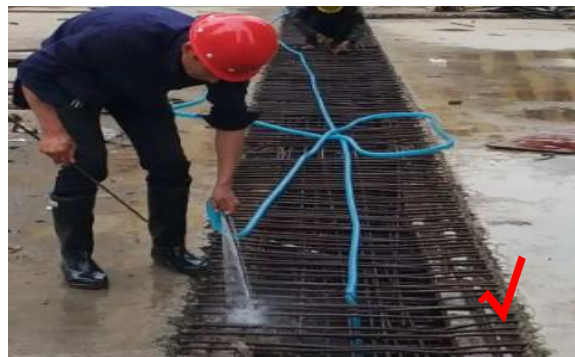
1. 界面凿毛，钢筋除锈并清洗干净
