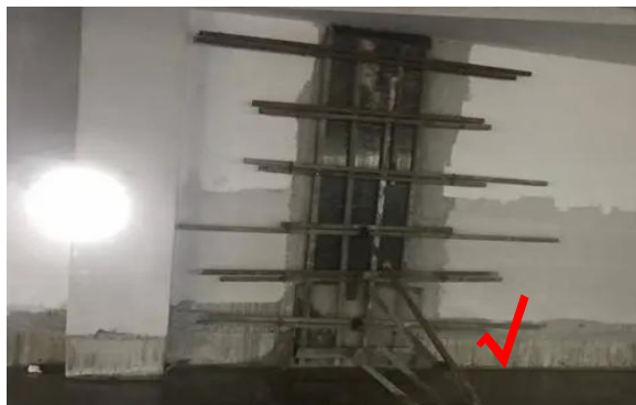
4.后浇带混凝土施工
