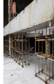
2. 搭支撑架、绳锯放切割线、凿穿绳孔
