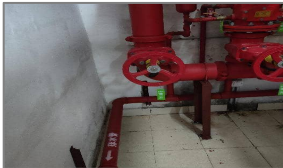
3.报警阀标识清晰、采用直接排水
