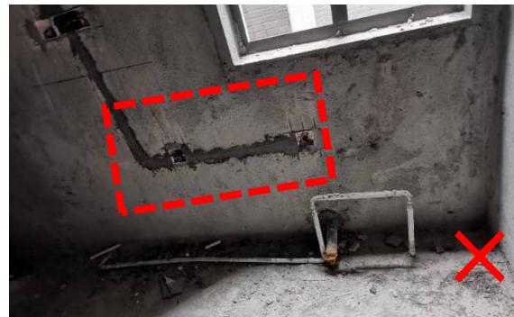
6. 水电点位应提前确定,严禁抹灰后开槽。
