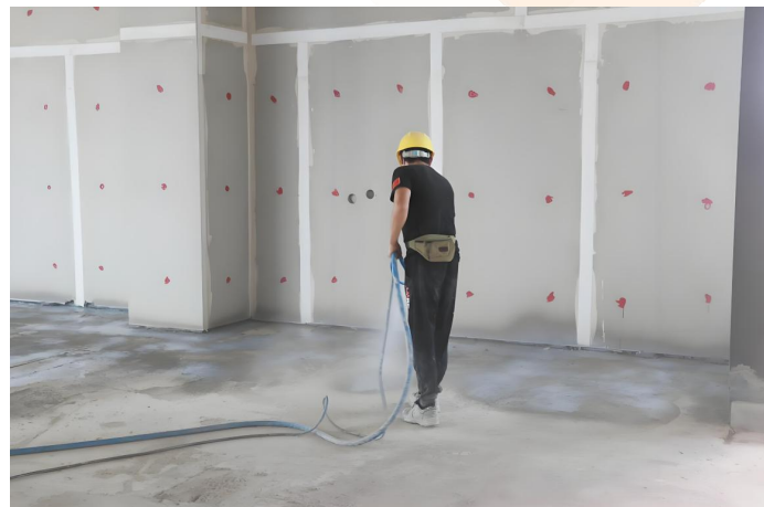
1. 基层处理及底漆施工
