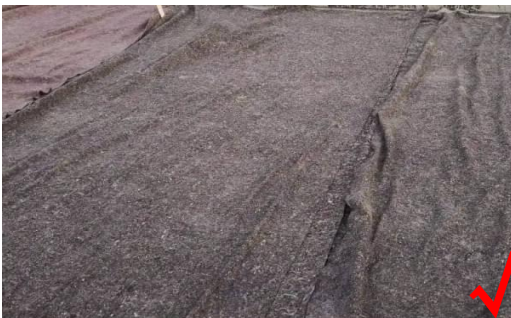
5.完工铺装使用透明薄膜及棉质材料做好成品保护。
