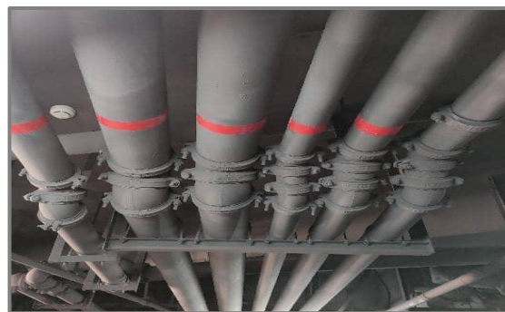
5.顶部统一喷灰后管道标注相应色环。
