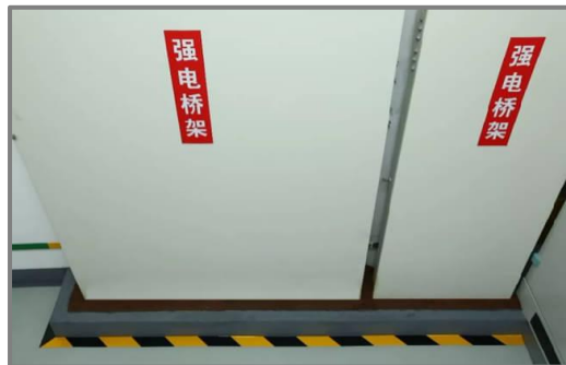
5. 桥架穿楼板处封堵严密。
