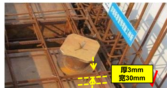
4. 管道穿楼板位置应预埋钢套管, 其中卫生间有防水要求部位应预埋刚性防水套管。
