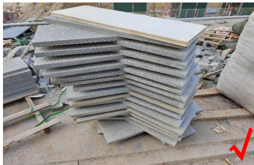
1.材料进场验收，无崩角破损规格统一。
