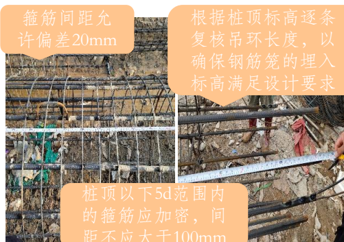
3.钢筋笼箍筋、吊筋检查。
