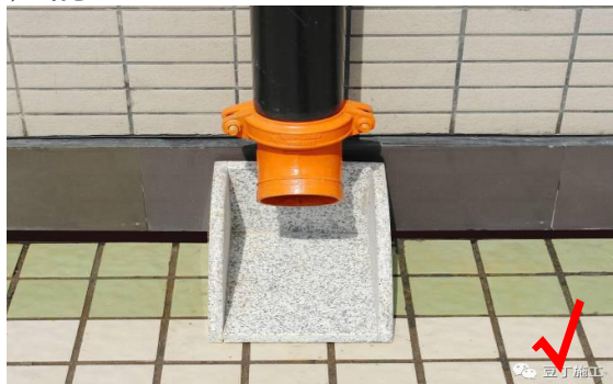
5. 水簸箕尺寸适中, 且与排水管对称居中设置且安装牢固
