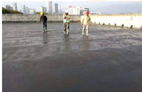
2. 基层表面涂刷专用基层处理剂，卷材同材质的基层处理剂可压住基层表面灰尘，能保证卷材与基
