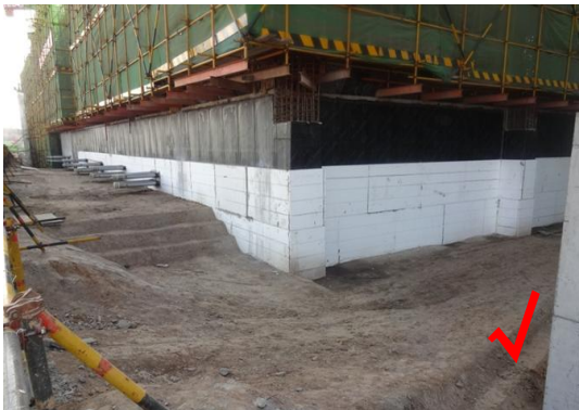
3. 回填过程保护层完整无破坏, 恢复及时
