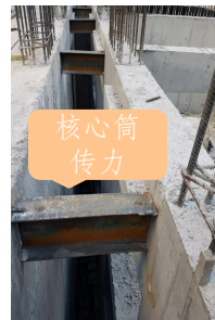
1. 基坑换撑、主体结构传力
