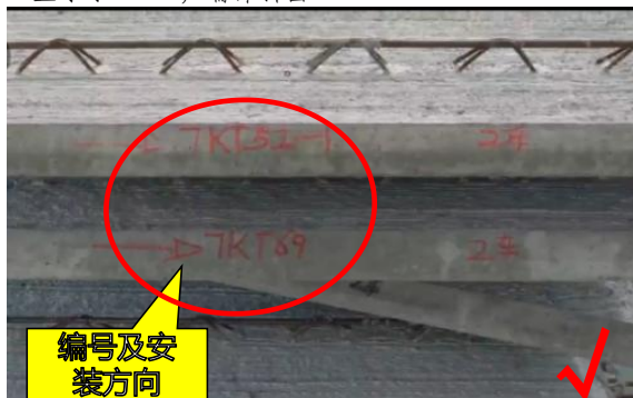
3. 吊装前须检查标记安装方向及编号, 在剪力墙顶面上划出标高控制线
