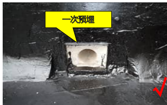
5. 屋面排水口应预埋预留, 不得后开; 侧地漏、防水阴角、管根做防水加强层处理
