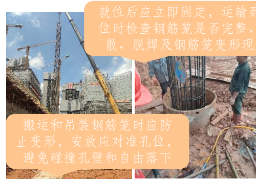
6.钢筋笼吊运、沉孔。
