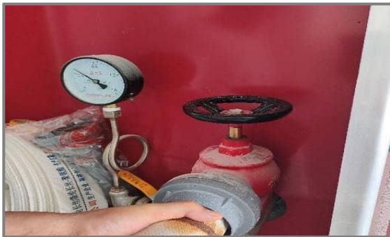
5.消火栓试射动压不小于0.35MPa。
