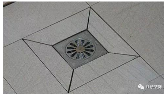
地漏收口宜采用四边倒八字角方式
