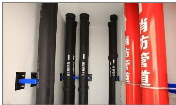
3.立管支架安装牢固、高度统一。
