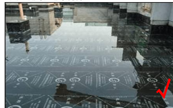
6. 防水验收合格后, 闭水24h, 闭水高度为最低处水面高度3cm。
