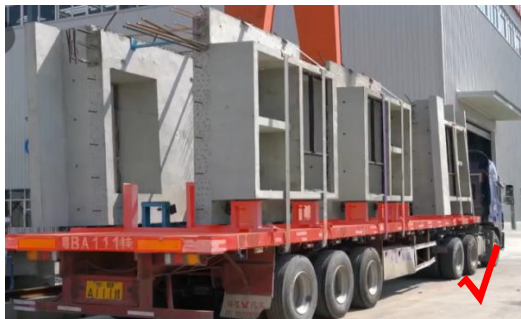
1. 预制凸窗堆放及运输均应采取立放或靠放方式
