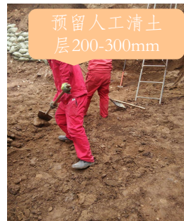
4. 坑底土样、标高复核，预留人工清土层
