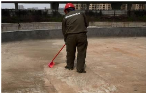
1. 基层清扫, 基面抛丸打磨, 转角做弧角
