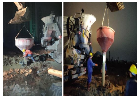
5. 浇筑中逐步提升、分节拆除导管（串管）
