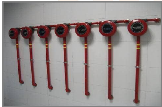
2.水力警铃在室外安装整齐。
