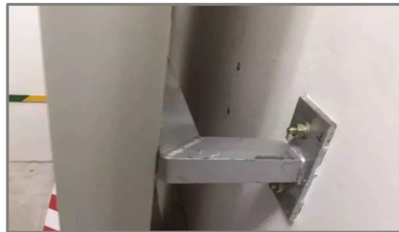
3. 支架底部焊接钢板设螺栓固定。
