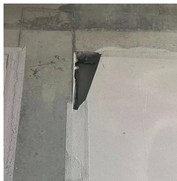
2、墙板固定管卡需提前暗埋，不得外露
