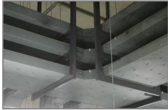
6. 多层桥架使用共用支架安装。
