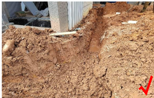
1.水电管线沟槽开挖深度达设计及规范要求。
