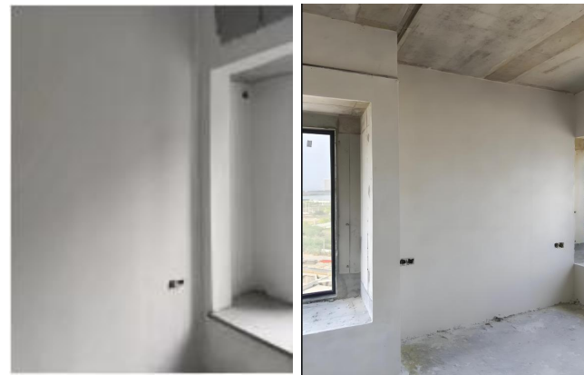
2、气凝胶保温平整、均匀,厚度满足设计要求
