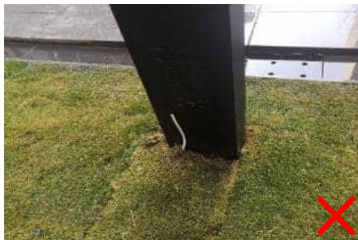
3.地被草坪种植后开挖施工水电管线。
