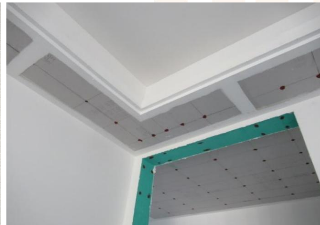
2. 叠级式吊顶底位的转角部位面层石膏板需整张铺设（切割成L型），L角长度不小于300mm
