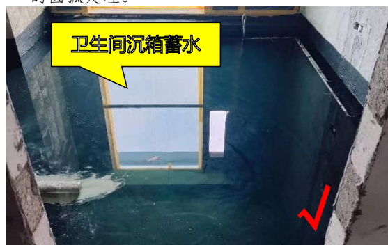
4. 卫生间沉箱一次防水完成后, 进行24小时蓄水试验, 水深30-50mm。
