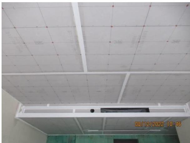
3. 面层板完成后，板间缝隙需控制在4mm-6mm之间。
