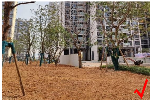
3.使用挖机粗整地，把控整体标高。
