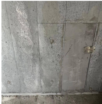
4、墙面垂平度不达标的需完成打磨修补整改
