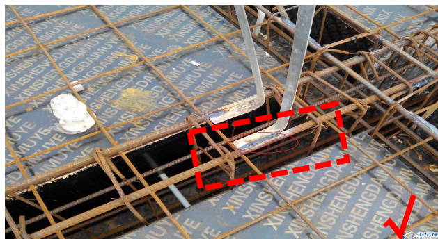
3. 防雷扁铁/圆钢与主筋采用焊接连接, 。
