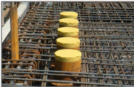
2.穿楼板处预埋刚性防水套管。
