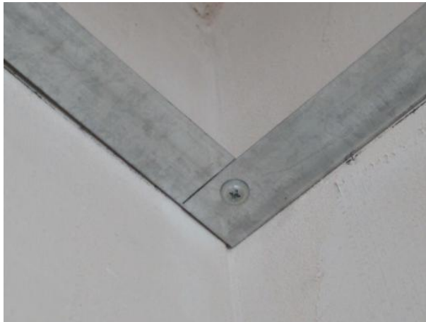
3. 边龙骨搭接处拉铆钉固定
