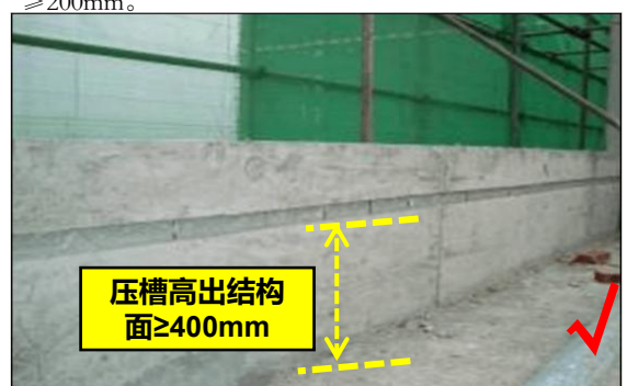
6. 出屋面的墙体泛水槽应结构施工阶段预留, 防水收口压槽高出结构400mm。
