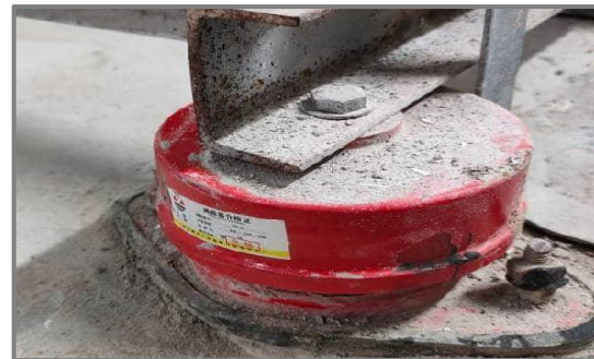
4.共用排烟与通风系统中风机安装减震装置。
