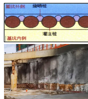
2. 灌注桩桩间旋喷桩组合成墙
