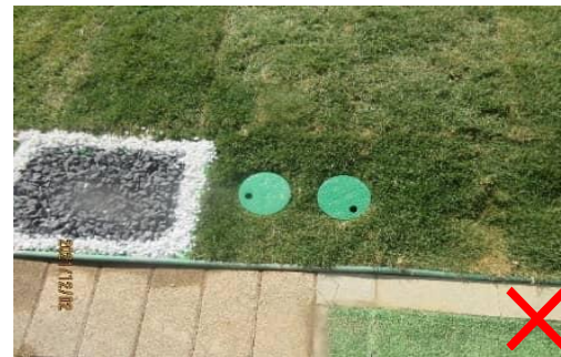
6.取水栓裸露设置在草坪上,使用过程中导致草坪积水。
