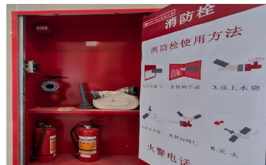
4.栓头安装位置及门开启角度符合要求。
