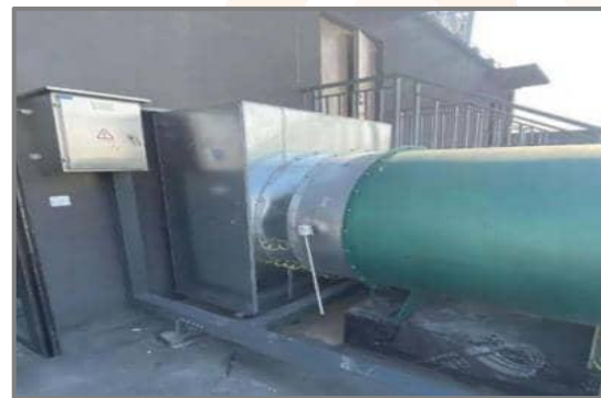
2.独立防排烟系统中风机与风管直接连接。
