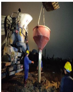
5. 浇筑中逐步提升、分节拆除导管（串管）
