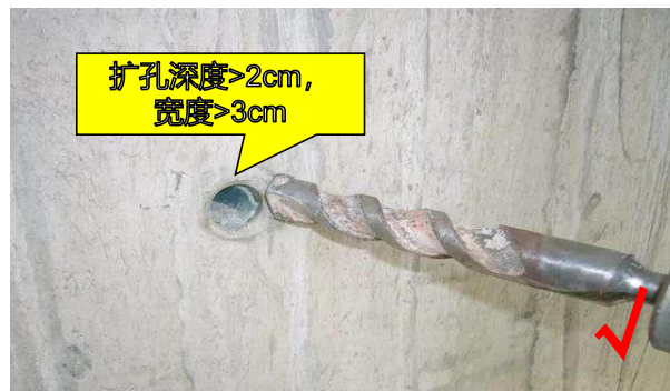
1. 采用普通套管的, 封堵前切除PVC套管并机械扩孔, 扩孔深度 >2\text{cm} , 宽度 >3\text{cm}
