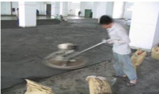
3、使用磨面机(带底板)进行第二次打磨, 将刚铺洒的金刚砂磨平。
