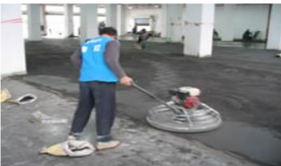
5、使用磨面机(带底板)进行第三次打磨, 在其后的24小时内, 每1-2小时打磨一次, 使用不带底板的钢片磨光
