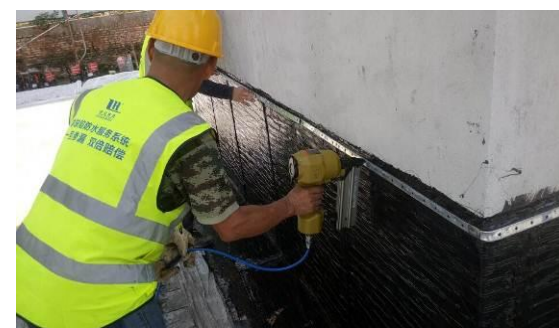
6. 收边及成品保护, 压条嵌入混凝土内收边, 墙地面防水施工后进行保护。
