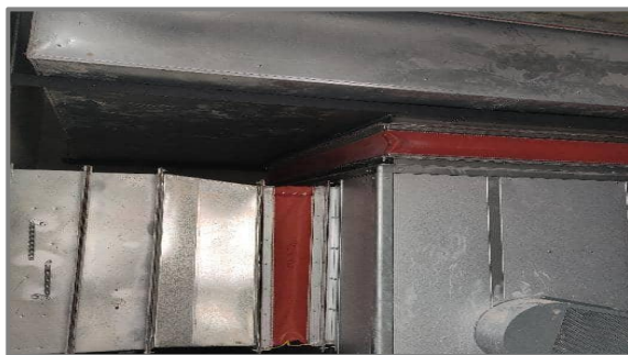
3.共用排烟与通风系统中风机与风管柔性连接。
