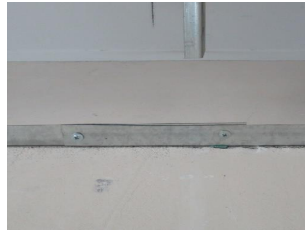
4. 边龙骨连接需牢固，避免出现接头错开、接缝不均匀，角缝不吻合，表面不平整，翘曲、锤印的现象
