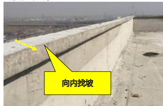
5.压顶抹灰向内找坡 \geq 6\% 。
