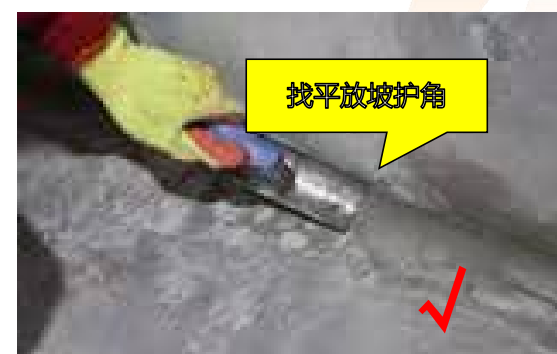
2. 阴角与阳角分别作 R=100\text{mm} 及 R\geq 10\text{mm} 的圆弧处理。
