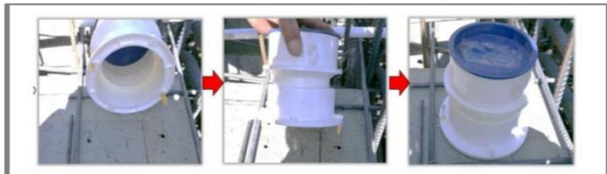
3. 止水节预埋（螺丝固定）。
