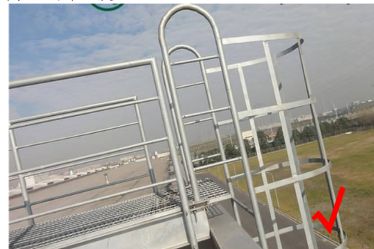
6. 可折叠爬梯采用304不锈钢材质, 间距宽度等均应符合规范要求, 设置防护圈
