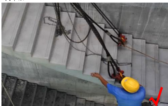
5. 就位时楼梯板应从上垂直向下安装, 在作业层上空300mm处略作停顿, 停稳慢放
