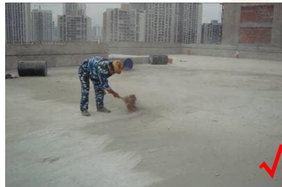
2. 基层处理, 应将表面垃圾清理干净, 分隔缝顺直, 并做好分隔缝处理。
