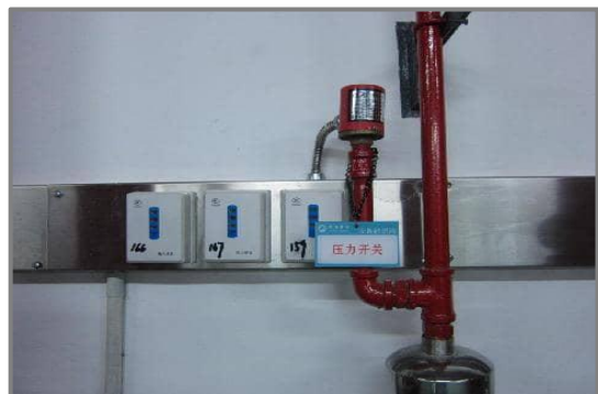
6.线缆采用不锈钢软管及线槽敷设
