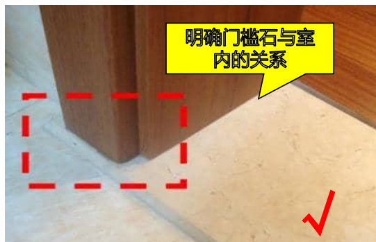
1.门槛石先铺标高控制恰当,两侧门套线条落在门槛石上,收口合理。
