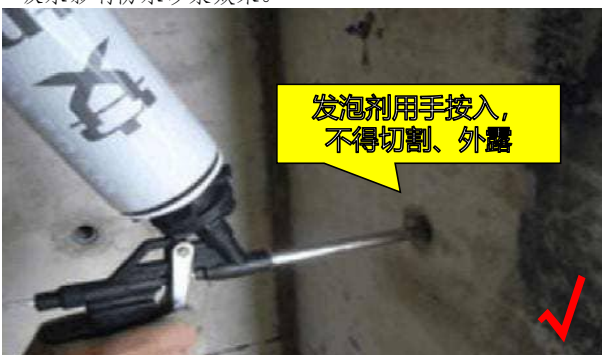
5. 内侧打发泡剂填充密实, 发泡剂不得切割、外露。
