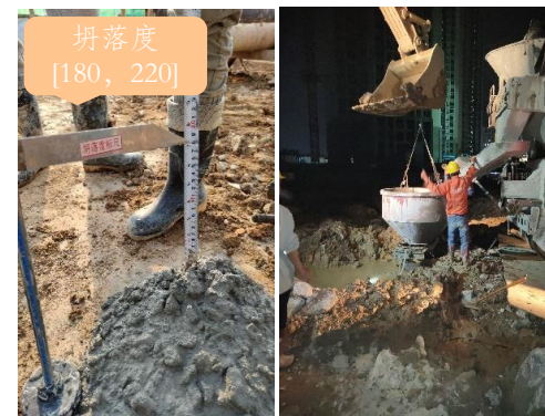
4. 混凝土坍落度检验、浇筑混凝土。
