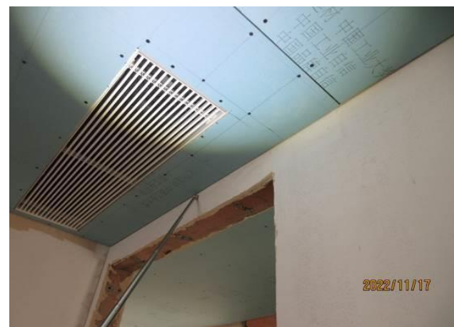
4. 吊顶石膏板与墙体交接预留5-8mm伸缩缝，腻子批刮前采用嵌缝石膏、牛皮纸等进行嵌缝
