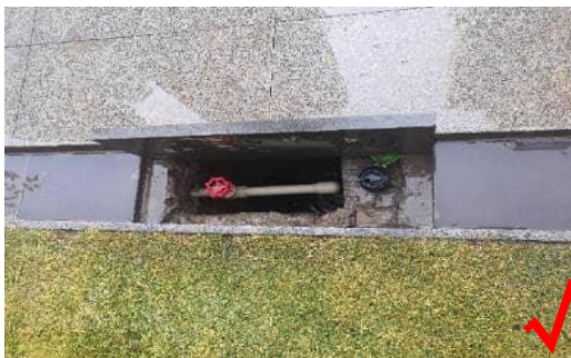
5.要求取水栓与排水设施相结合,避免积水。
