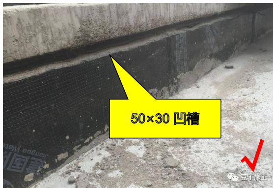
3.泛水高度位置留设 50\times 30 凹槽,防水卷材贴至此处,采用金属压条固定。
