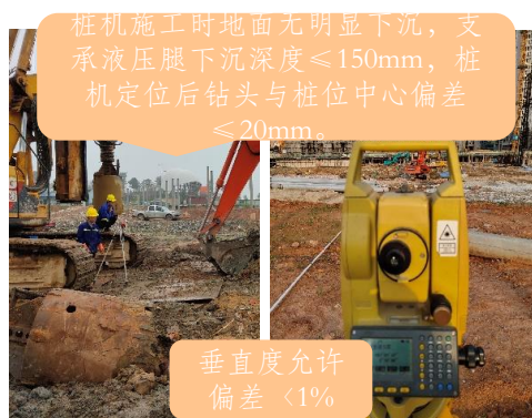
1. 旋挖机就位，桩位及垂直度校核
