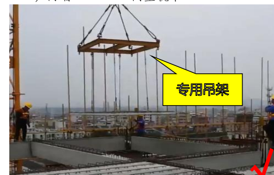
4. 应使用吊架进行吊装, 任一边长 > 2.5 m, 应以6点起吊, 吊装顺序应按设计要求顺序
