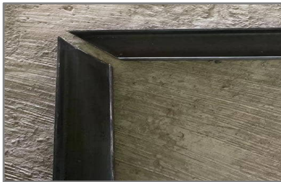
1. 支、吊架切割平整。
