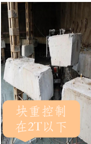
4. 切割、块体拆卸、叉车运输、吊车运输
