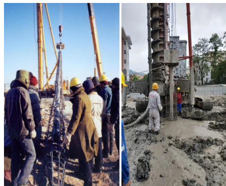
3. 钢筋笼吊运、插入(可振动插)。
