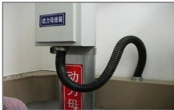
1.出线使用金属软管套锁母固定。
