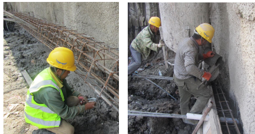
3. 第二道腰梁支模绑扎钢筋、浇筑
