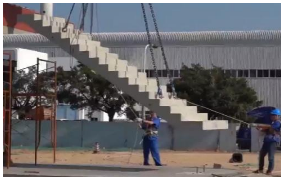
4. 吊装时, 应使踏步平面呈水平状态, 吊点数不少于4个
