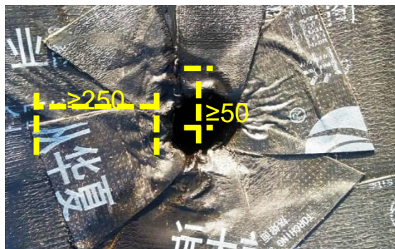
5. 落水口及地漏设置卷材附加层，宽度为250mm，伸入落水口杯内 \geq 50\text{mm}
