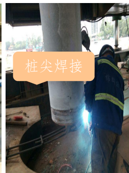
1. 桩位定位测量放线、移机就位、焊桩尖
