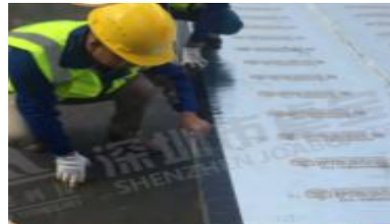
4. 防水卷材预铺, 扣除8-10cm搭接边弹线
