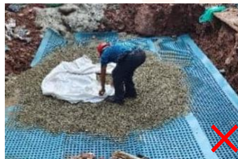
2. 树穴底部设置10-15cm的碎石层。
