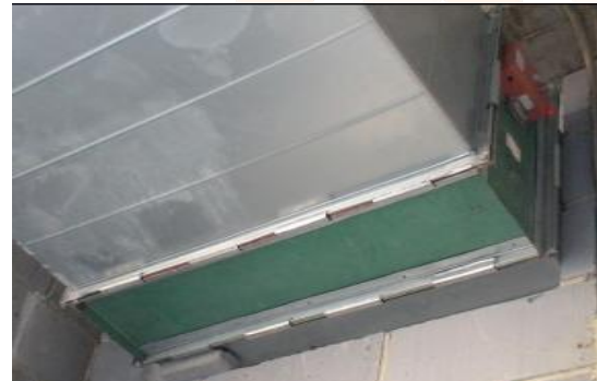
2.风管弹簧夹分布均匀，紧固牢靠。
