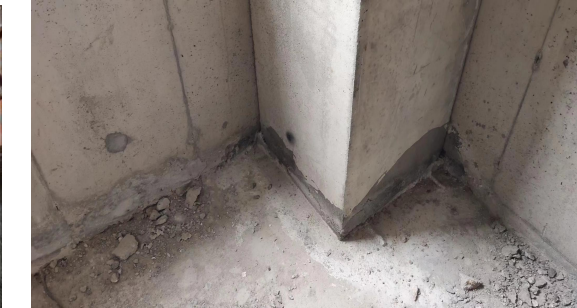
6. 排气道安装完毕,由土建单位封填排气道与楼板之间的缝隙,并做好防水处理。
