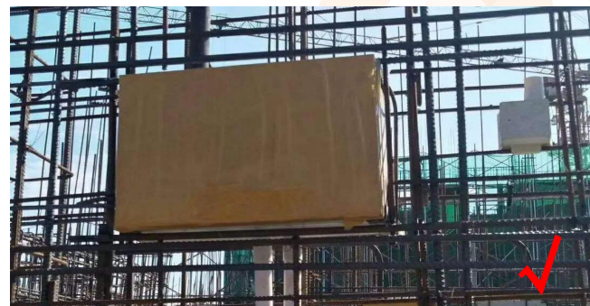
2. 建议优化结构布置, 电箱一次预埋, 做好箱内支撑及保护
