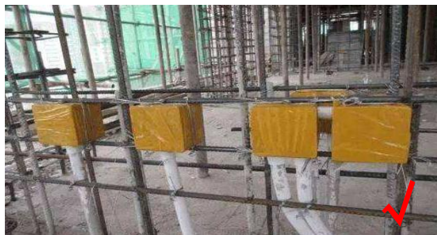
1. 线盒的水平短钢筋绑扎于主筋上, 盒口与模板面平齐, 推荐采用穿筋线盒
