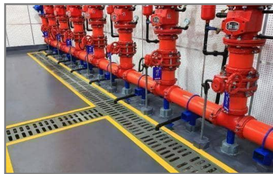
5.报警阀安装有序、采用间接排水。
