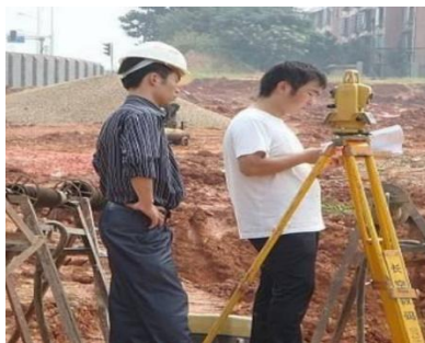
1. 测量放线、定开挖顺序
