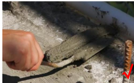
2. 吊装前校正偏位钢筋, 复核预留钢筋长度及标高, 黏贴橡塑胶条, 铺设坐浆料
