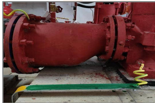
2.水泵吸水管采用管顶平接方式。
