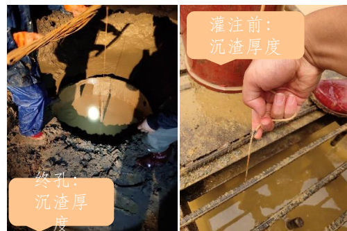
6. 沉渣厚度检测。用测绳末端重物触探：端承桩 \leq 50\text{mm} ，摩擦桩 \leq 100\text{mm}
