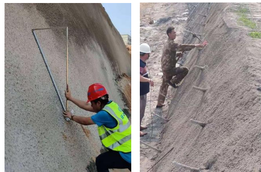
6. 边坡成型质量抽查。坡率、面层厚度、注浆深度复核
