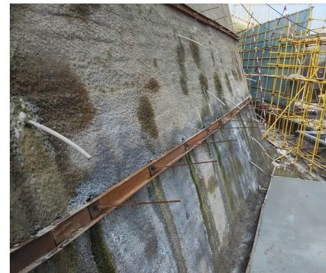
6. 预应力锚杆复合土钉墙全景
