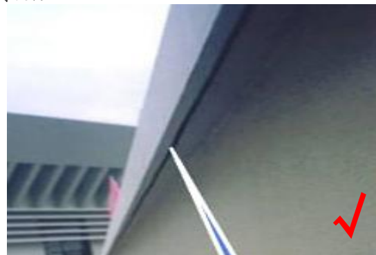
4.压顶线条收面处理,如突出墙面宽度大于50mm设滴水线,小于50mm设鹰嘴。
