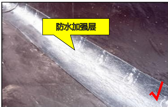
3. 大面施工前, 侧地漏、防水阴角、管根做防水加强层处理。
