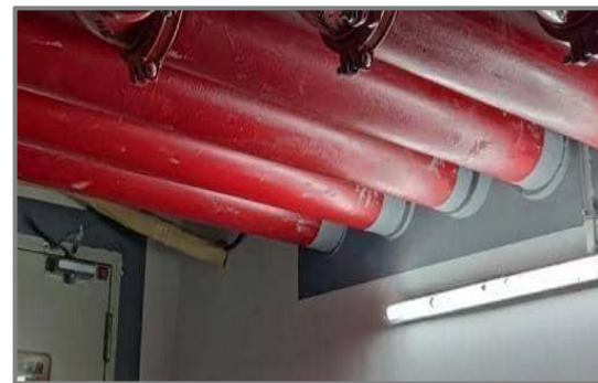
6.顶部不喷灰时穿墙管道周边喷灰处理
