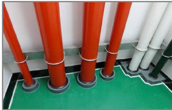
1.立管穿楼板处套管高度>20mm。
