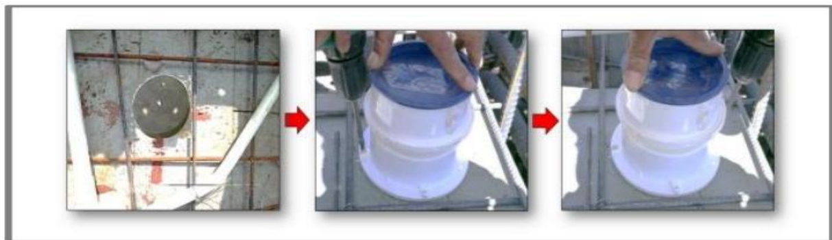
4. 止水节预埋（橡胶块固定）。
