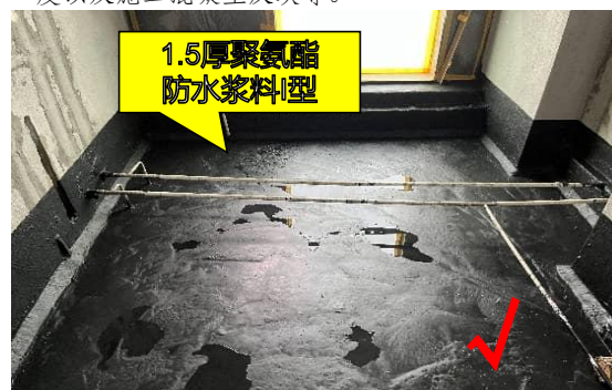
3. 1.5厚单组份聚氨酯防水浆料I型, 上铺15厚1:2.5水泥砂浆保护层。
