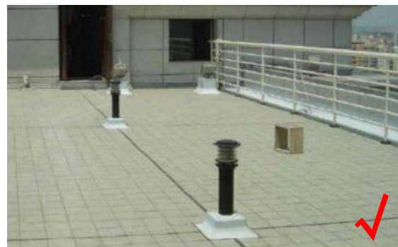
4. 面砖粘贴过程中应通过结合砂浆的厚度控制面砖表面的平整度。
