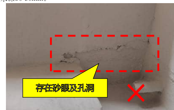
6. 防水成膜不能存在气泡、夹渣、透底、脚印、粉化现象。
