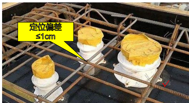
5. 卫生间、阳露台宜预埋止水节, 止水节定位中心线偏差不大于1cm。
