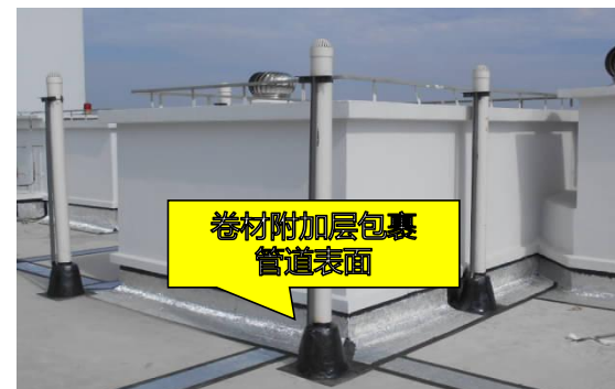
6. 卷材附加层包裹管道表面，附加层从阴角开始上反和水平延伸各 \geq 250\text{mm}
