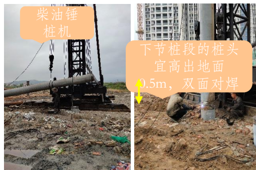
3. 第二节桩吊运、焊接、施打。
