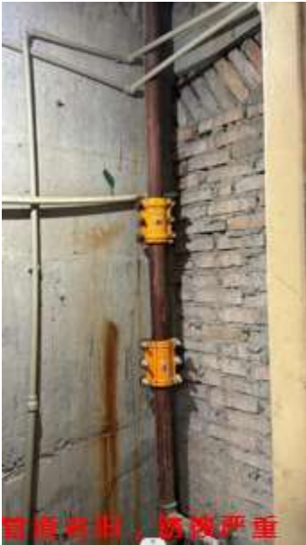
管网老旧锈蚀
