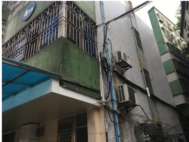
管网老旧锈蚀
