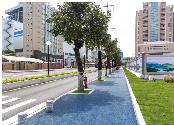
透水混凝土路面实景图
