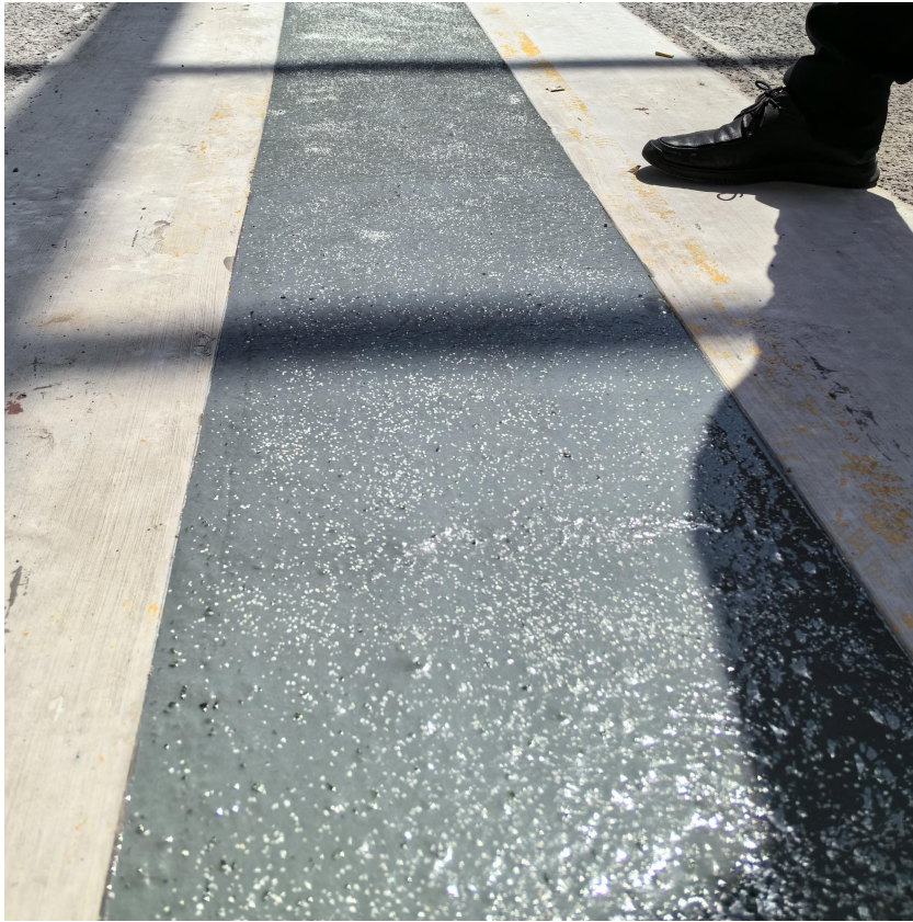
桥梁无缝式伸缩缝案例
