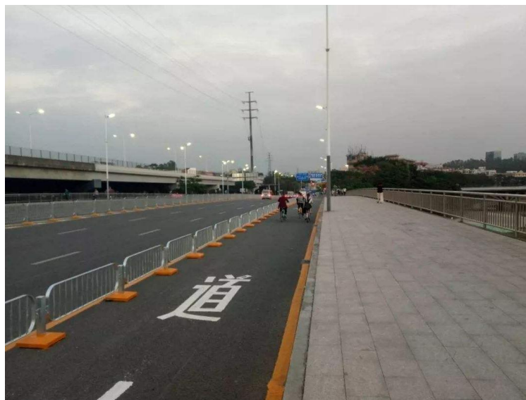
桥上人行道采用路缘石分隔设置实例
