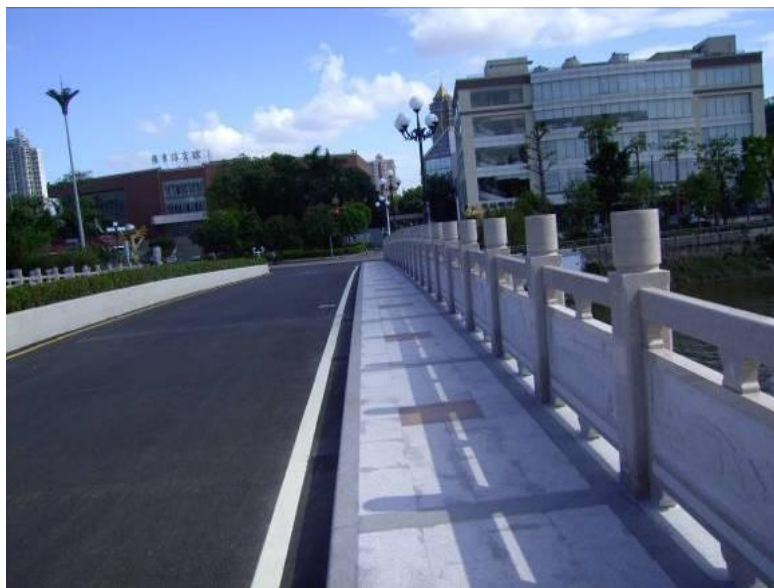
车行道桥面铺装实例
