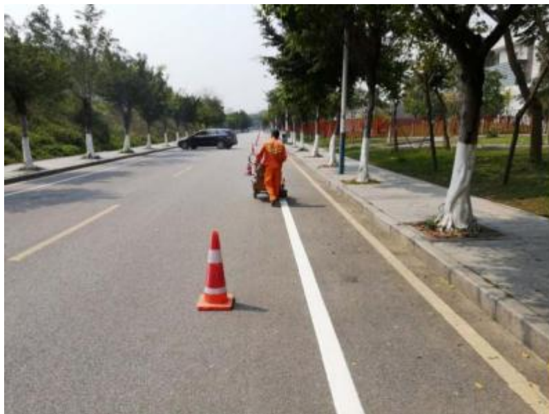
标线现场施工实例
