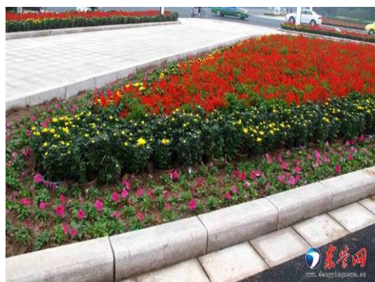
混凝土侧、平石实景图
