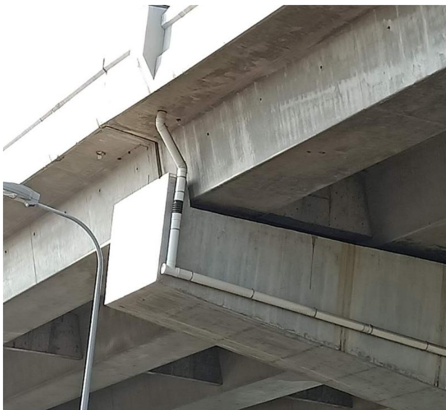
跨涌桥桥面排水实例
