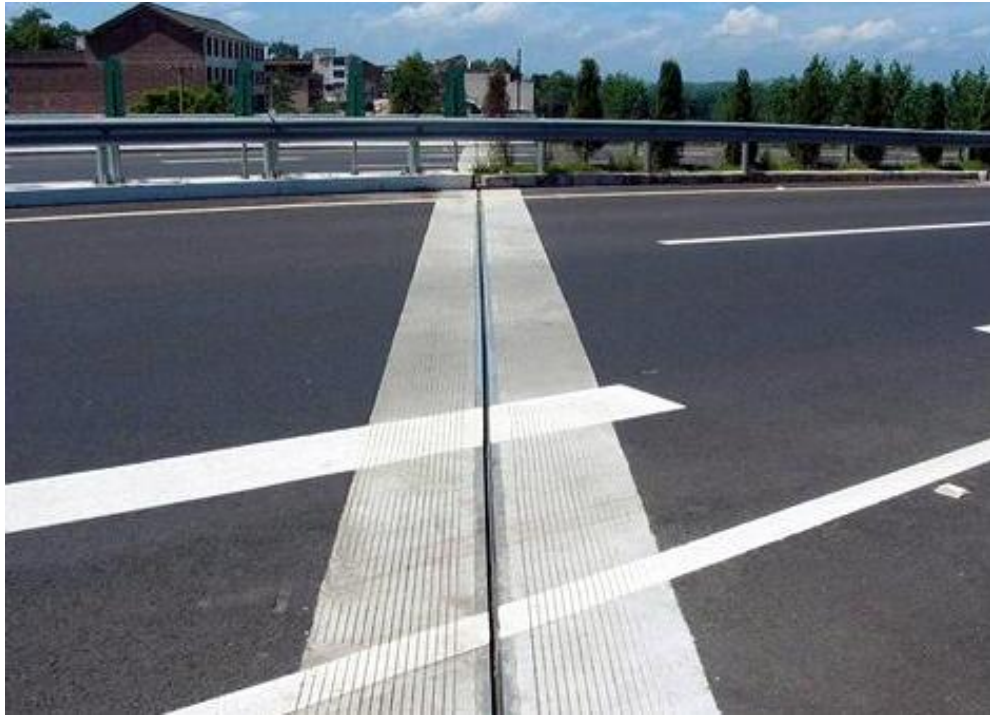
桥梁单缝式伸缩缝案例
