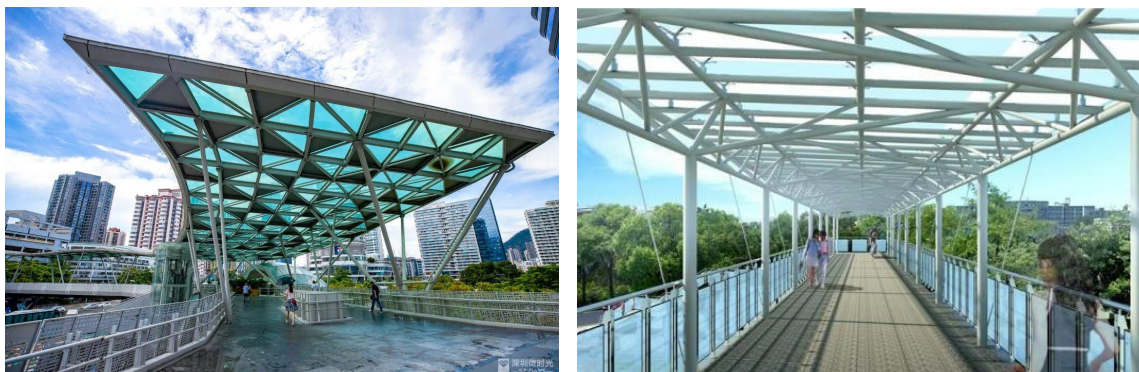
景观连廊、天桥雨棚实例
