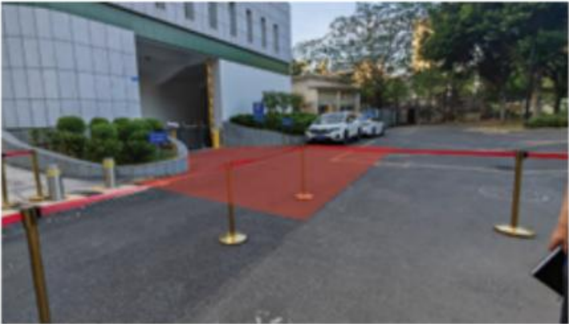
图 4-25 北校区车库出入口现状
