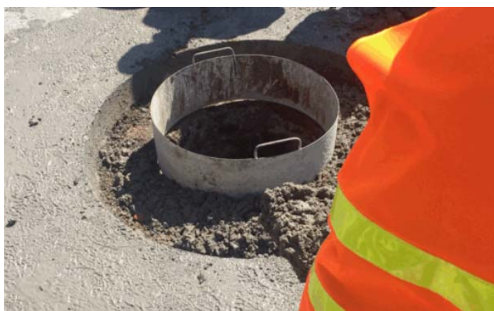
混凝土回填
