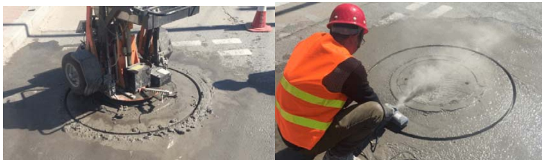
切割机及人工破除路面
