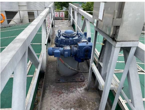
图：浓缩机电机减速机漏油照片
