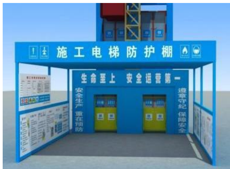
工具式施工电梯防护棚
