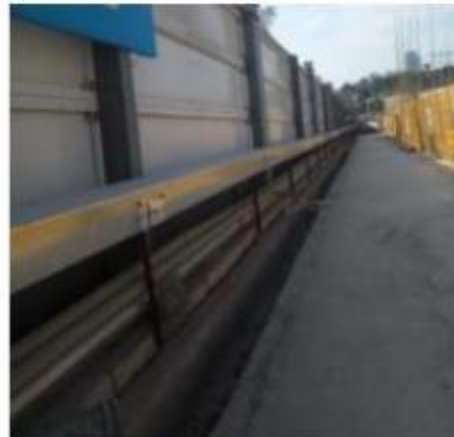
电缆线沿墙壁敷设示意图
