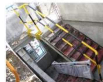
预制楼梯防护
