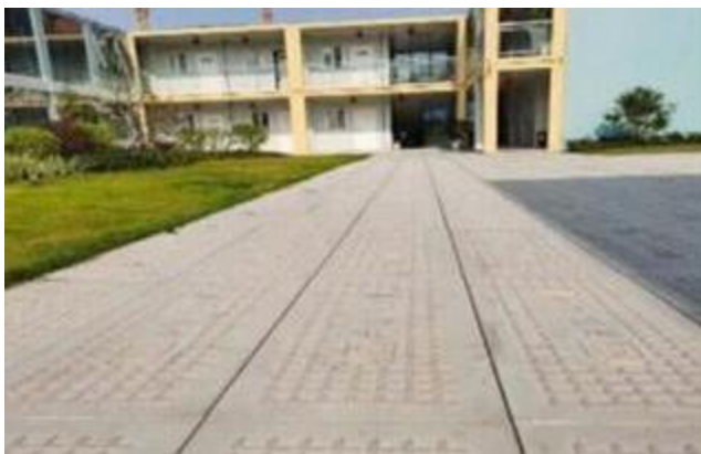
预制混凝土路面
