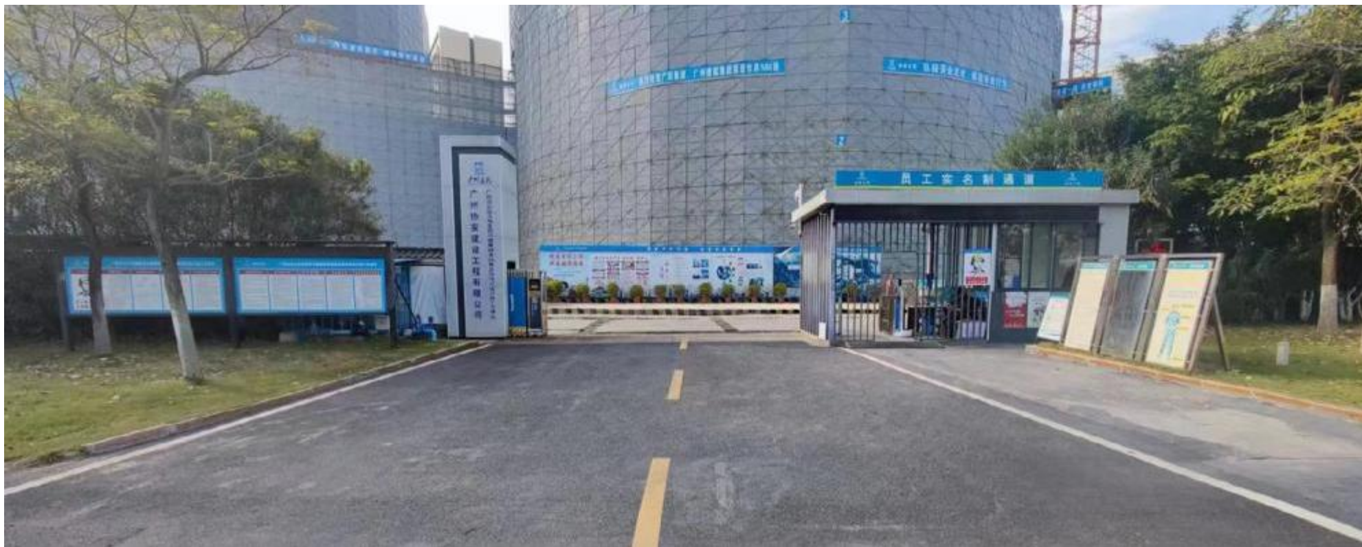
施工区出入口
