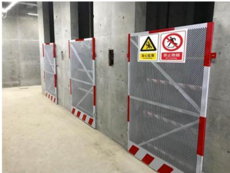
电梯井洞口立面防护
