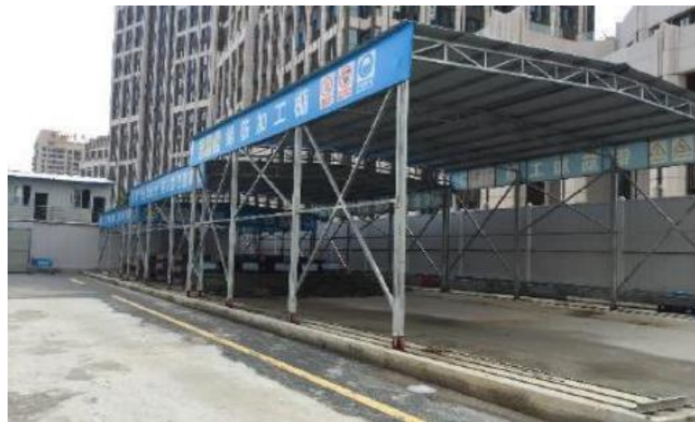
工具式钢筋加工场（地铁项目）
