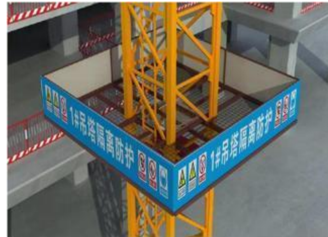
定型化塔吊防攀爬装置2
