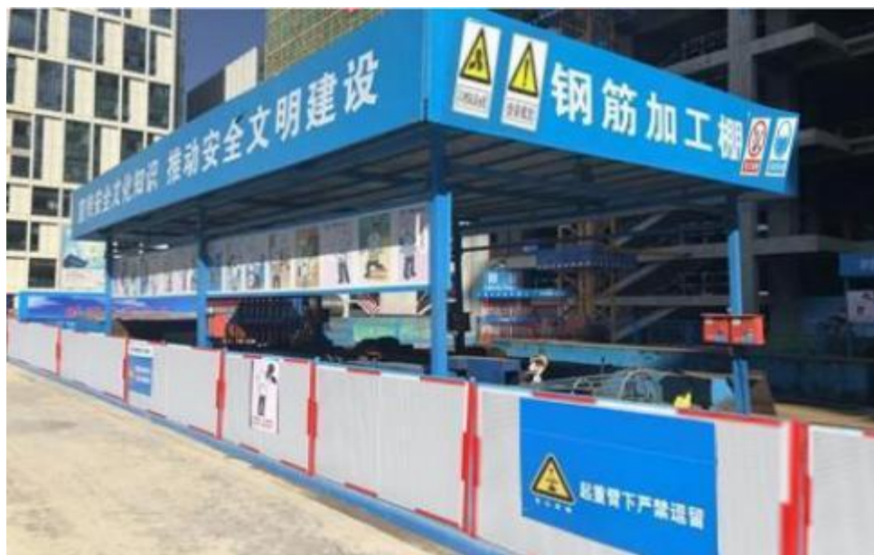
工具式钢筋加工场（房建项目）
