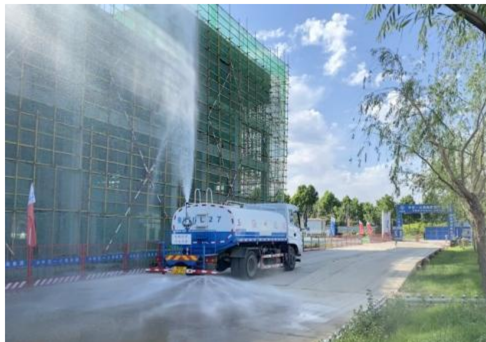
洒水车洒水降尘
