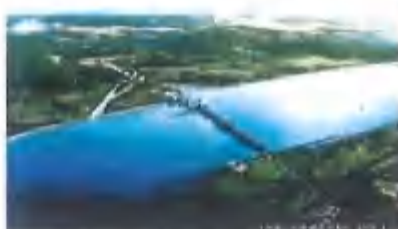
赣江石虎塘航电枢纽
