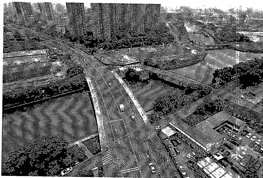
现状龙溪中路桥梁
