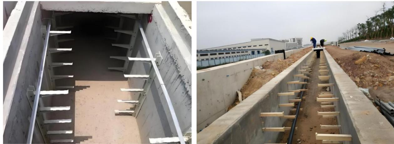
图 2.1.2 电力管沟内部高压线缆布设
