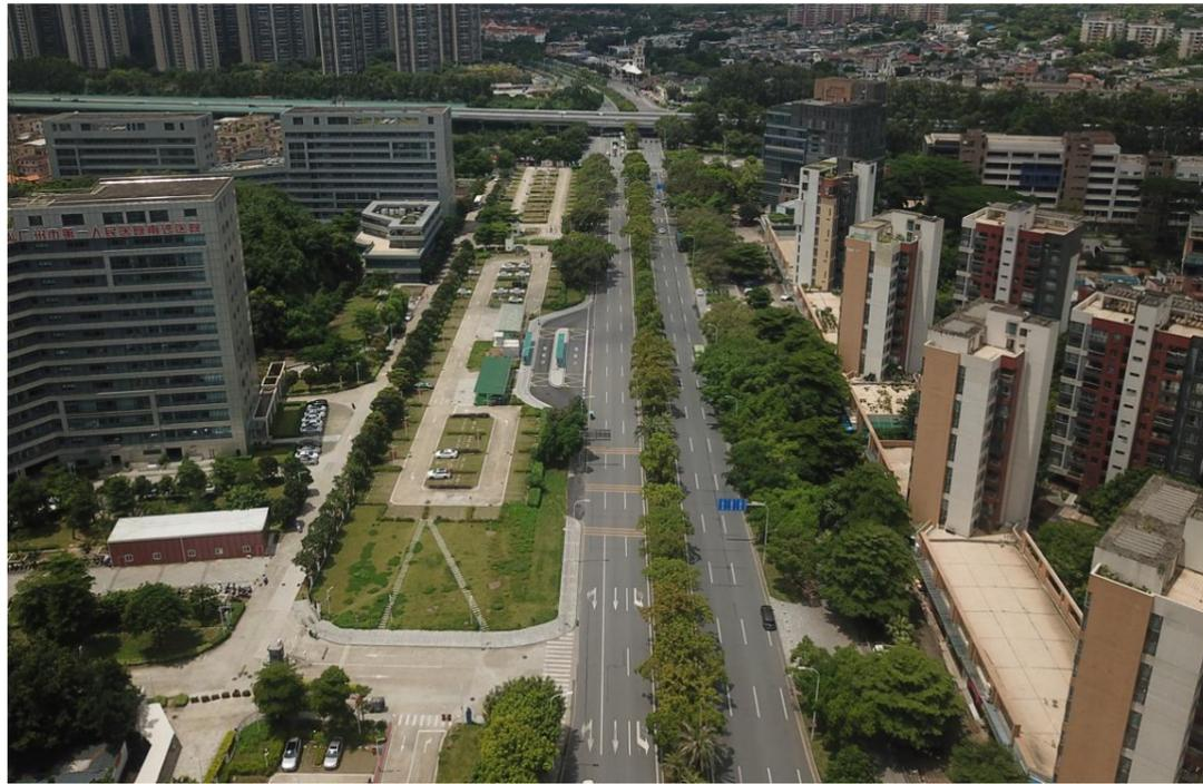
根据现场踏勘，目前黄阁南道路路灯照明设施比较齐全，道路为单向三车道，路灯杆高度约 12 米。路灯灯杆间距按 36m 布设。
