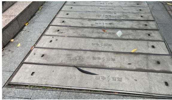
图 4.2.16 现状地下电力管线
