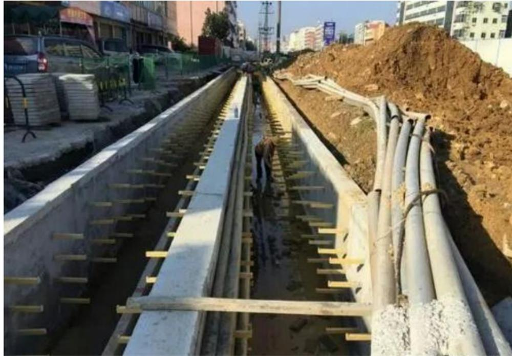
图 14.12.2 电力管沟明挖法施工示意图
