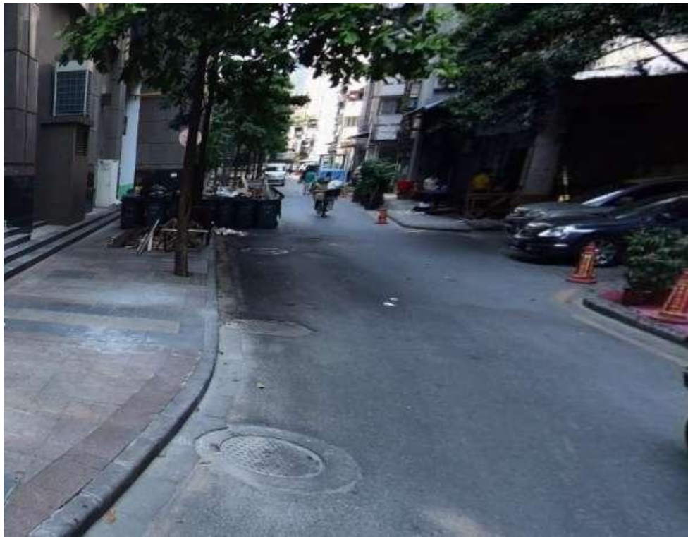
朝阳小区现场照片
