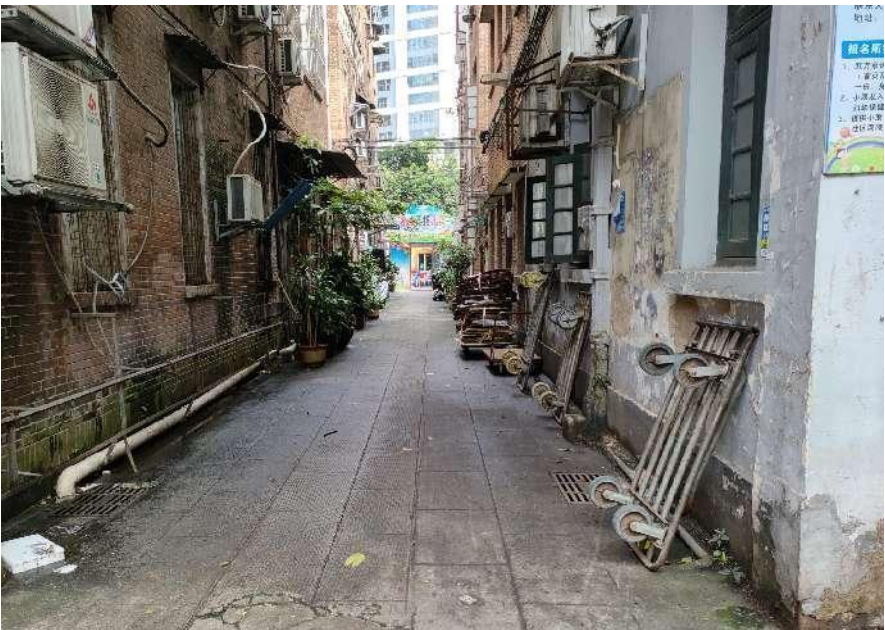
青莲里社区现场照片
