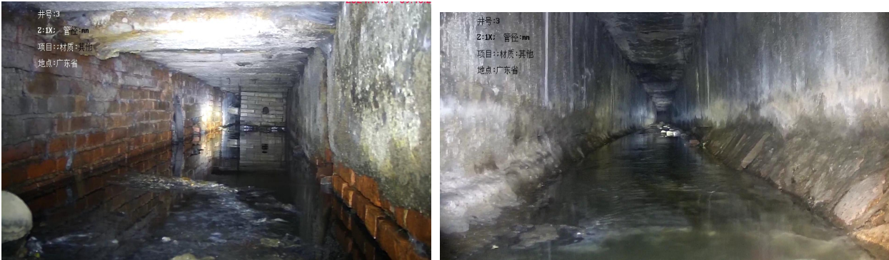
临近铁路旁的现状渠
