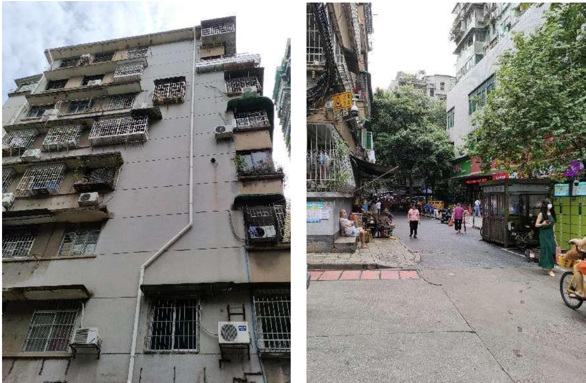
敬福巷小区现场照片
