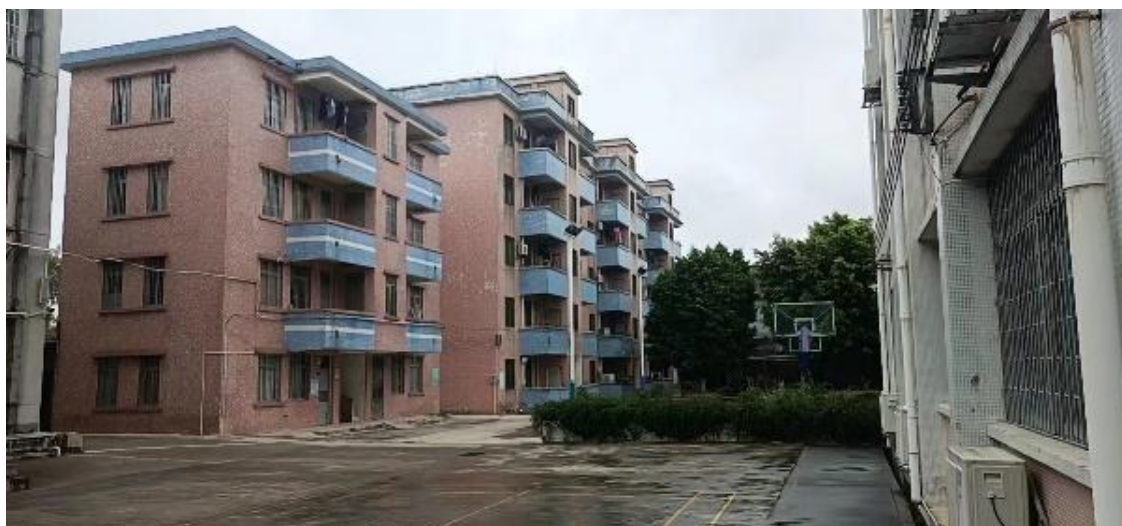
图 4.2.4-2 现状迳口中学教学楼
