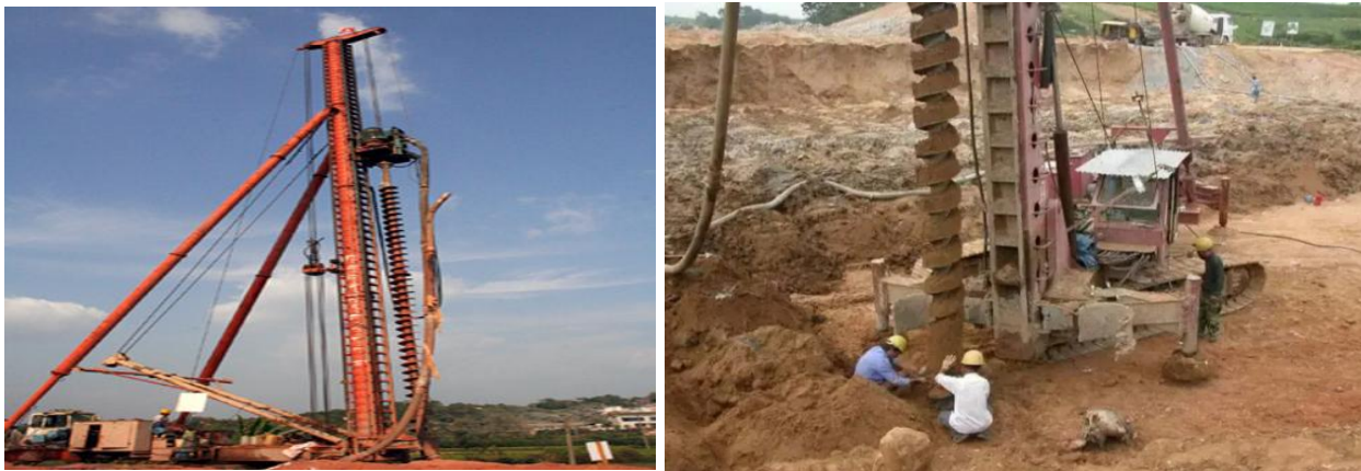
图 5.29 CFG 桩施工实例
