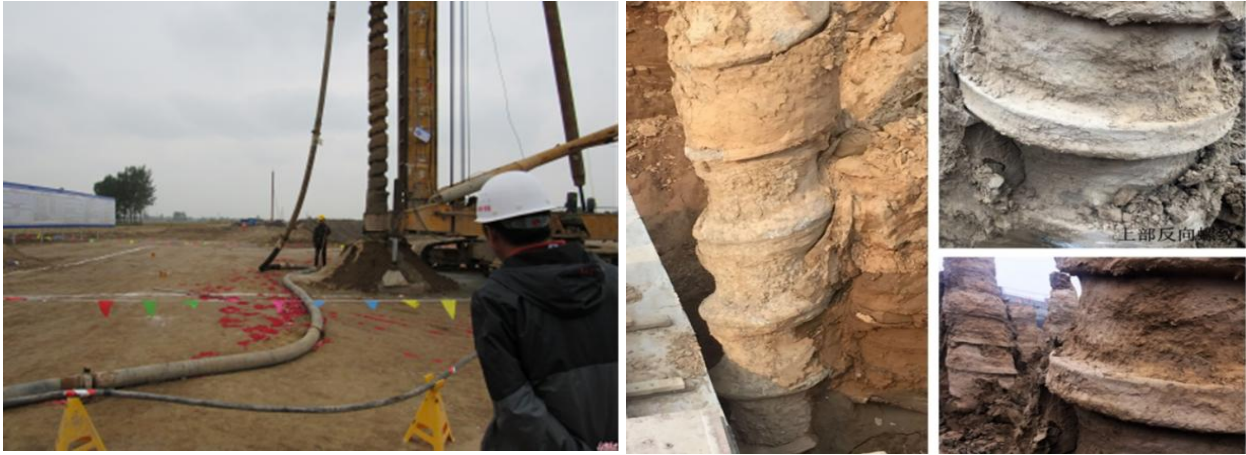
图 5.28 变截面挤密螺纹桩施工实例
