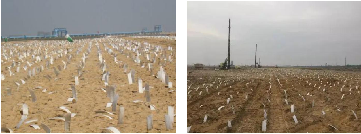
图 5.24 堆载预压施工实例
