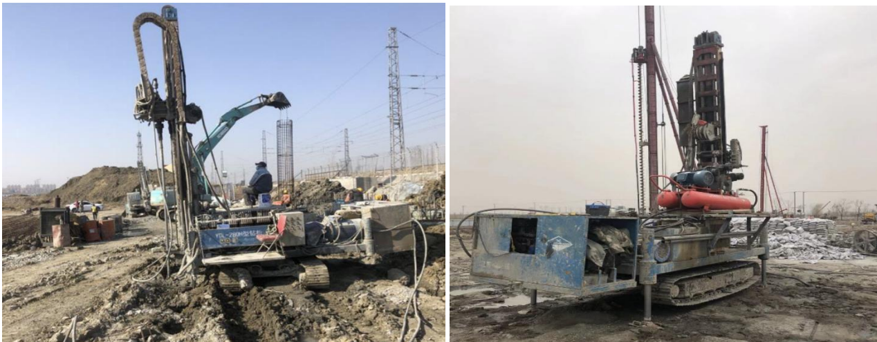
图 5.31 袖阀管注浆施工实例
