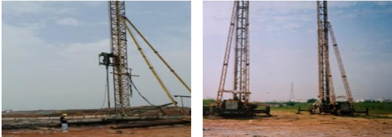
图 5.26 水泥搅拌桩施工实例
