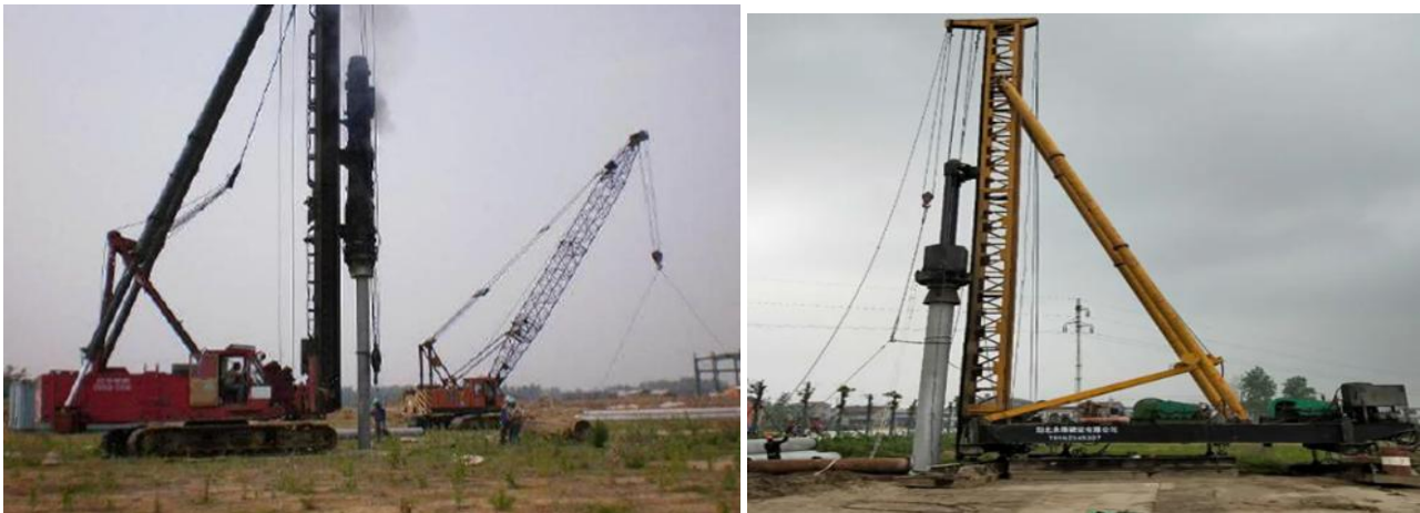
图 5.30 预应力管桩施工实例
