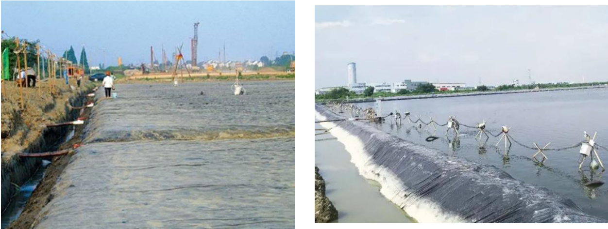
图 5.25 真空联合堆载预压施工实例
