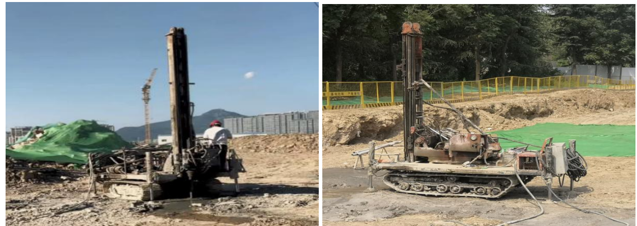
图 5.27 高压旋喷桩施工实例
