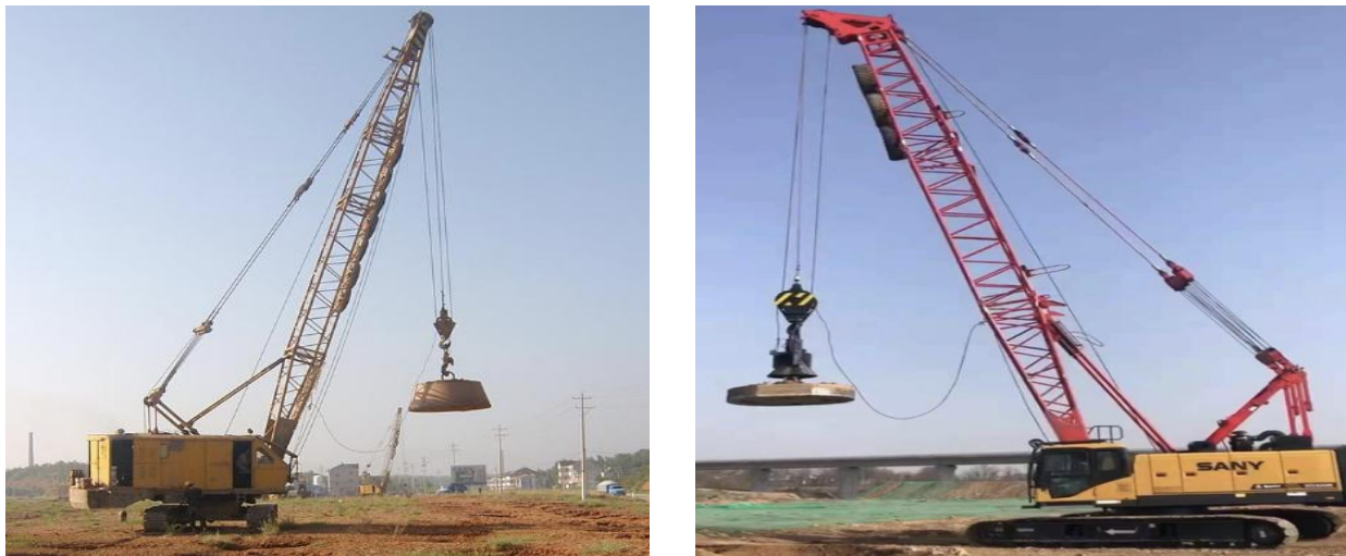
图 5.32 强夯施工实例
