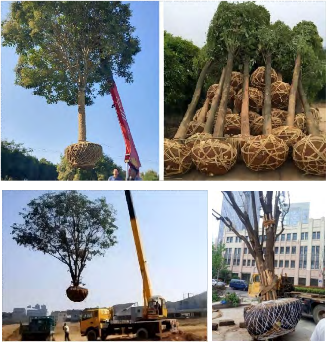
图5.5-5 树木吊运装车示意图
