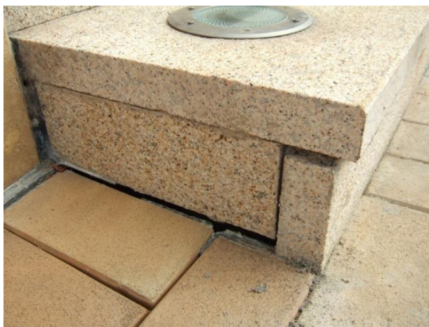
图 1-11 构筑物边缘出现沉降
