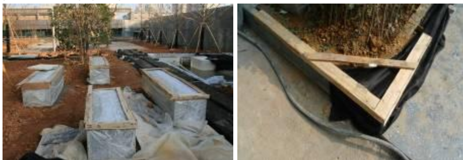
挡墙、座凳及树池的护角保护
