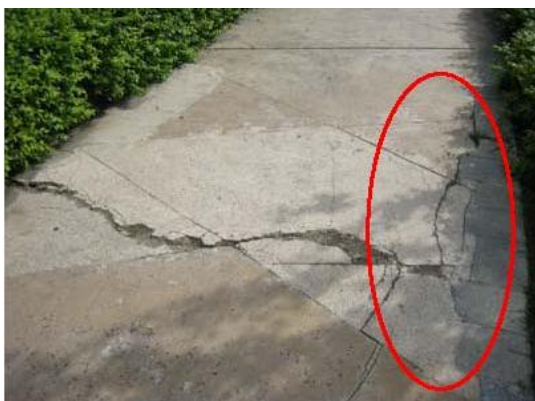
图 1-3 路面边缘开裂下陷
