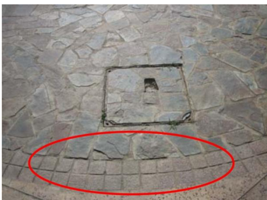
图 2-3 捆边石材规格较小与冰裂纹铺装组合不协调 图 2-4 不同材质之间色彩搭配效果不佳
