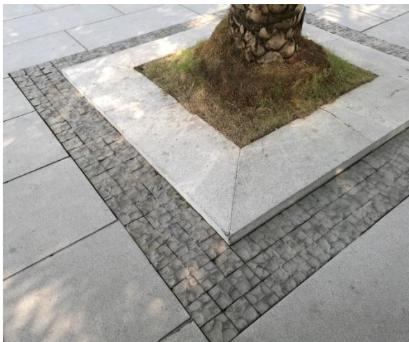
图 2-6 未勾缝导则石材松散
