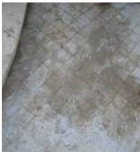
图 2-9 铺装受水泥砂浆污染
