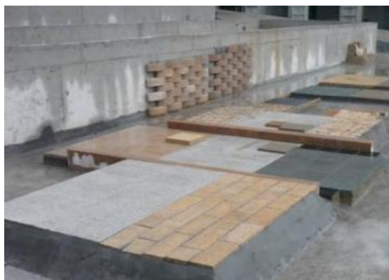
各种铺装样式皆需制作样板
