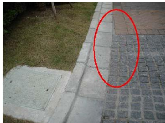
图 1-4 路面与路缘石之间材料混乱
