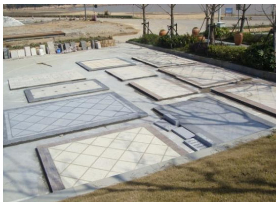
各种铺装样式皆需制作样板
