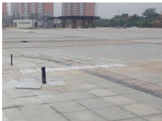
图 2-3 捆边石材规格较小与冰裂纹铺装组合不协调 图 2-4 不同材质之间色彩搭配效果不佳
