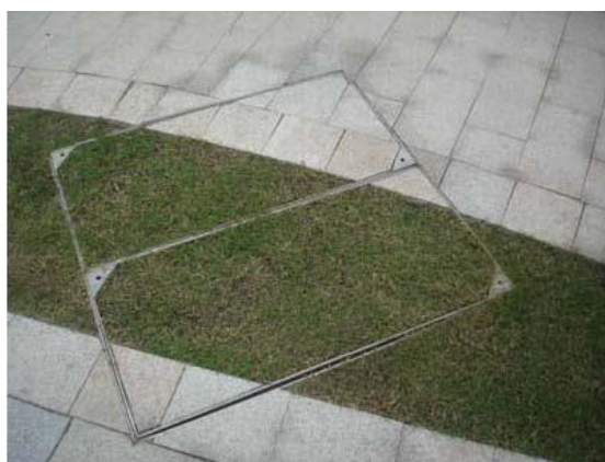
图 1-5 管井位置与铺装平面冲突
