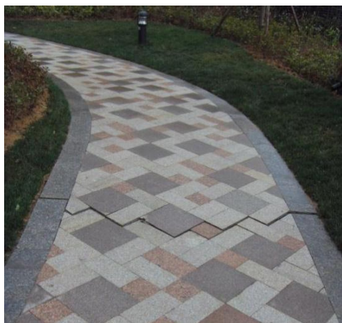
图 1-10 地下车库交界处顶部道路开裂
