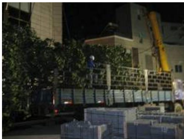
图 2-10 铺装施工完成后仍使用大型设备对面层造成损坏
