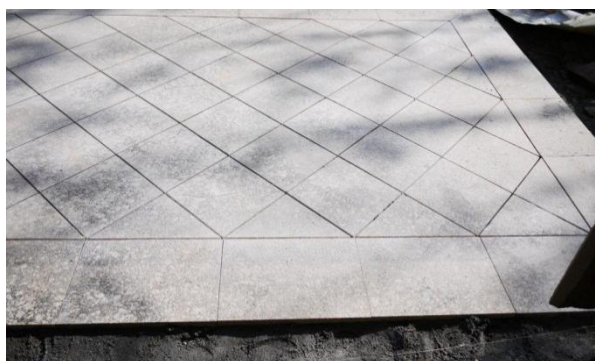
走边板精确计算，保证斜铺也全部对缝；
