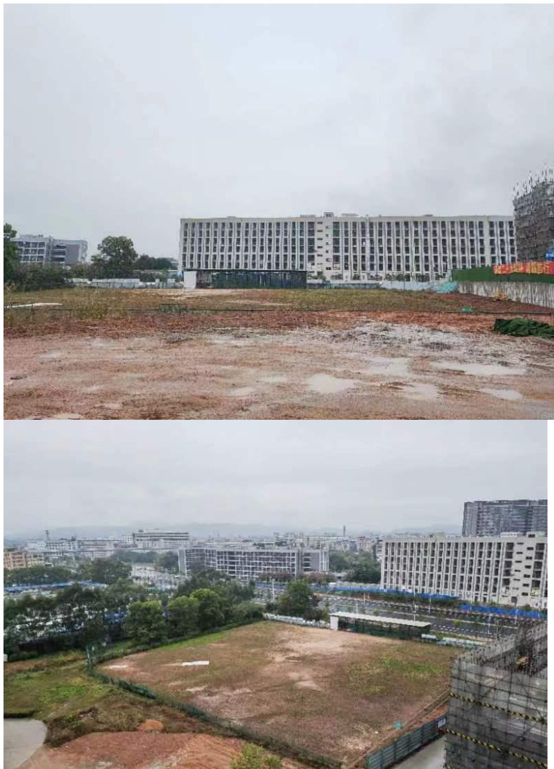
图 4-1-3 项目场址现状图
