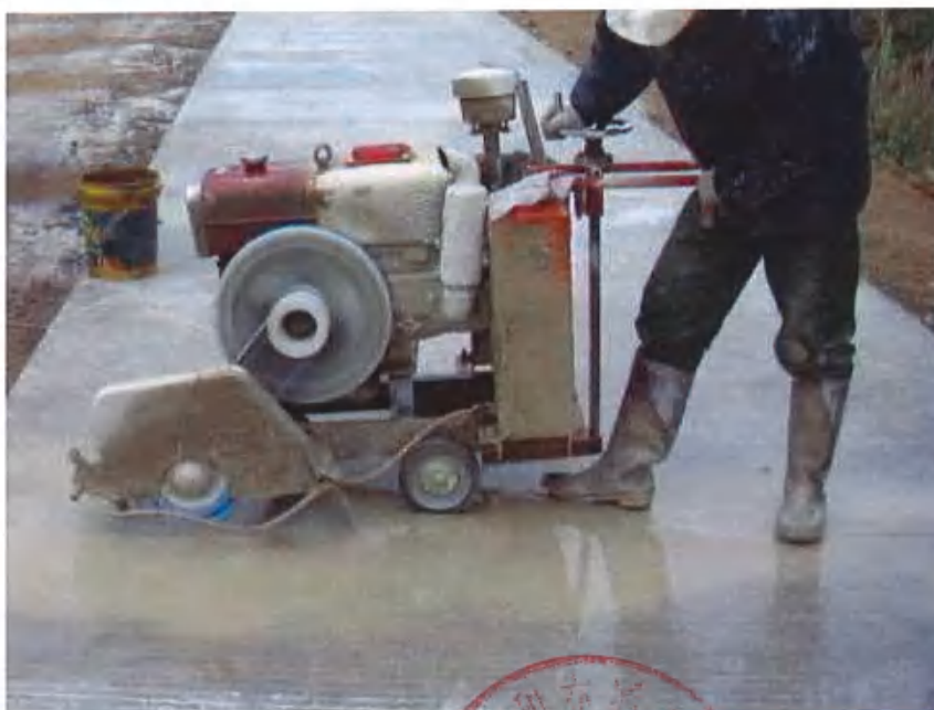
混凝土路面锯缝
