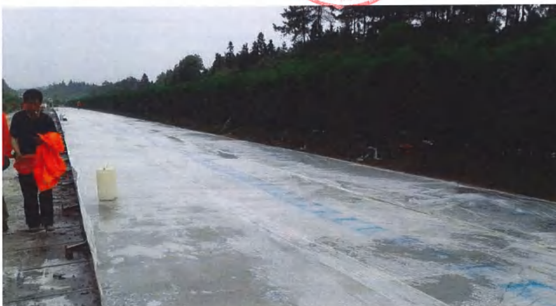
混凝土路面养护
