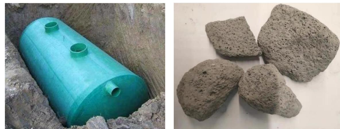
图 5-22 深度厌氧生物法单体处理设备（左）和脱氮除磷合成填料（右）
