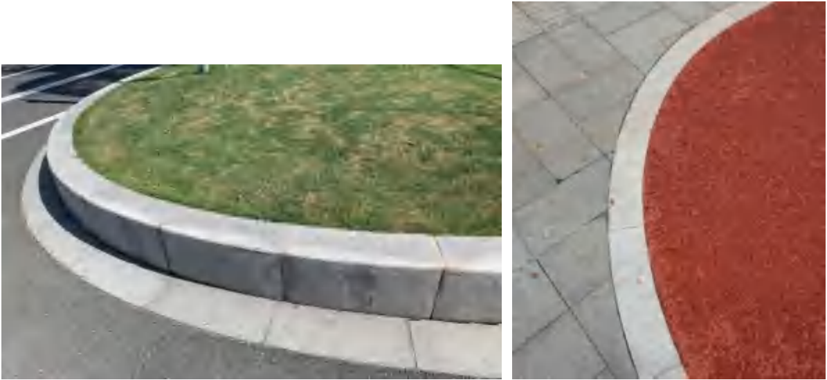
弧形侧石、平石及压条示意图
