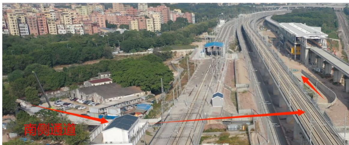
（一期）工程已实施的中部人行通道
