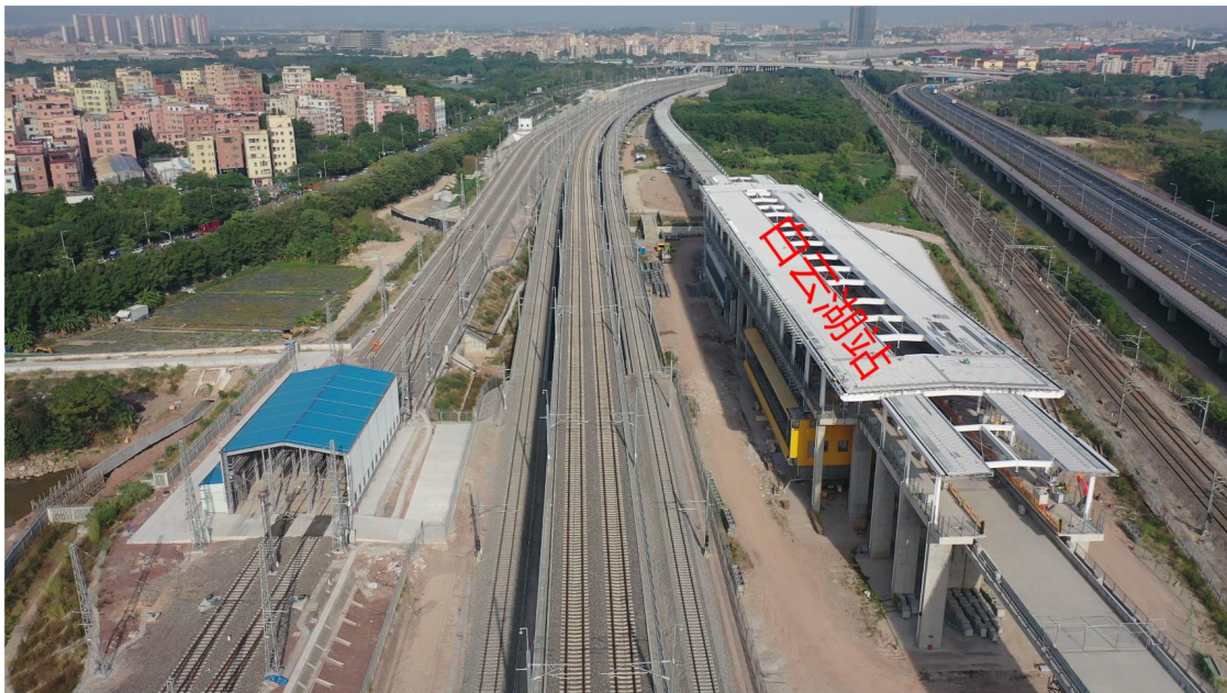
广清城际白云湖站建设现状
