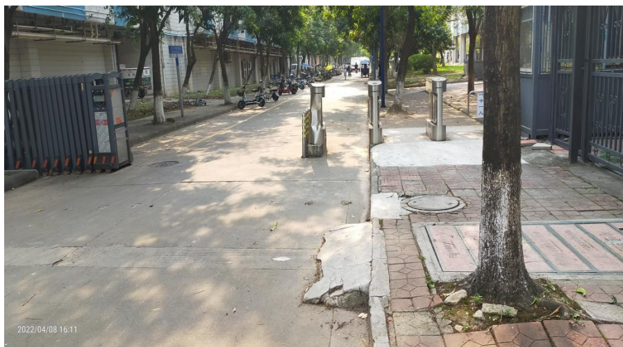
图 3-33 路面破损
