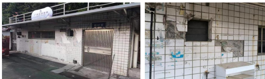
图 3-14 器材室及厕所外墙
