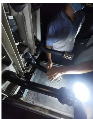
图 3-3 断路器动静触头断裂
