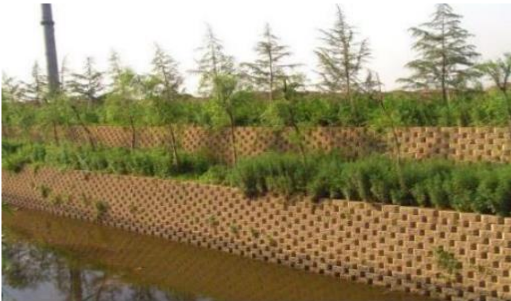
图 7.3.9 自嵌式挡土墙安装效果图
