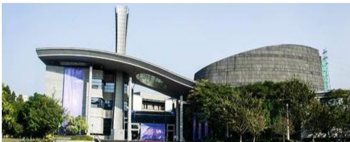
建筑主体外墙老化破损明显
