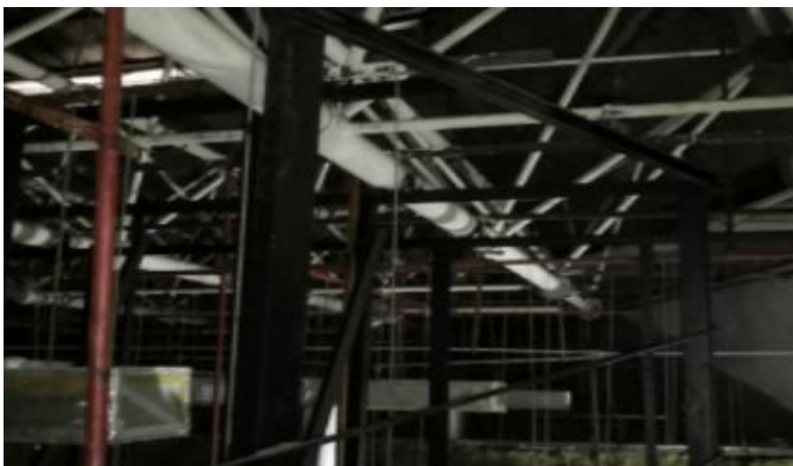
保温夹层松散、暴露，影响使用和整体效果
