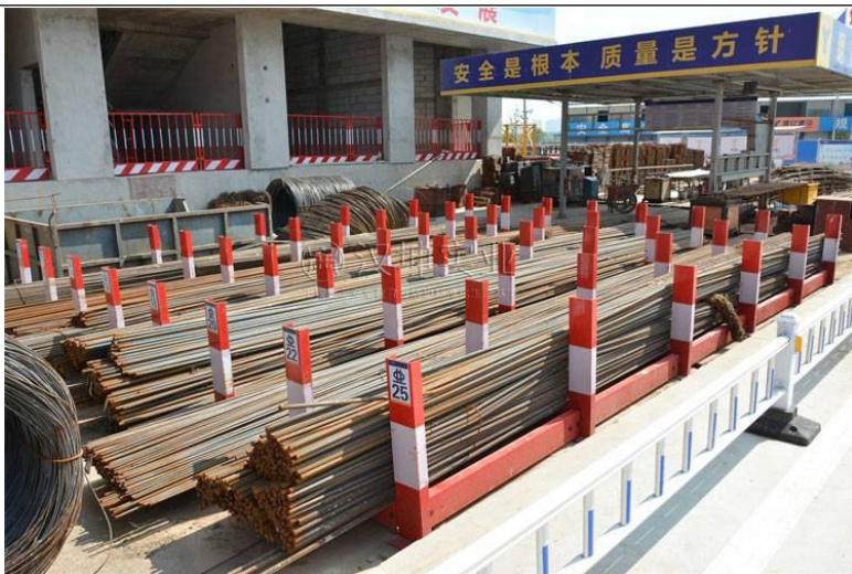
钢筋原材料堆放示意图
