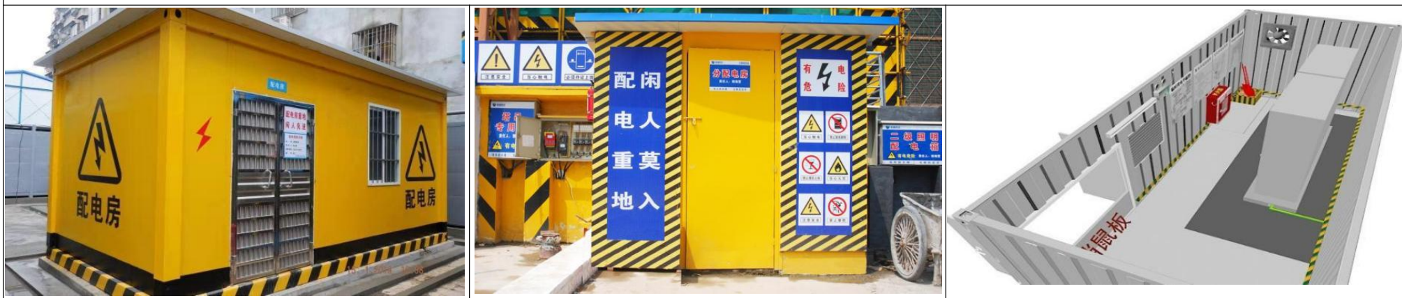
构筑物式配电室示意图
