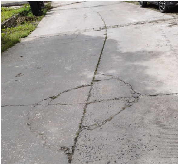
图 2 板角断裂
