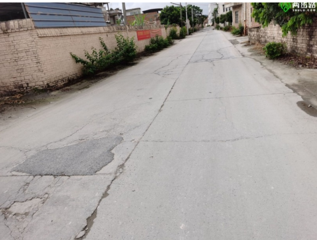
图 4 裂缝
