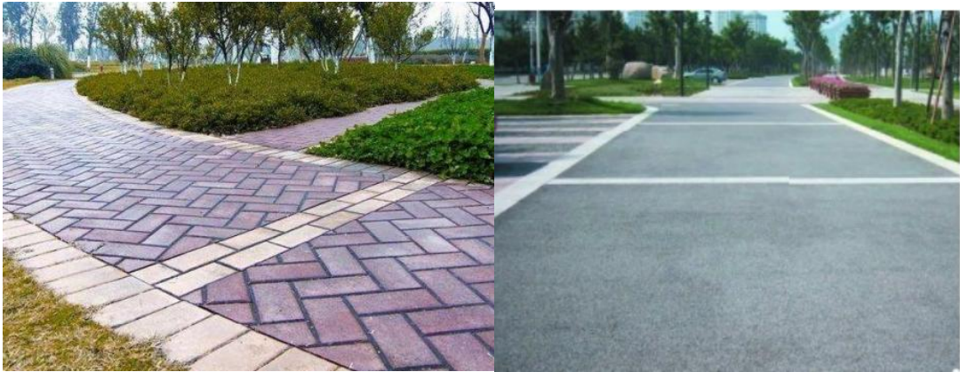
图 14.3.3 透水铺装示意图
