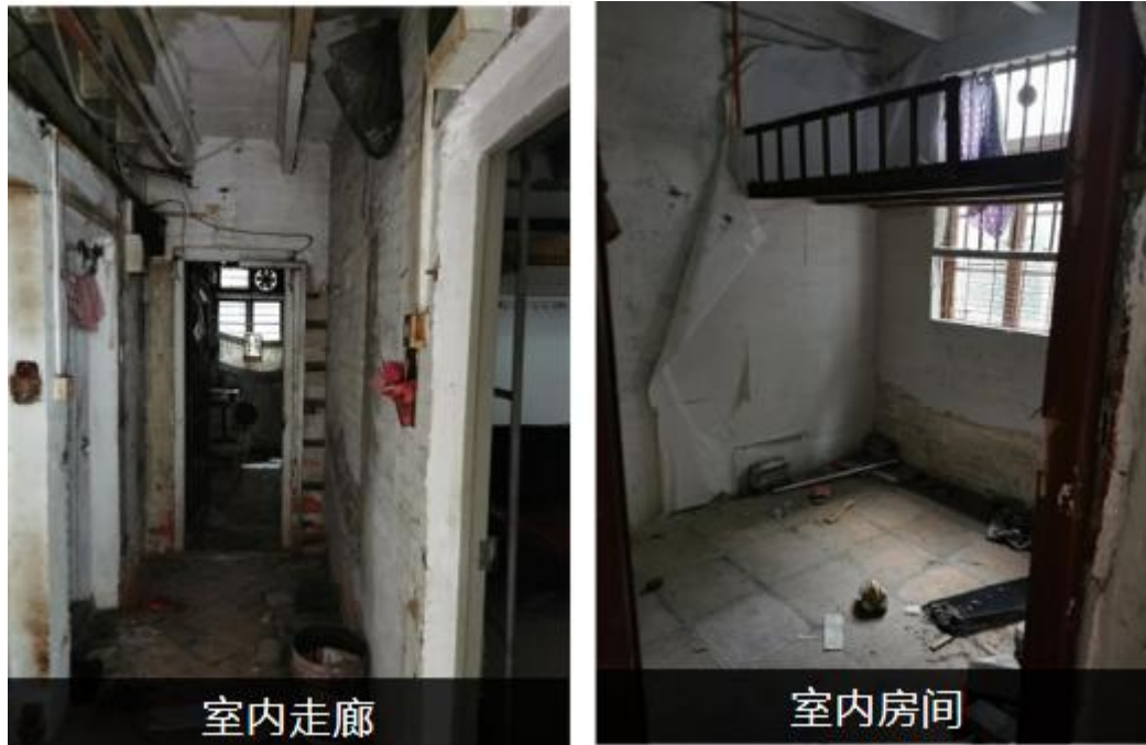
图 3-1-18 中山四路 230 号建筑现状
