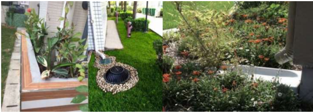
图 5.1.9-8 雨水断接实景图
