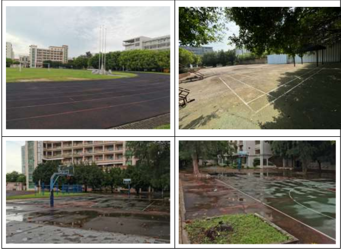
图 3.1-28 校区室外运动场地现状图片
