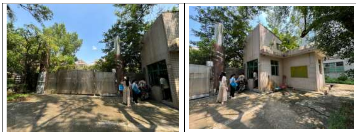
图 3.1-22 北门及门卫室现状图片
