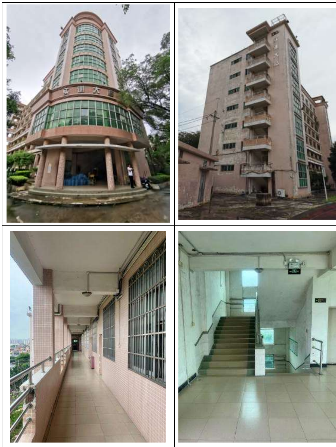
图 3.1-20 实训楼现状图片
