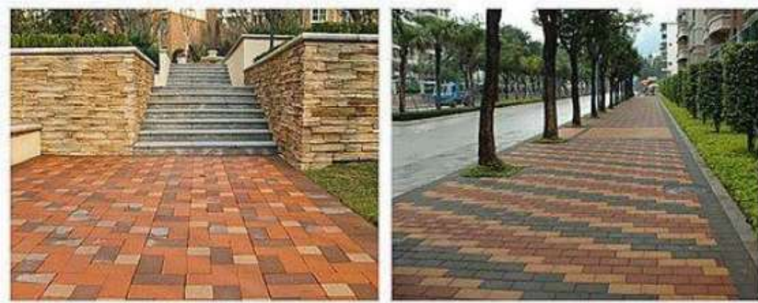
图 5.1.9-2 透水铺装实景图
