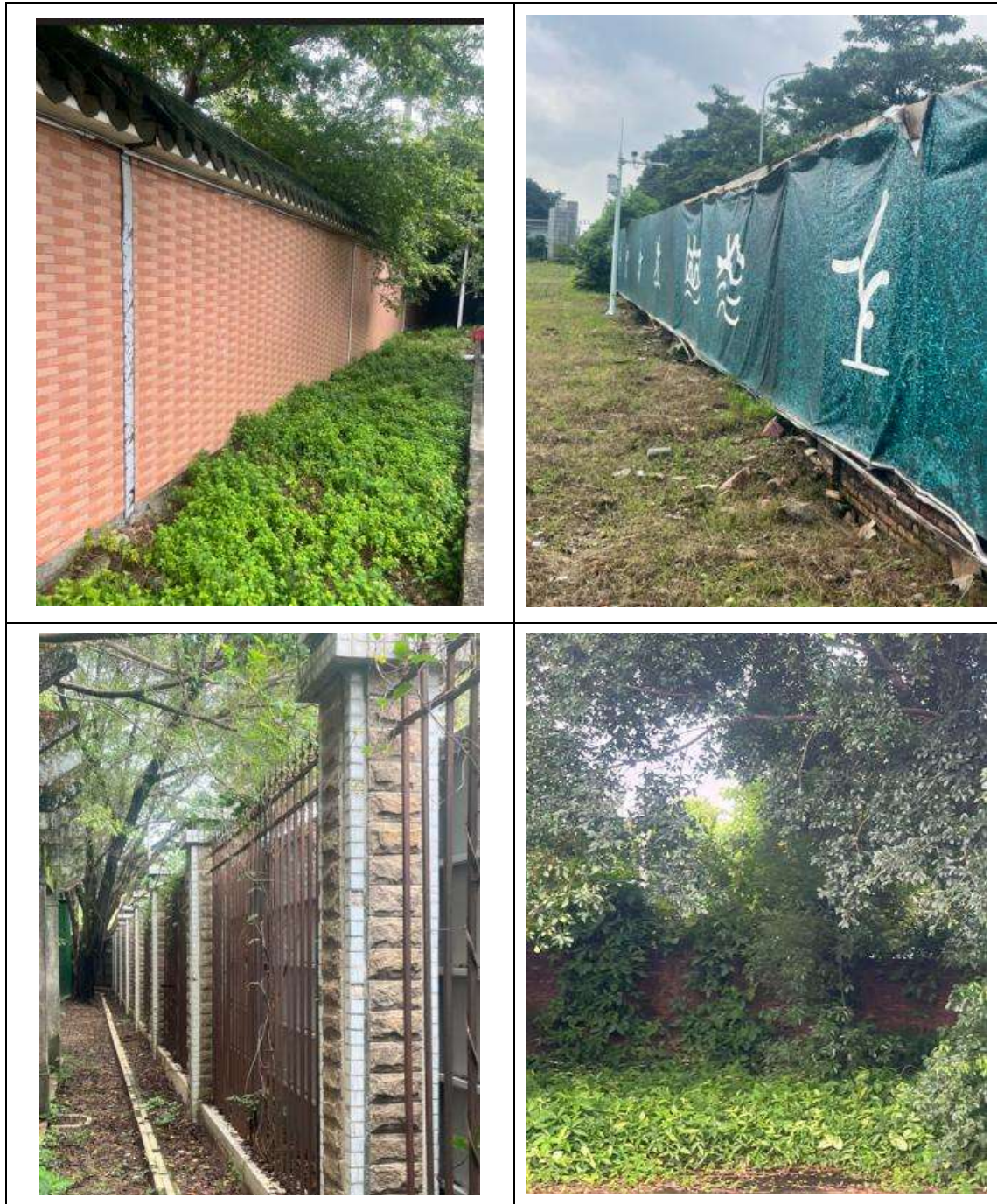
图 3.1-29 校区围墙现状图片
