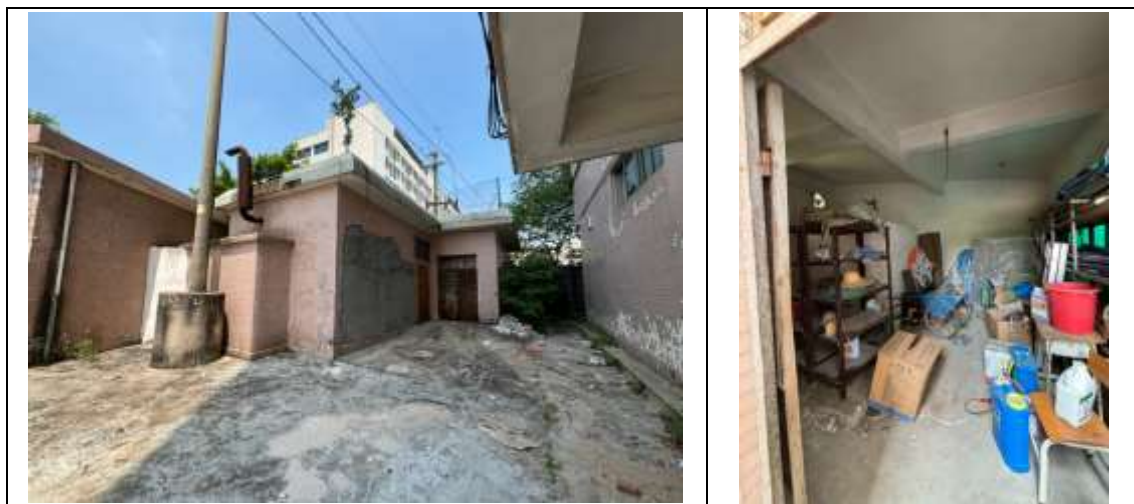
3.1-25 水表房现状图片
