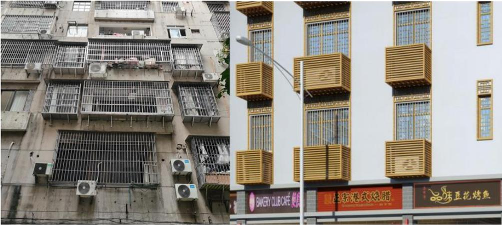
图5.1-20 空调机位改造意向图
