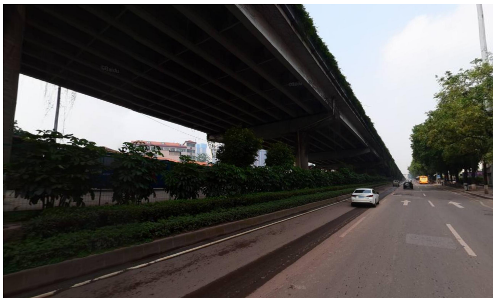
图 8-1 鹤洞大桥底现状
