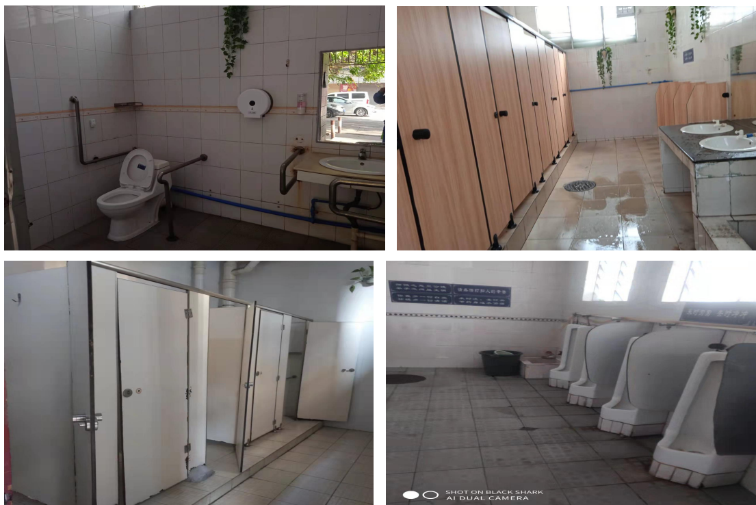
图 4-4 荔湾区环卫公厕现状
