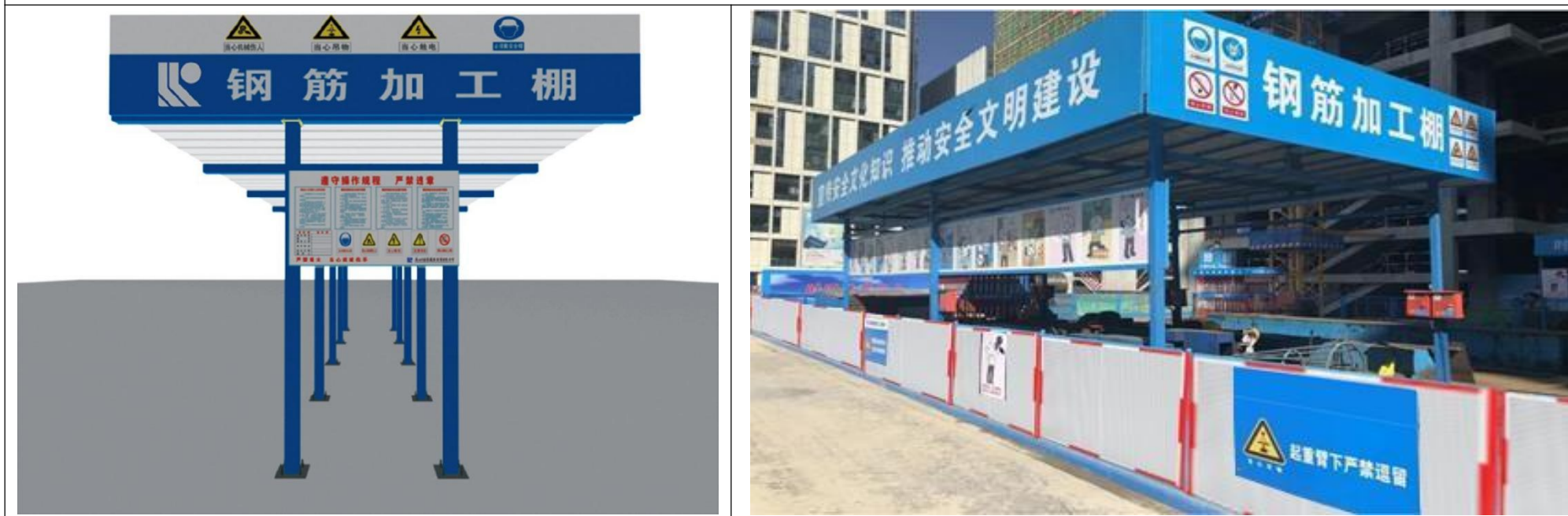
钢筋防护棚示意图
