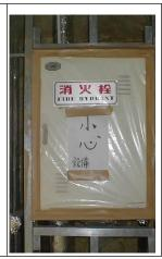
电气安装施工时,严禁对土建结构造的变坏,对粗装修面上的成变动应先征得土建技术。员的同意,在精装修必,可能可能是有效措施防止的。实现有效措施防止的领域,是可能受到的损坏和。如右图所示:
