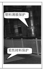
电缆敷设应在土建吊顶、精装修工程开始前进行,防止电缆施工对吊顶、装饰面层的破坏
